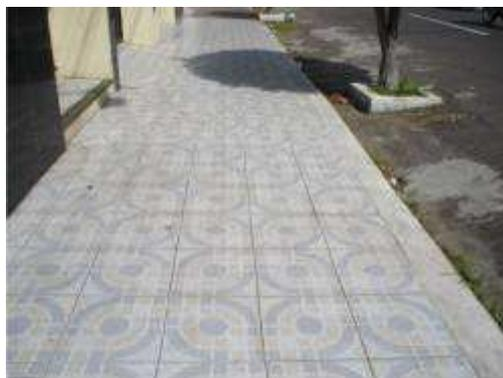
Foto: despadronização dos acabamentos dos passeios: cimentado e piso cerâmico.
