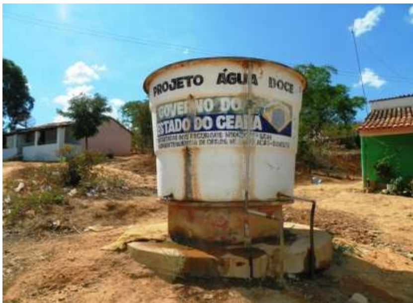
Figura 5.12 – Reservatório elevado de 5 m 3 que atende o sítio Tabuleiro (5 imóveis), no município de Altaneira.
