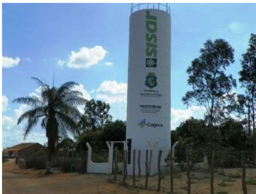
Figura 5.11 – Reservatório elevado de 30 \text{ m}^3 que atende os sítios Tabuleiro e Córrego, no município de Altaneira.
