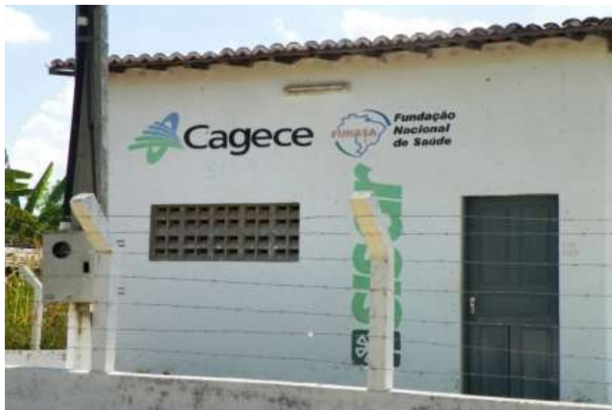
Figura 5.10 – Poço tubular ( Q = 4,1 \text{ m}^3/\text{h} ) que atende a localidade de Tabuleiro do Baé, compreendida pelos sítios Tabuleiro, Córrego, Taboquinha e Taboca, no município de Altaneira.
