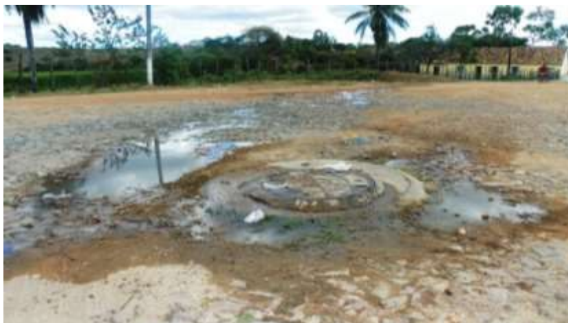
Figura 5.2 – Vista superior de poço de visita que compõe a rede de esgotamento sanitário da sede de Altaneira.
