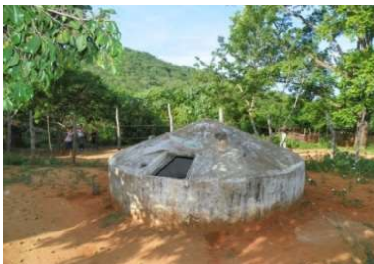
Figura 5.13 – Exemplo de cisterna utilizada no abastecimento de água de comunidades dispersas no município de Altaneira.
