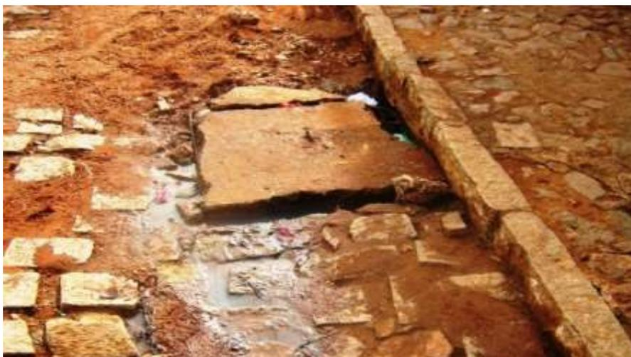
**Figura 7.36** – Caixa de visita da rede coletora de esgotos do distrito de São Romão.
