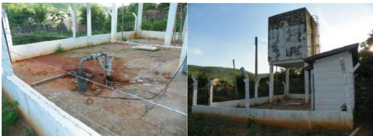
**Figura 7.19** – Vista do poço tubular (Q = 7,2 m<sup>3</sup>/h) e reservatório elevado de 30 m<sup>3</sup>, responsável pela distribuição de água da zona urbana do distrito de São Romão, na sede de Altaneira.
