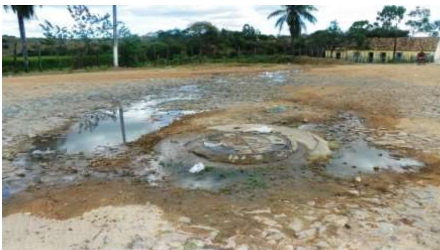
**Figura 7.30** – Vista superior de poço de visita que compõe a rede de esgotamento sanitário da sede de Altaneira.
