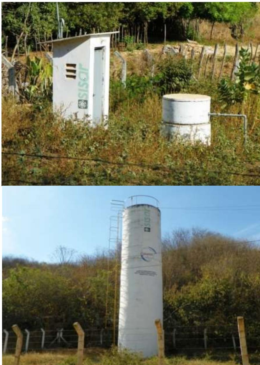
**Figura 7.21** – Poço tubular ( $Q = 5,3 \text{ m}^3/\text{h}$ ) e reservatório elevado de  $30 \text{ m}^3$  que atende a localidade de Bananeira, distrito de São Romão, no município de Altaneira. Fonte: Consórcio DGH-Cariri (2011).
