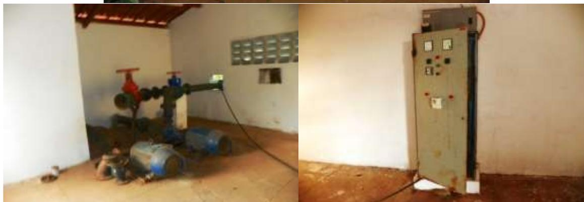
**Figura 7.5** – Vista do reservatório apoiado RAP-02 de 100 m<sup>3</sup>, e da estação elevatória de água bruta EE-03 e respectivo quadro de comando, do SAA da sede de Altaneira.
