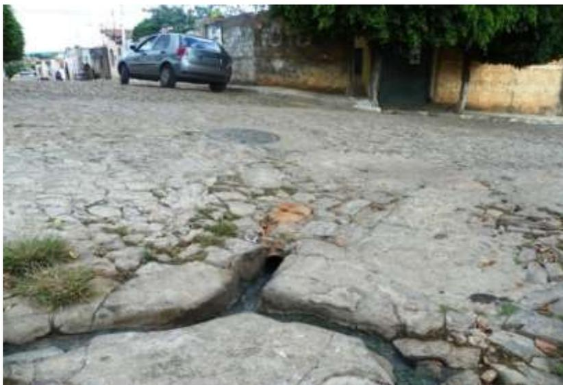
**Figura 7.34** – Lançamento de esgoto a céu aberto na sede de Altaneira.
