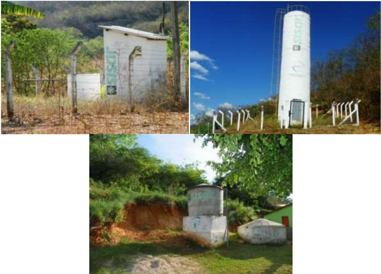
**Figura 7.20** – Poço tubular ( $Q = 4,1 \text{ m}^3/\text{h}$ ) e reservatórios elevados de  $30 \text{ m}^3$  (atende 195 imóveis) e  $5 \text{ m}^3$  (atende 16 imóveis) da localidade de Cachimbo, distrito de São Romão, no município de Altaneira.
