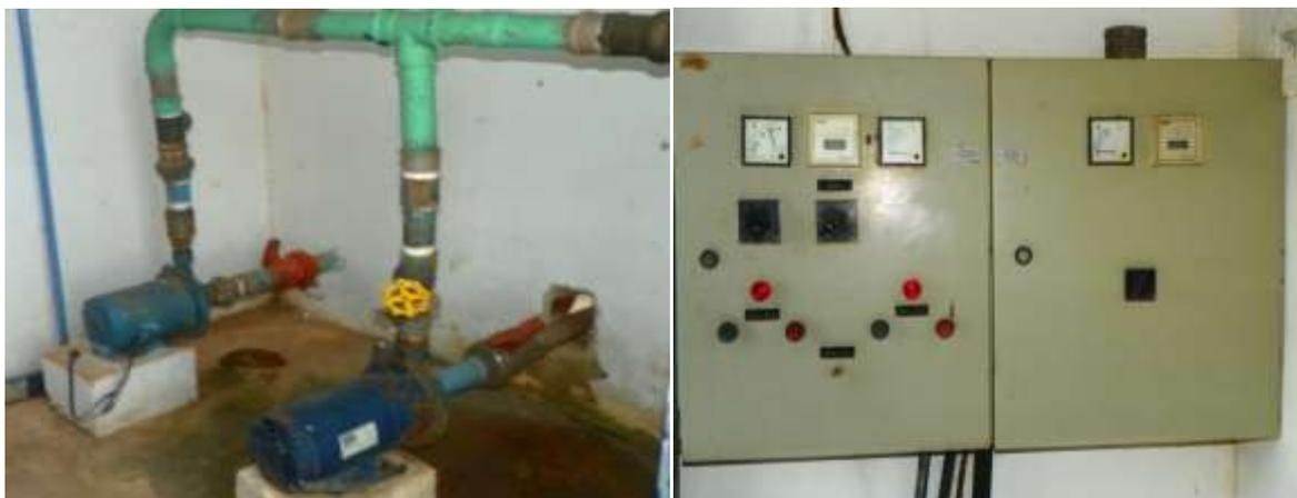
**Figura 7.11** – Vista do estado de conservação da EE-04 e EE-05 e respectivos quadros de comando localizados na área da ETA da sede de Altaneira.
