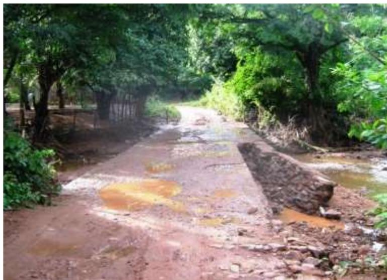
**Figura 7.57** – Erosão de via na localidade de Bananeira.
