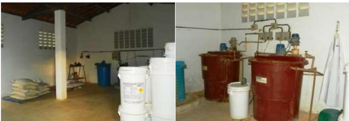
**Figura 7.8** – Vista da armazenagem de produtos químicos e tanques de preparo de produtos químicos e bombas dosadoras localizadas na Casa de Química da sede de Altaneira.
