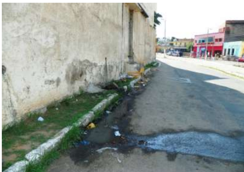
Figura 5.4 – Extravasamento no poço de visita localizado na Avenida José Alves de Figueiredo – Centro, sede do Crato.
