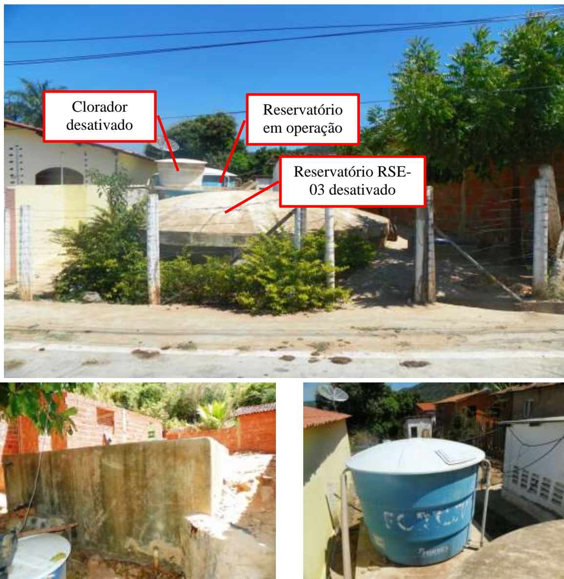
Figura 5.5 – Vista da unidade da SAAEC na Rua José Horácio Pequeno fonte (a), RSE-04 de reunião/distribuição de 50 m 3 localizado na parte alta do distrito na Rua José Horácio Pequeno (b) e Reservatório apoiado em fibra de 10 m 3 localizado na Unidade SAAEC (c) que fazem parte do sistema do distrito de Belmonte, município do Crato, de responsabilidade da SAAEC.
