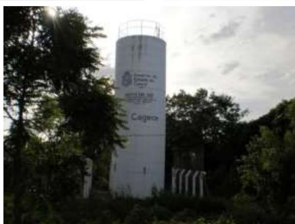
**Figura 7.97** – Vista do poço tubular (Q desconhecido) e REL de 20 m<sup>3</sup> que fazem parte do sistema da localidade de Cachoeira dos Gonçalves, município do Crato, de responsabilidade do SISAR.
