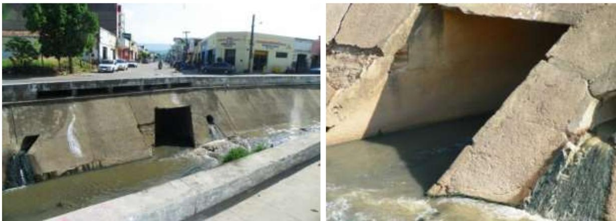
**Figura 7.112** – Lançamento de esgoto a céu aberto que chegam ao canal do rio Granjeiro por meio de galerias, sede do Crato.
