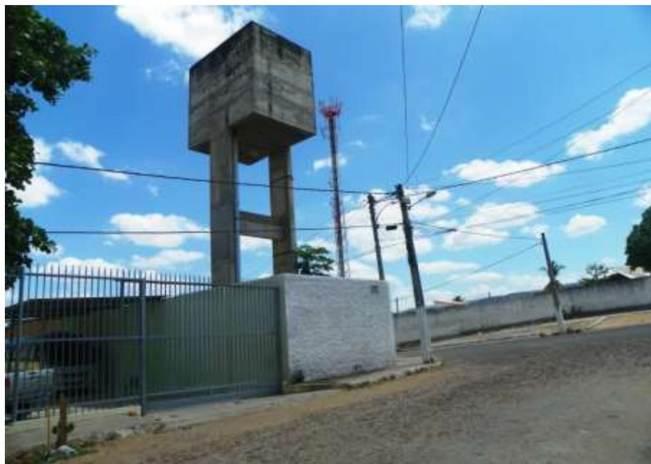
**Figura 7.20** – Vista do Reservatório REL Seminário (50m<sup>3</sup>), responsável pela distribuição de água para sede do Crato.
