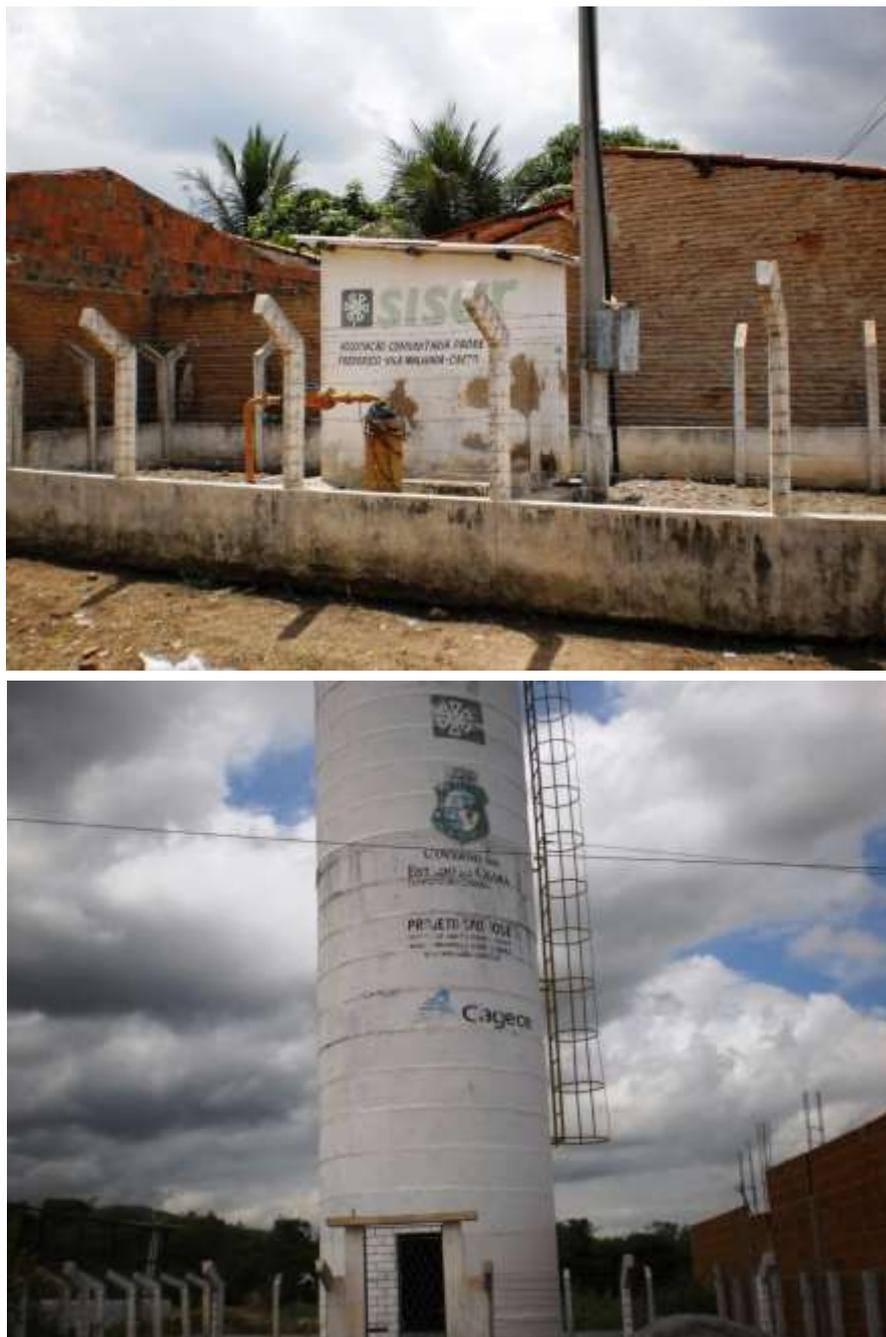
**Figura 7.55** – Vista do poço tubular ( $Q = 14,0 \text{ m}^3/\text{h}$ ) e REL de  $30 \text{ m}^3$  que fazem parte do sistema da localidade de Vila Malhada, município do Crato, de responsabilidade do SISAR.
