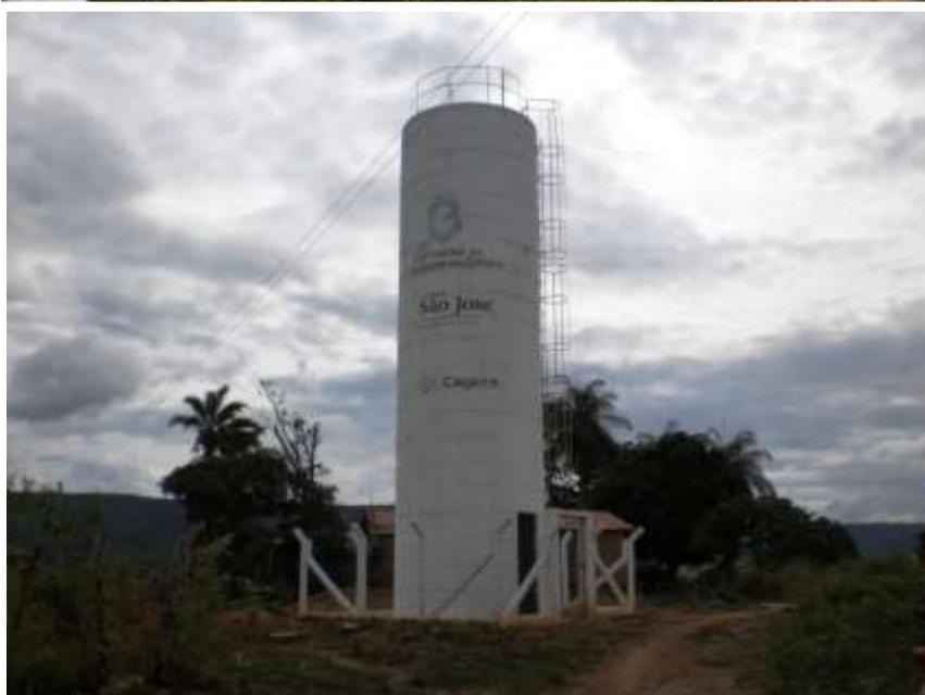
**Figura 7.94** – Vista do poço tubular ( $Q = 6,6 \text{ m}^3/\text{h}$ ) e REL de  $28 \text{ m}^3$  que fazem parte do sistema da localidade de Currais de Baixo, município do Crato, de responsabilidade do SISAR.
