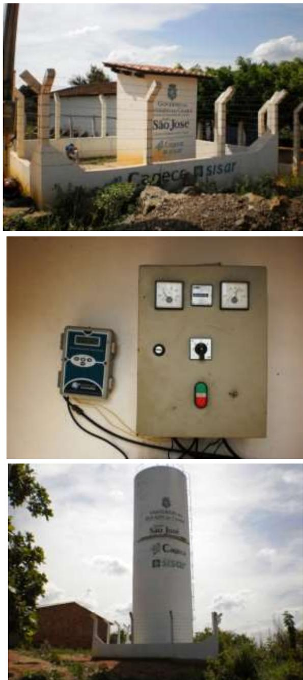
**Figura 7.100** – Vista do poço tubular ( $Q = 5,2 \text{ m}^3/\text{h}$ ) e REL de  $28 \text{ m}^3$  que fazem parte do sistema da localidade de Sítio Bréa, município do Crato, de responsabilidade do SAR.
