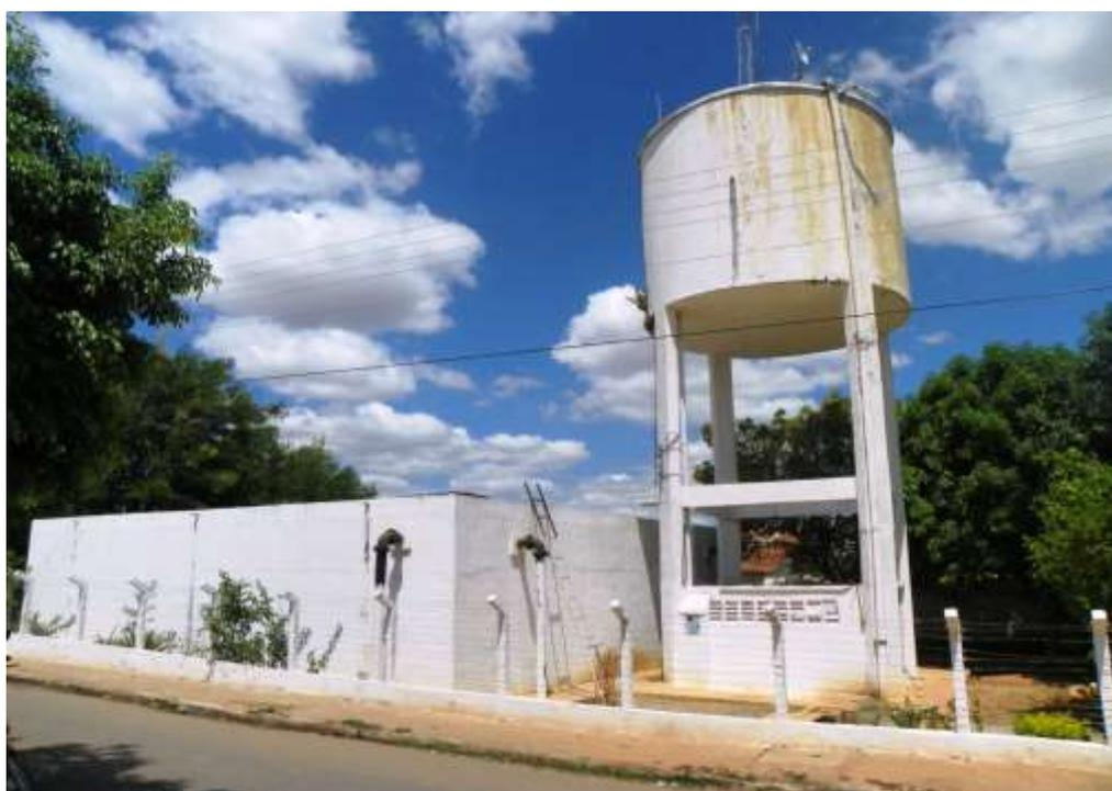
**Figura 7.22** – Vista do reservatório RAP Muriti (500m<sup>3</sup>), responsável pela distribuição de água para sede do Crato.
