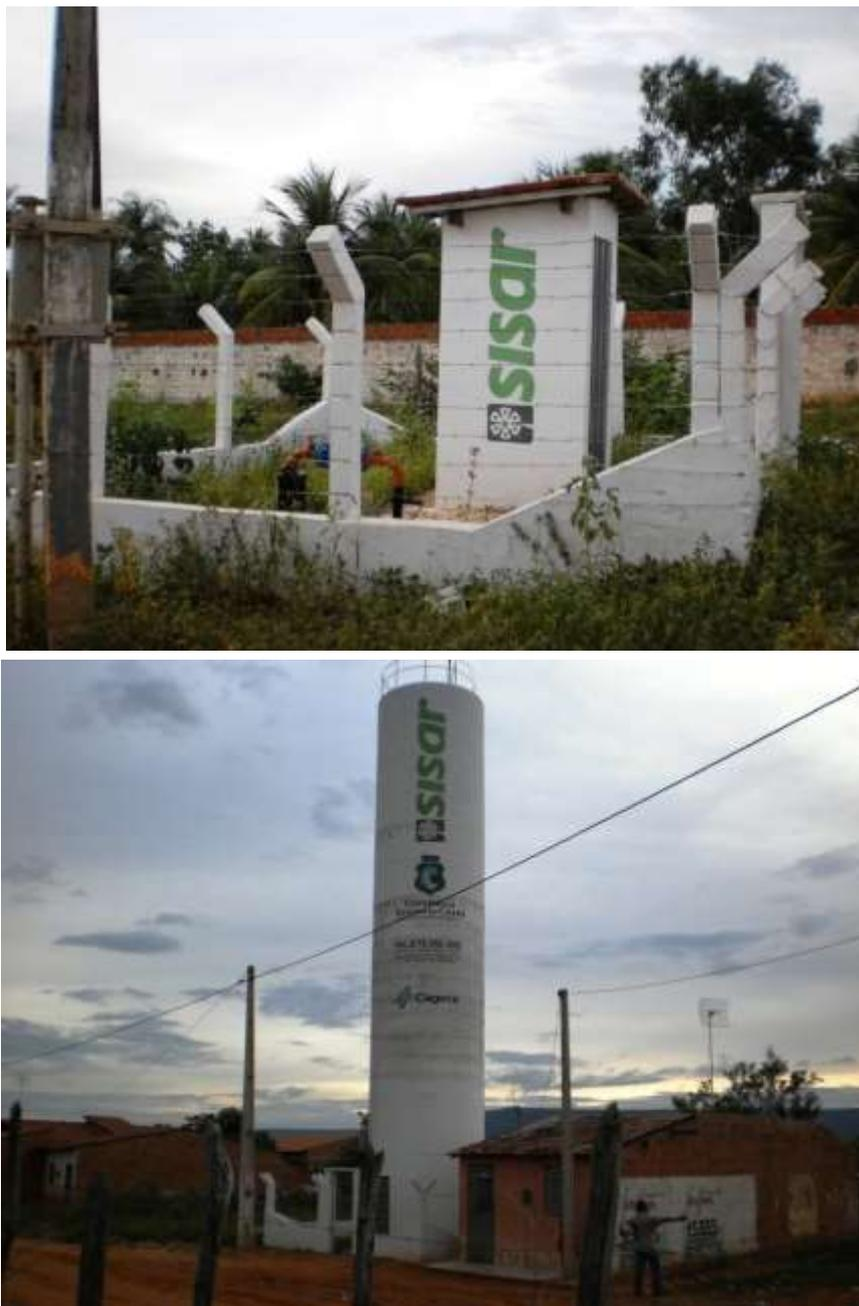
**Figura 7.85** – Vista do poço tubular ( $Q = 5,1 \text{ m}^3/\text{h}$ ) e REL de  $30 \text{ m}^3$  que fazem parte do sistema da localidade de Baixio dos Robertos, município do Crato, de responsabilidade do SISAR.
