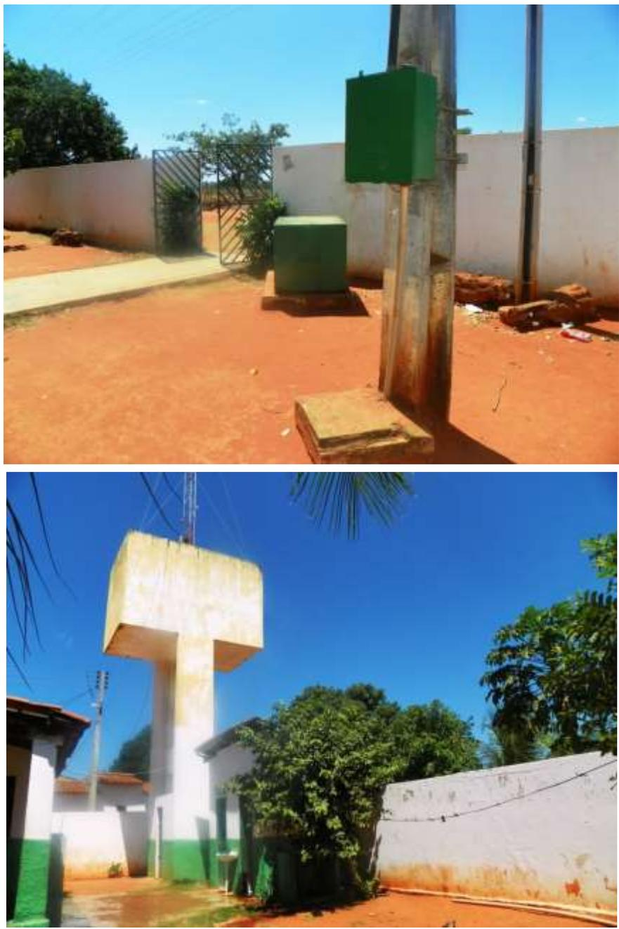
**Figura 7.43** – Vista do poço tubular ( $Q = 5,1 \text{ m}^3/\text{h}$ ) e do REL de  $50 \text{ m}^3$  que fazem parte do sistema do distrito de Santa Rosa, município do Crato, de responsabilidade da SAAEC.
