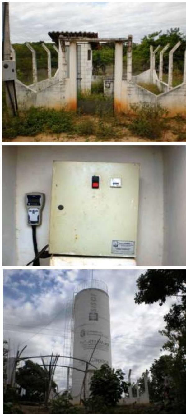
**Figura 7.61** – Vista do poço tubular ( $Q = 6,4 \text{ m}^3/\text{h}$ ) e REL de  $25 \text{ m}^3$  que fazem parte do sistema da localidade de Sítio Alegre, município do Crato, de responsabilidade do SISAR.
