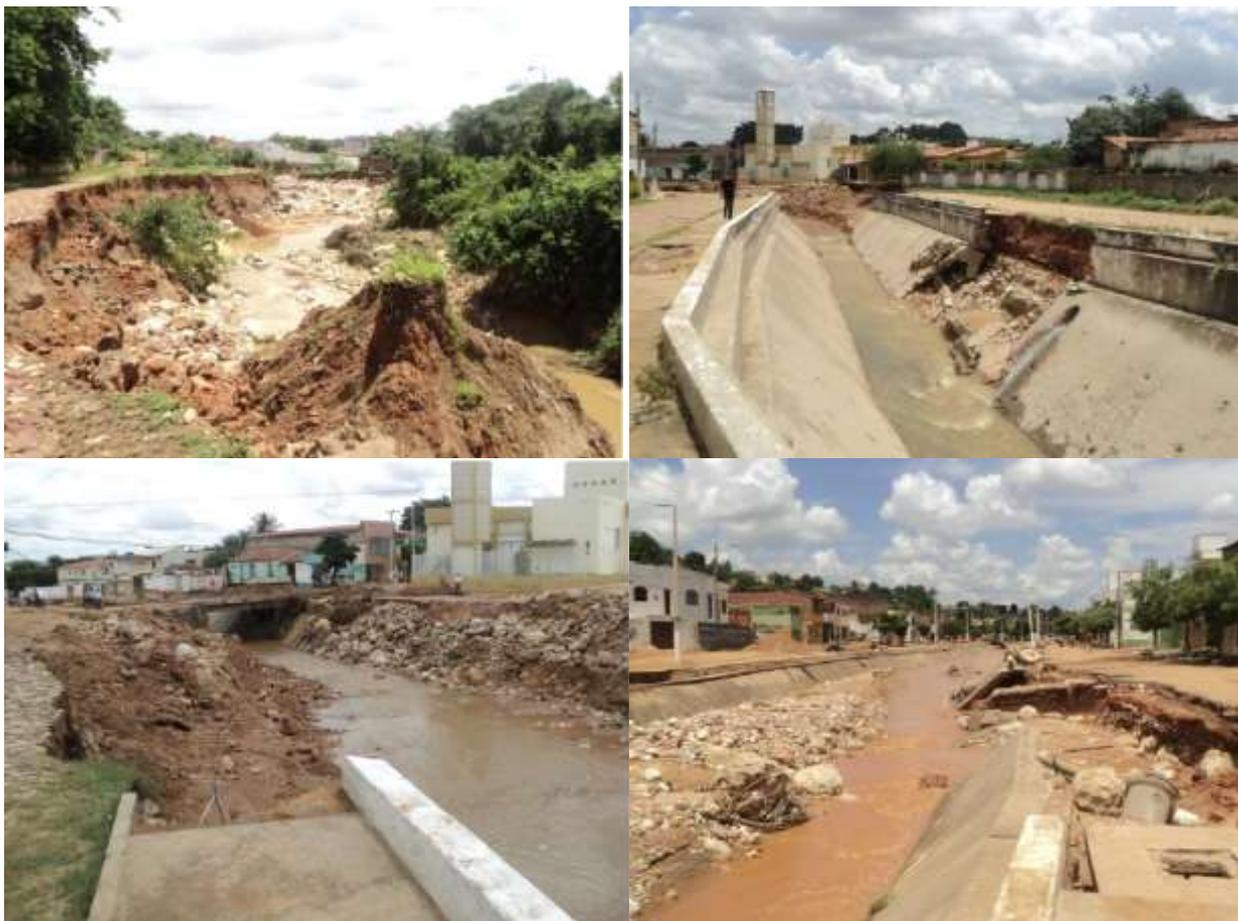
**Figura 4.15** – Erosão na calha natural do rio Granjeiro e trechos canalizados mais afetados com a enxurrada de 2011.
