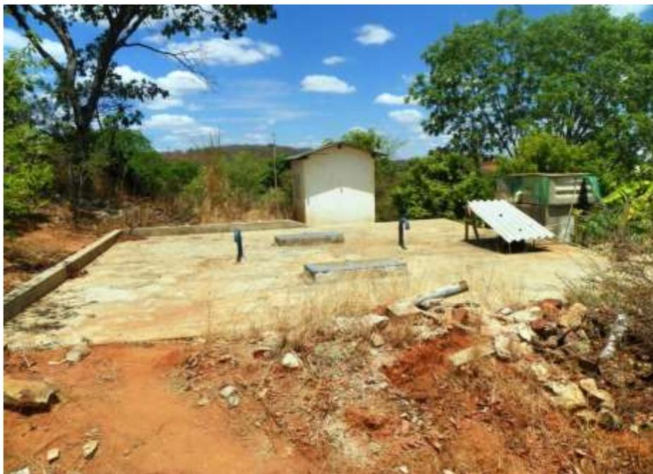
**Figura 7.19** – Vista do Reservatório RSE Granjeiro (400m<sup>3</sup>), responsável pela distribuição de água para sede do Crato.
