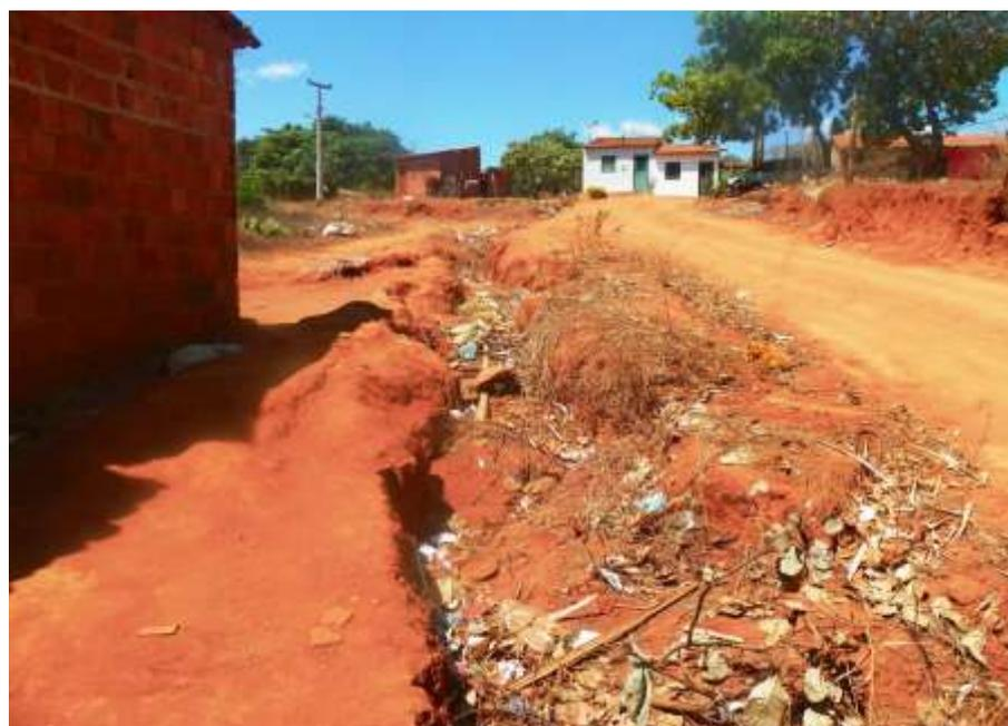
**Figura 7.173** – Erosão de via e formação de voçoroca – Distrito de Santa Rosa.
