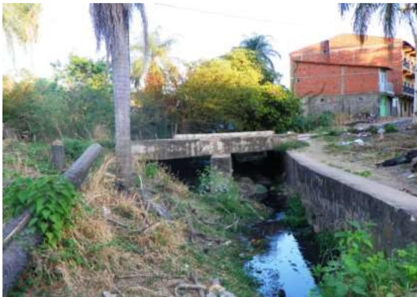
**Figura 7.149** – Passagem molhada em péssimo estado de conservação, com risco de colapso – Rua Gal. Joaquim P. Monteiro.
