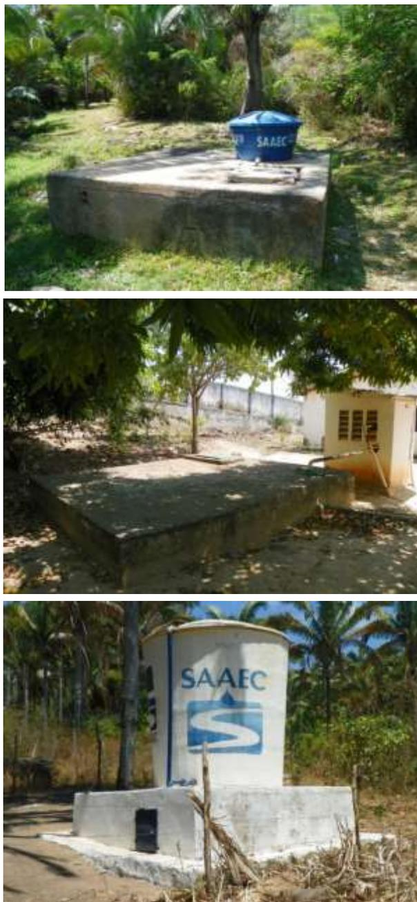
**Figura 7.41** – Vista do fonte ( $Q = 4,8 \text{ m}^3/\text{h}$ ), reservatório semienterrado RSE de  $50 \text{ m}^3$  e do REL de  $10 \text{ m}^3$  que fazem parte do sistema do distrito de Santa Fé, município do Crato, de responsabilidade da SAAEC.
