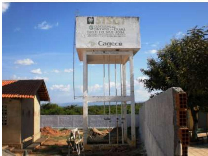
**Figura 7.88** – Vista do poço tubular ( $Q = 5,8 \text{ m}^3/\text{h}$ ) e REL de  $35 \text{ m}^3$  que fazem parte do sistema da localidade de Vila São Francisco, município do Crato, de responsabilidade do SISAR.
