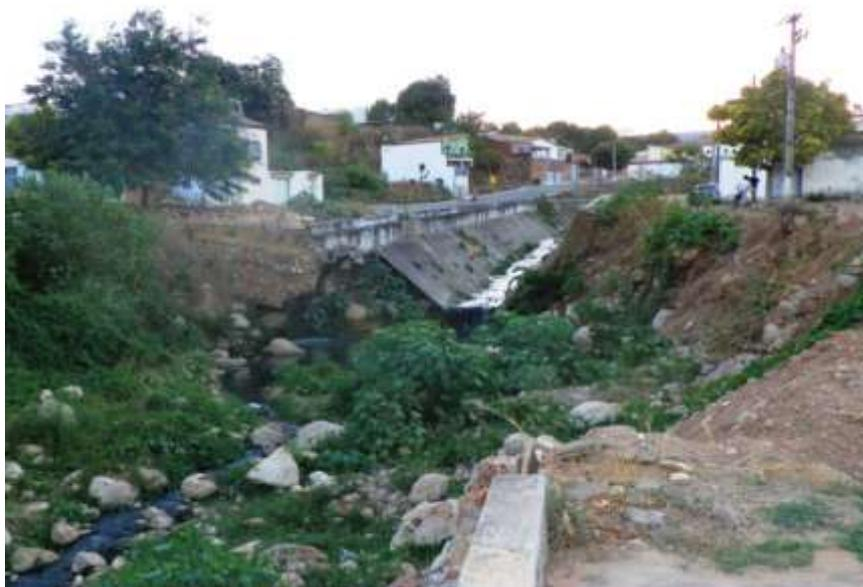
**Figura 7.155** – Final do Canal do Granjeiro – Rua Manoel Almino de Lima/Av. José Alves de Figueiredo, com destaque para a existência de processos erosivos.
