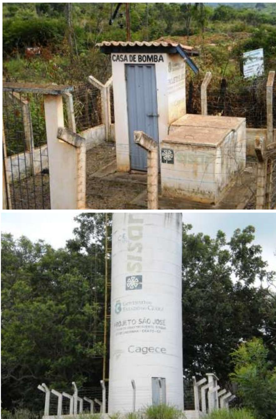
**Figura 7.58** – Vista do poço tubular ( $Q = 7,2 \text{ m}^3/\text{h}$ ) e REL de  $28 \text{ m}^3$  que fazem parte do sistema da localidade de Lagoinha, município do Crato, de responsabilidade do SISAR.
