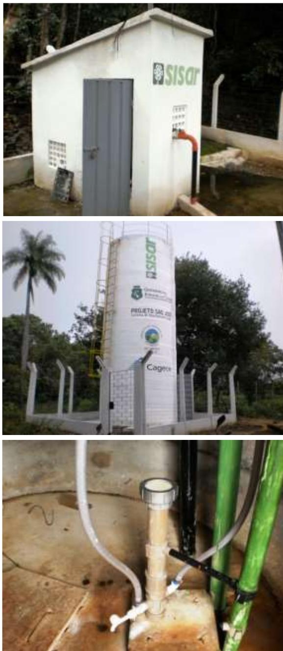
**Figura 7.79** – Vista do poço tubular ( $Q = 2,8 \text{ m}^3/\text{h}$ ) e REL de  $25 \text{ m}^3$  que fazem parte do sistema da localidade de Boa Vista, município do Crato, de responsabilidade do SISAR.
