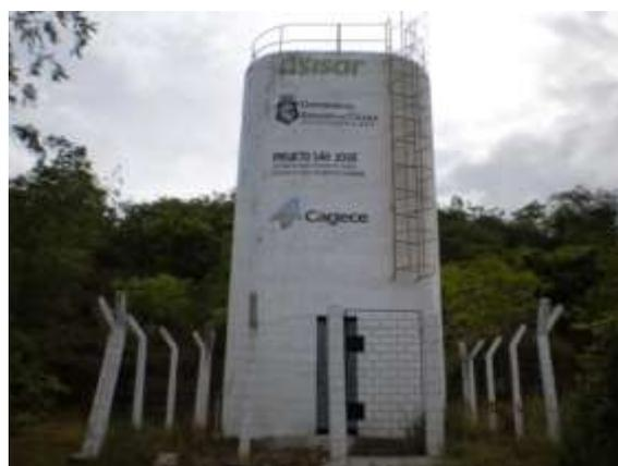
**Figura 7.46** – Vista do poço tubular ( $Q = 8,3 \text{ m}^3/\text{h}$ ) e REL de  $30 \text{ m}^3$  que fazem parte do sistema do distrito de Baixio das Palmeiras, município do Crato, de responsabilidade do SISAR.
