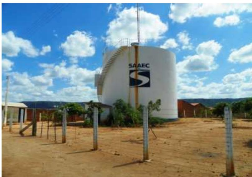
**Figura 7.18** – Vista do Reservatório RAP Sertãozinho (1000m<sup>3</sup>), responsável pela distribuição de água para sede do Crato.
