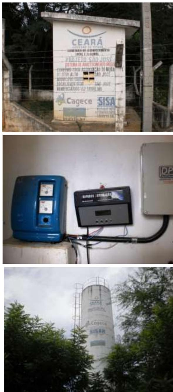
**Figura 7.70** – Vista do poço tubular ( $Q = 6,2 \text{ m}^3/\text{h}$ ) e REL de  $25 \text{ m}^3$  que fazem parte do sistema da localidade de São José, município do Crato, de responsabilidade do SISAR.
