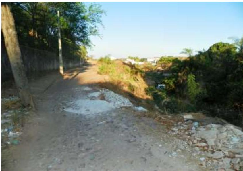
**Figura 7.153** – Erosão e assoreamento do Canal do Granjeiro – Rua Manoel Almino de Lima.
