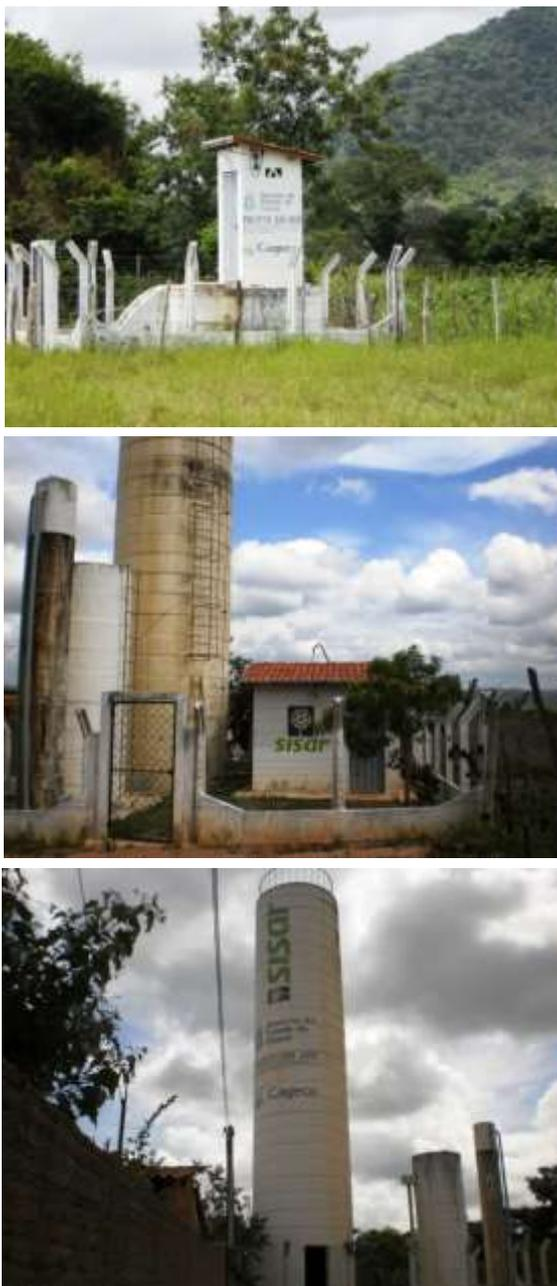
**Figura 7.64** – Vista do poço tubular ( $Q = 6,0 \text{ m}^3/\text{h}$ ) e REL de  $35 \text{ m}^3$  que fazem parte do sistema da localidade de Palmeirinha dos Britos, município do Crato, de responsabilidade do SISAR.
