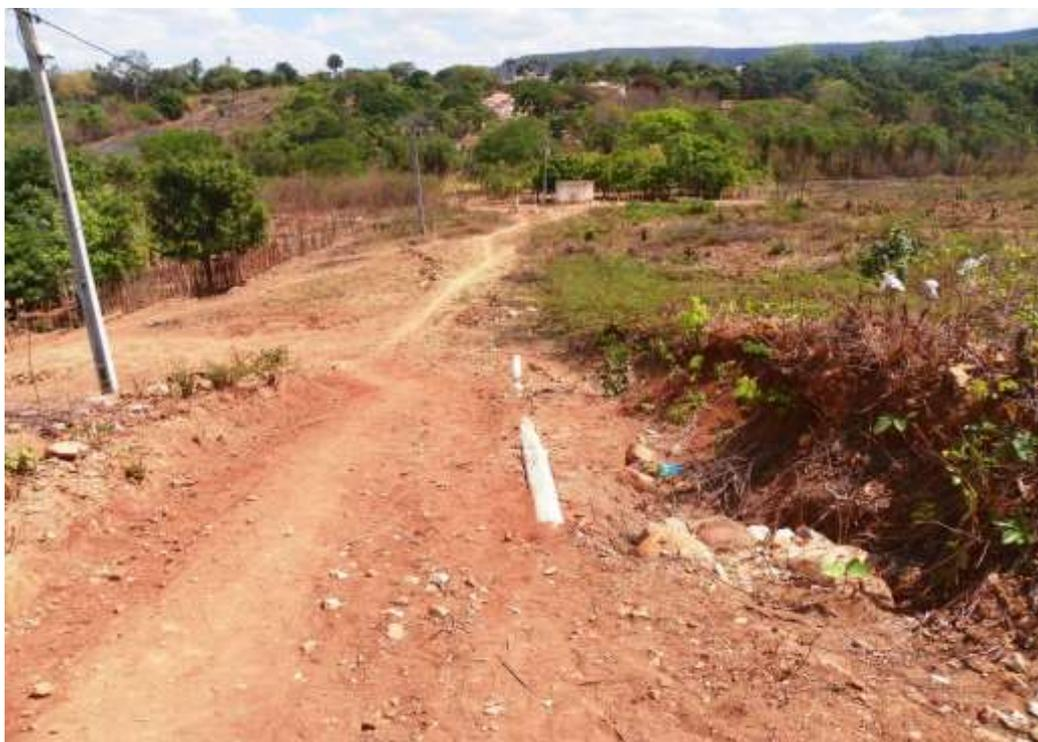
**Figura 7.16**–Vista da adutora que liga o poço Sertãozinho ao reservatório apoiado RAP Sertãozinho de 1000 m<sup>3</sup>, na sede do Crato.
