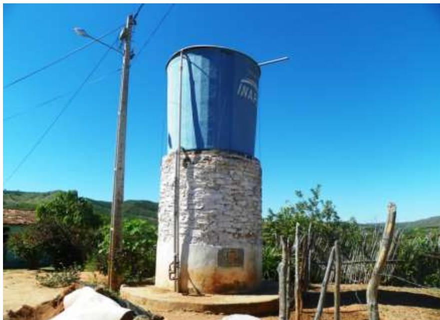
**Figura 7.32** – Vista do poço artesiano PA-02 e do reservatório elevado REL-03 de 10 m<sup>3</sup> que fazem parte do sistema do distrito de Dom Quintino, município do Crato, de responsabilidade da SAAEC.
