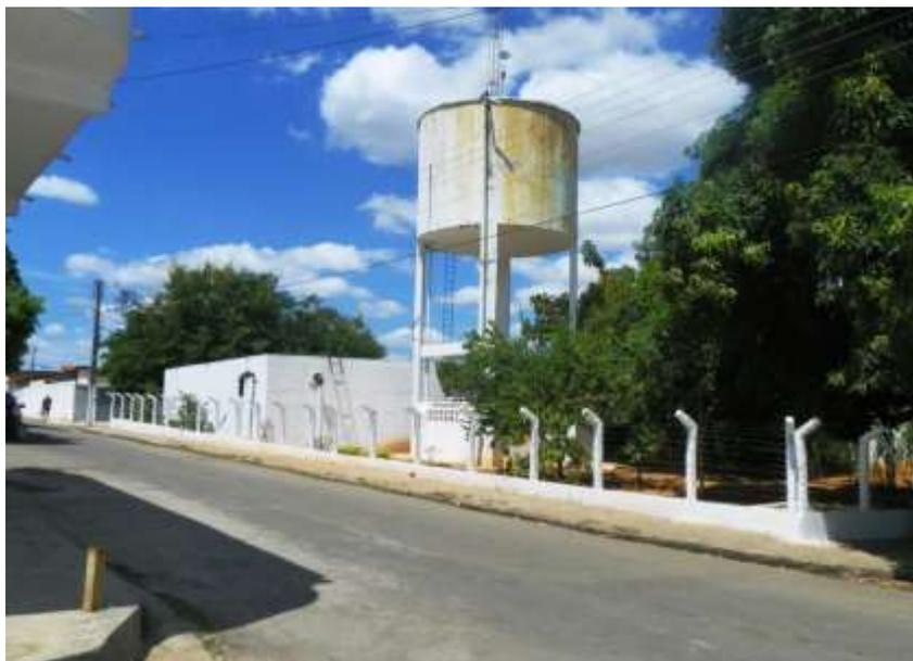
**Figura 7.21** – Vista dos Reservatórios RSE São Raimundo 1 (500m<sup>3</sup>) e do REL São Raimundo 2 (50m<sup>3</sup>), responsáveis pela distribuição de água para sede do Crato.
