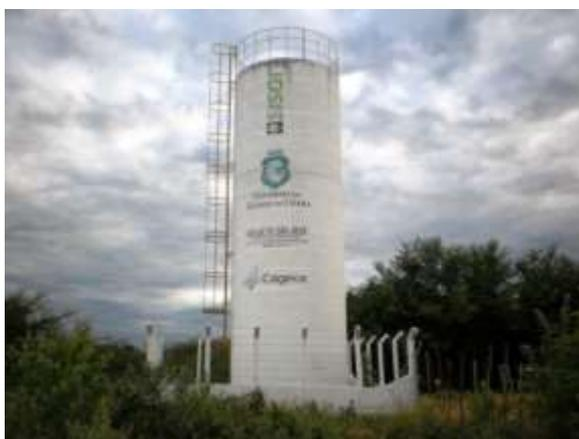
**Figura 7.67** – Vista do poço tubular ( $Q = 6,6 \text{ m}^3/\text{h}$ ) e REL de  $20 \text{ m}^3$  que fazem parte do sistema da localidade de Baixio Verde, município do Crato, de responsabilidade do SISAR.
