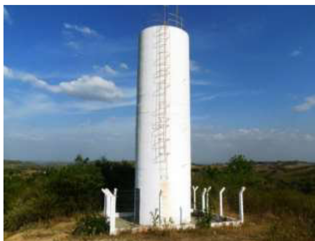
Figura 5.10 – Vista do reservatório elevado de 30 m 3 que atende ao sítio Taquari, no município de Jardim, de responsabilidade do SISAR.
