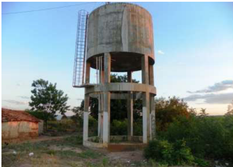
Figura 5.4 – Vista do reservatório elevado REL (50 m 3 ) de Corrente. Fonte: Consórcio DGH-Cariri (2011).
