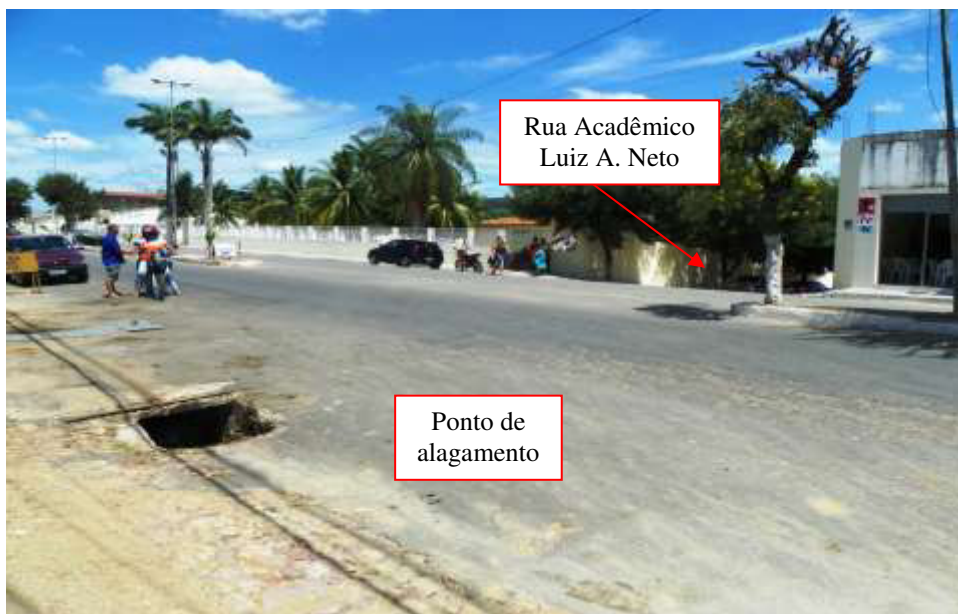
Figura 5.20 – Ponto de alagamento na Rua Wilson Roriz e Rua Acadêmico Luis Aires Neto.
