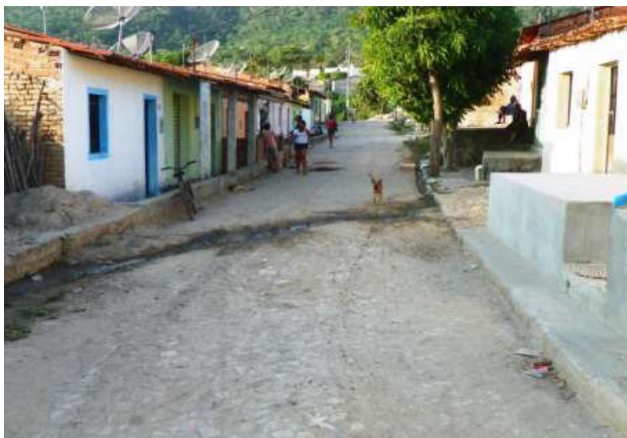
Figura 5.17 – Esgoto a céu aberto no distrito de Jardimirim. Fonte: Consórcio DGH-Cariri (2011).
