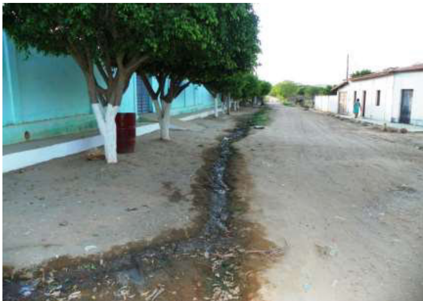
Figura 5.12 – Esgoto lançado a céu aberto na Rua Joaquim Pinheiro no distrito de Corrente.
