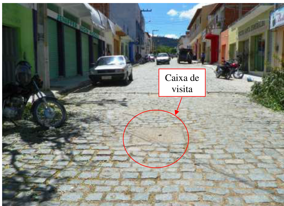
Figura 5.3 – Caixa de visita - Rua Cel. Teodomiro Sampaio na sede de Jardim. Fonte: Consórcio DGH-Cariri (2011).
