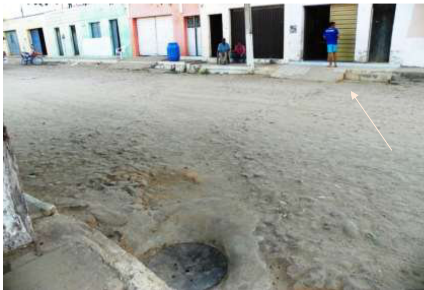
Figura 5.21 – Imagem mostrando a vista do Bueiro na Rua João Aquino Pinheiro. Fonte: Consórcio DGH-Cariri (2012).
