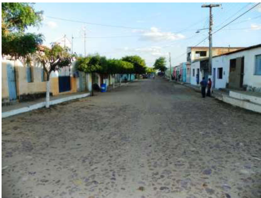
Figura 5.22 – Rua João Aquino Pinheiro – ponto de alagamento no distrito de Corrente. Fonte: Consórcio DGH-Cariri (2012).
