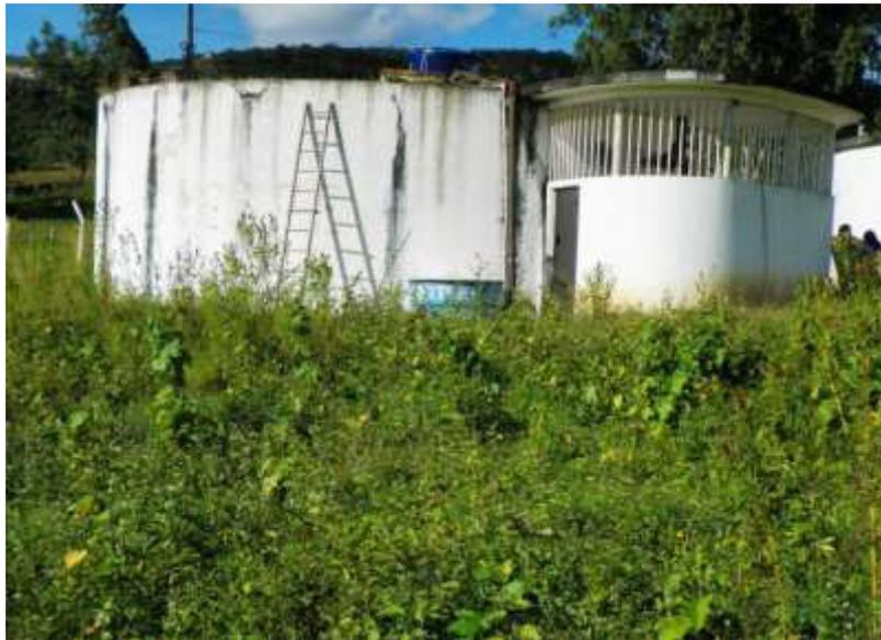
**Figura 7.7** – Reservatório apoiado RAP 1 (50 m<sup>3</sup>) onde é realizada a cloração.
