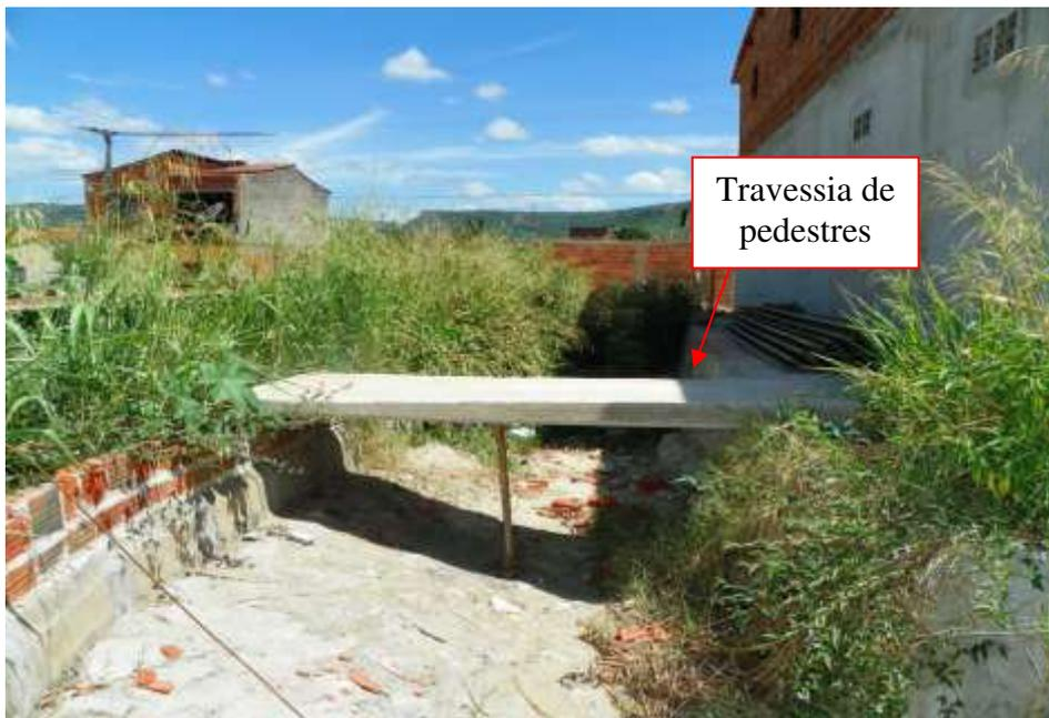
**Figura 7.68** – Ponte improvisada construída para a travessia de pedestres sobre o Riacho Barrocão.
