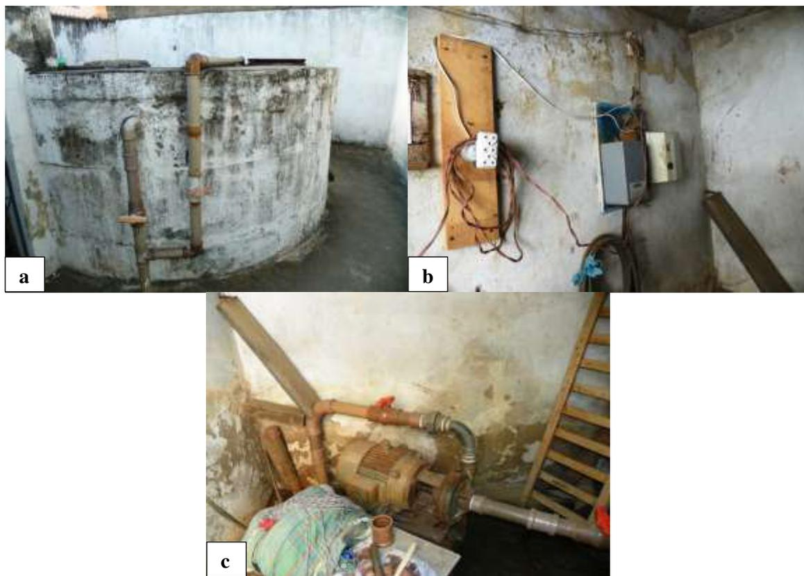
**Figura 7.11** – (a) RAP 3 (20 m<sup>3</sup>), (b) Instalações elétricas e (c) Bombas no bairro Vila Santa Terezinha na sede Jardim.
