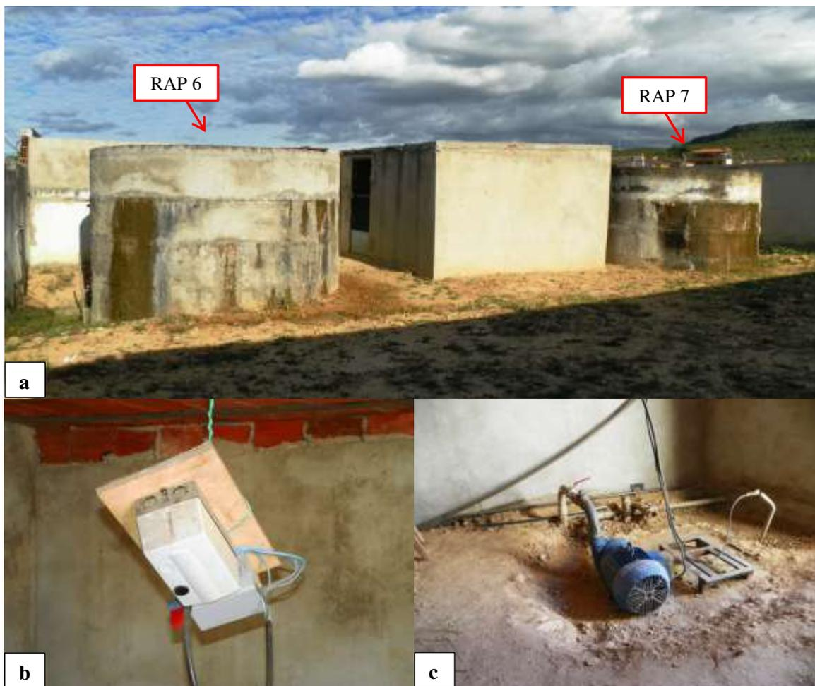
**Figura 7.13** – (a) RAP 6 (20 m<sup>3</sup>) e RAP 7 (20 m<sup>3</sup>), (b) instalações elétricas e (c) bombas no bairro COHAB 2 na sede de Jardim.
