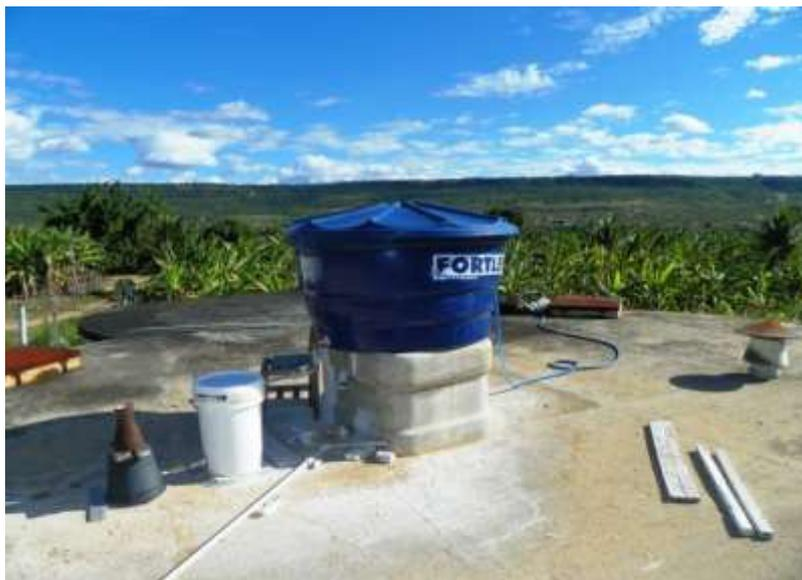
**Figura 7.9** – Caixa d’água (500 L) em cima do RAP 1 (50 m³) - Tratamento da água por cloração.
