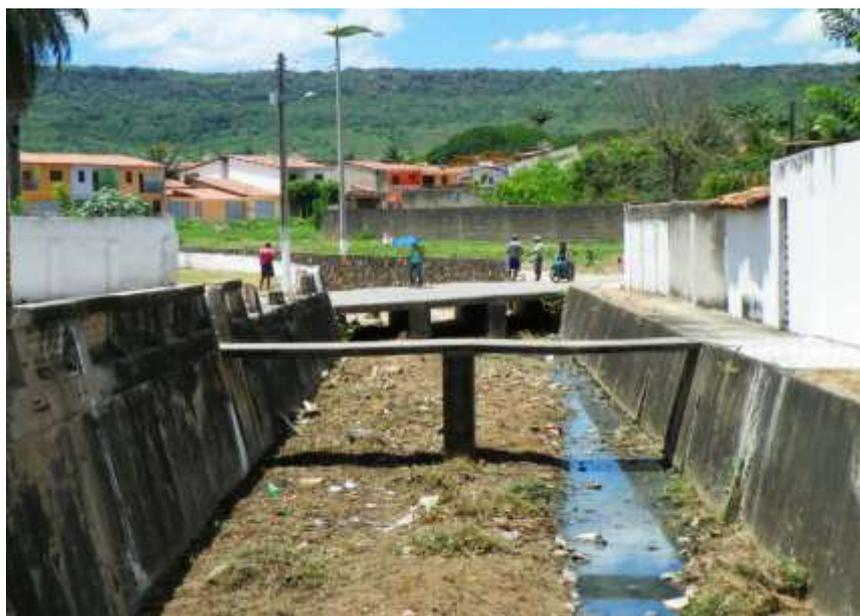
**Figura 7.75** – Assoreamento e presença de esgotos no canal do Riacho Jacundá.
