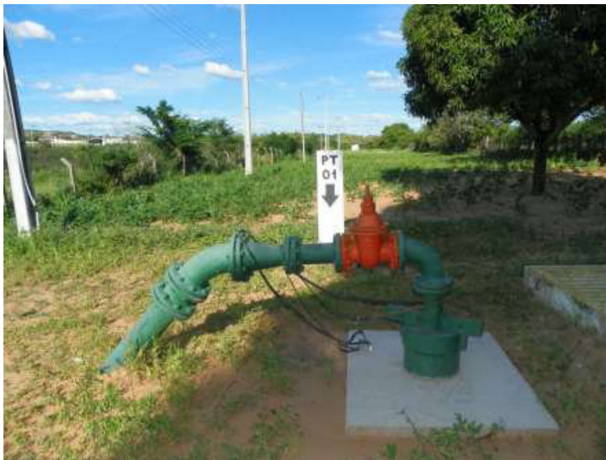
Figura 5.1 – Vista do poço tubular PT-01 ( Q = 44,6 \text{ m}^3/\text{h} ) localizado dentro da ETA que faz parte do manancial da sede de Missão Velha.
