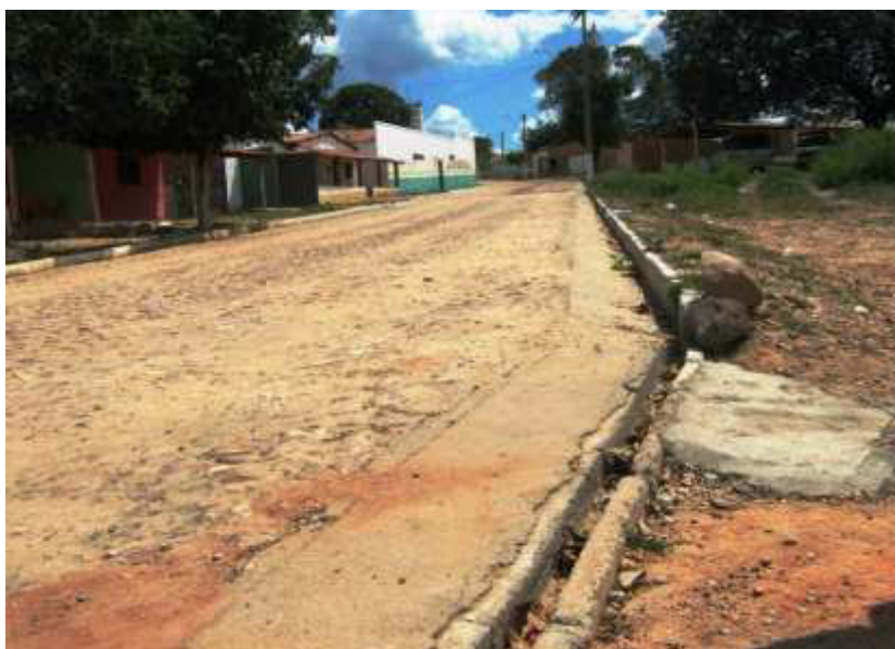
Figura 5.24 – Vista de sarjeta precária na Rua Principal do distrito de Quimami (ponto de alagamento).
