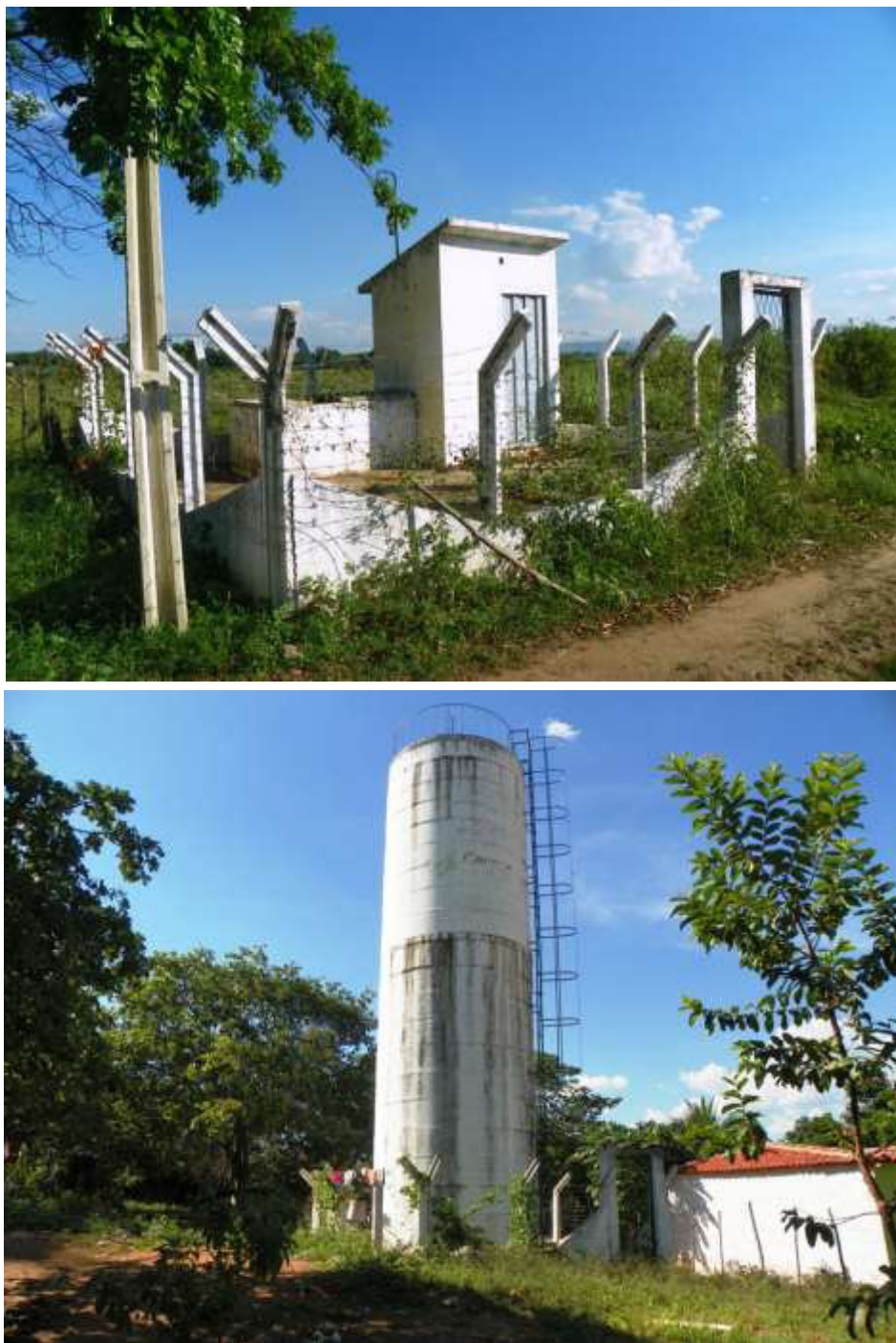
Figura 7.40 – Vista do poço tubular ( Q = 6,3 \text{ m}^3/\text{h} ) (a) e REL de 25 \text{ m}^3 (b) que atendem à localidade de Santa Tereza, no município de Missão Velha, de responsabilidade do SISAR.
