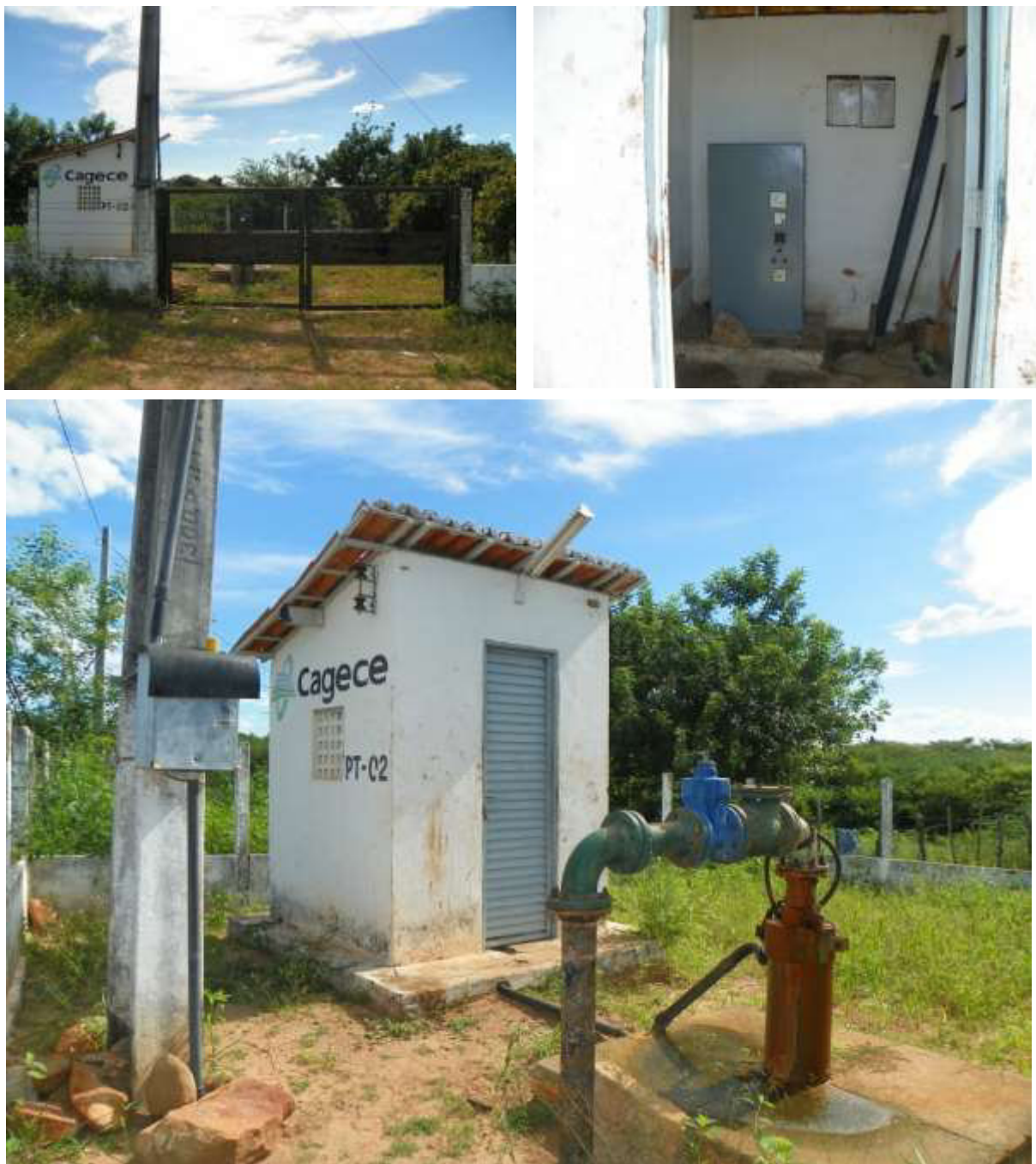
Figura 7.3 – Vista do poço tubular PT-02 ( Q = 80 \text{ m}^3/\text{h} ) que faz parte do manancial da sede de Missão Velha, com destaque para o quadro de comando e controle do acesso.
