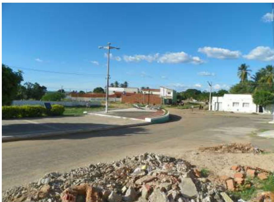
Figura 7.108 – Ponto de alagamento na Av. Luiz Jucá Arrais Maia. Fonte: Consórcio DGH-Cariri (2012).
