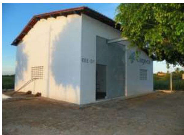
Figura 7.78 – Área da Estação Elevatória de Esgotos (EEE-01) da sede de Missão Velha e interligação do prédio com o tratamento preliminar.
