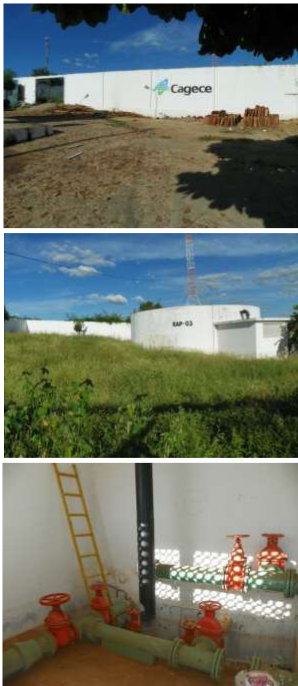
Figura 7.15 – Vista da área e detalhes da tubulação de entrada e saída do reservatório apoiado RAP-03 (500m 3 ), responsável pela distribuição de água para sede de Missão Velha.
