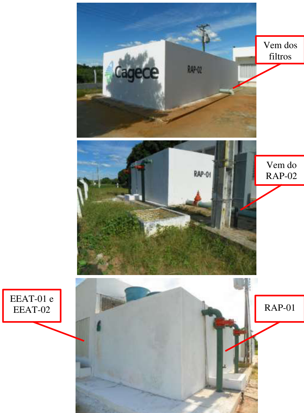
Figura 7.13 – Vista das entradas e saídas nos RAP-01 (75 m 3 ) e RAP-02 (150 m 3 ) e da ligação da EEAT-01 (RAP-03) e EEAT-02 (lavagem dos filtros).
