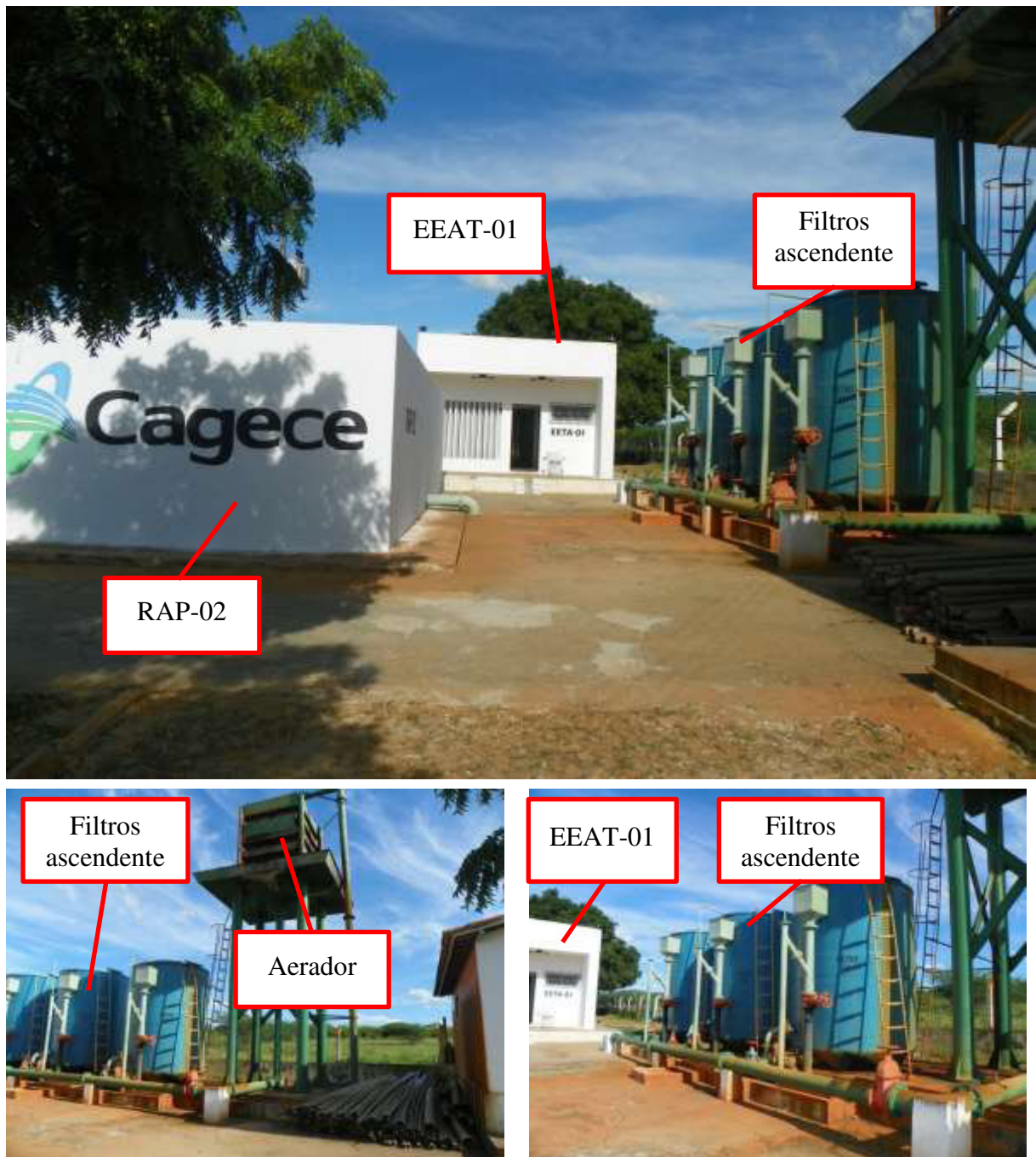
Figura 7.8 – Detalhes da Estação de Tratamento de Água (ETA) da sede de Missão Velha.
