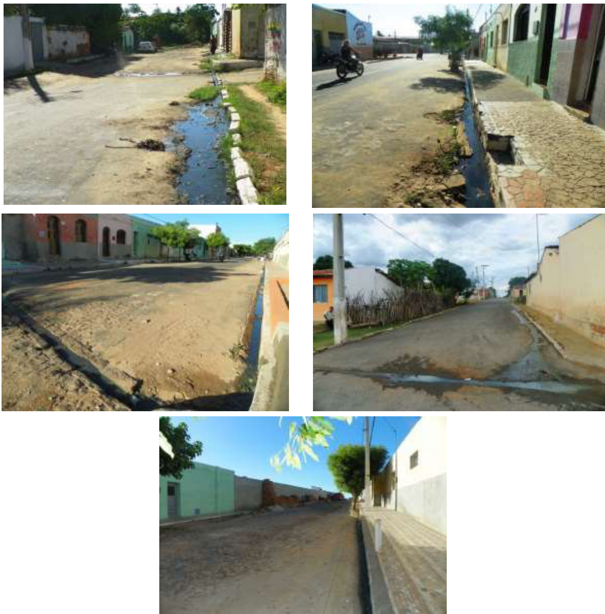
Figura 7.75 – Esgoto a céu aberto nas Ruas Vicente Fachine (a), 11 de julho (b) (c), Rogério Brás Lacerda (d), e Padre Francisco Chagas (e), na sede de Missão Velha.
