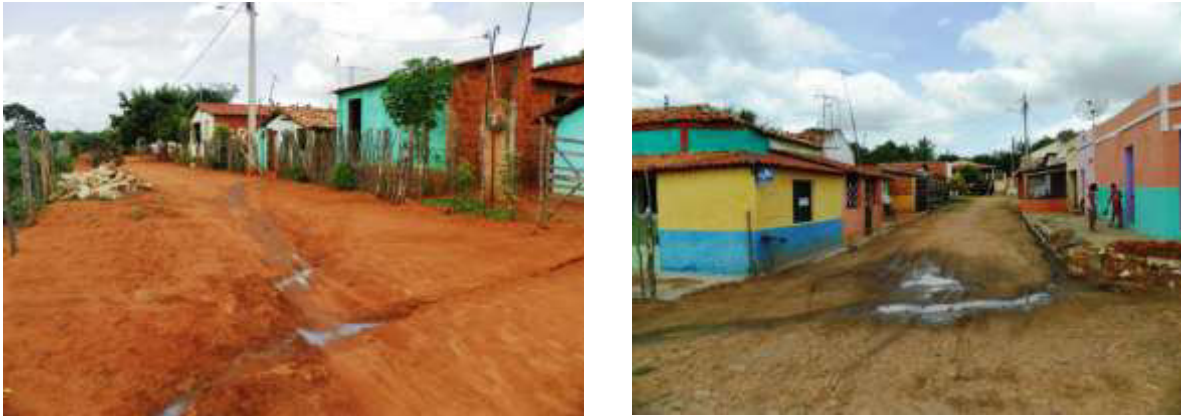
Figura 7.88 – Esgoto a céu aberto no distrito de Missão Nova.
