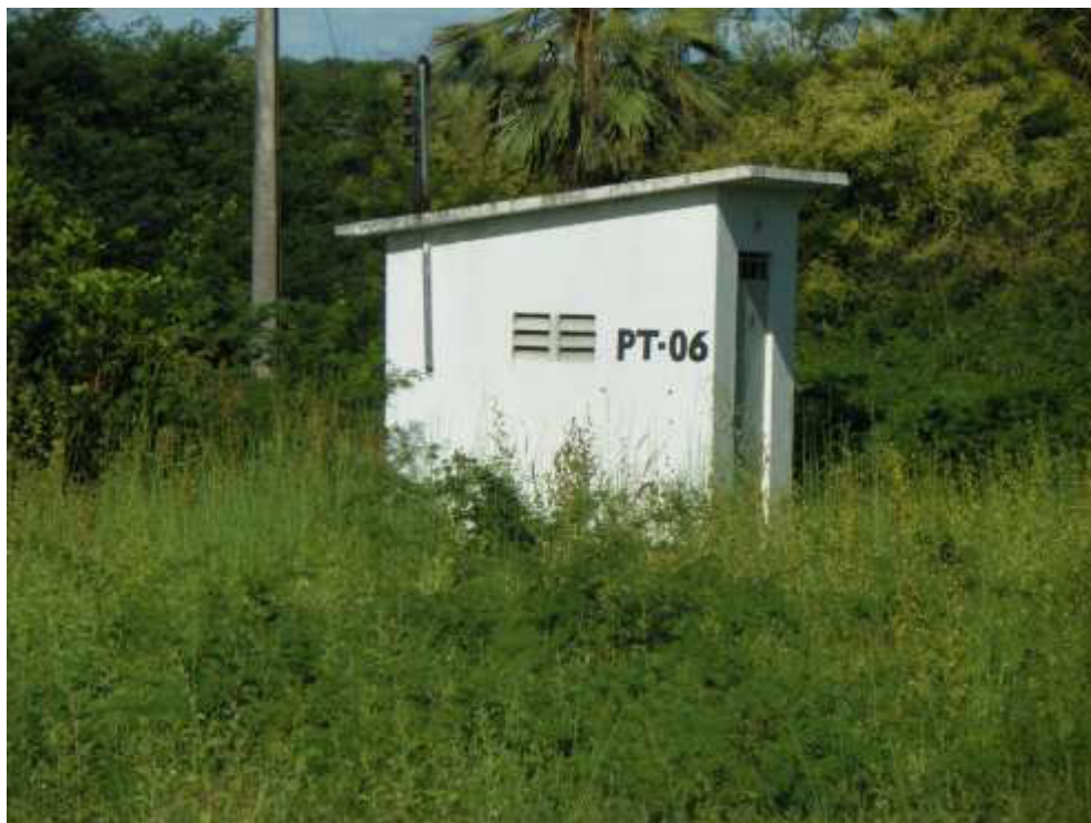
Figura 7.6 – Vista do poço tubular PT-06 (Q = desconhecida), ainda não ativado, que fará parte do manancial da sede de Missão Velha.
