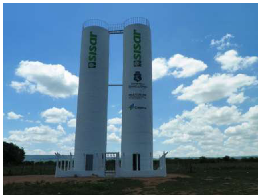
Figura 7.49 – Vista do poço tubular ( Q = 60 \text{ m}^3/\text{h} ) (a), REL-01 de 30 \text{ m}^3 , interligado ao REL-02 de 30 \text{ m}^3 (b) que atendem à localidade de Chiqueiro de Cabras, no município de Missão Velha, de responsabilidade do SISAR.
