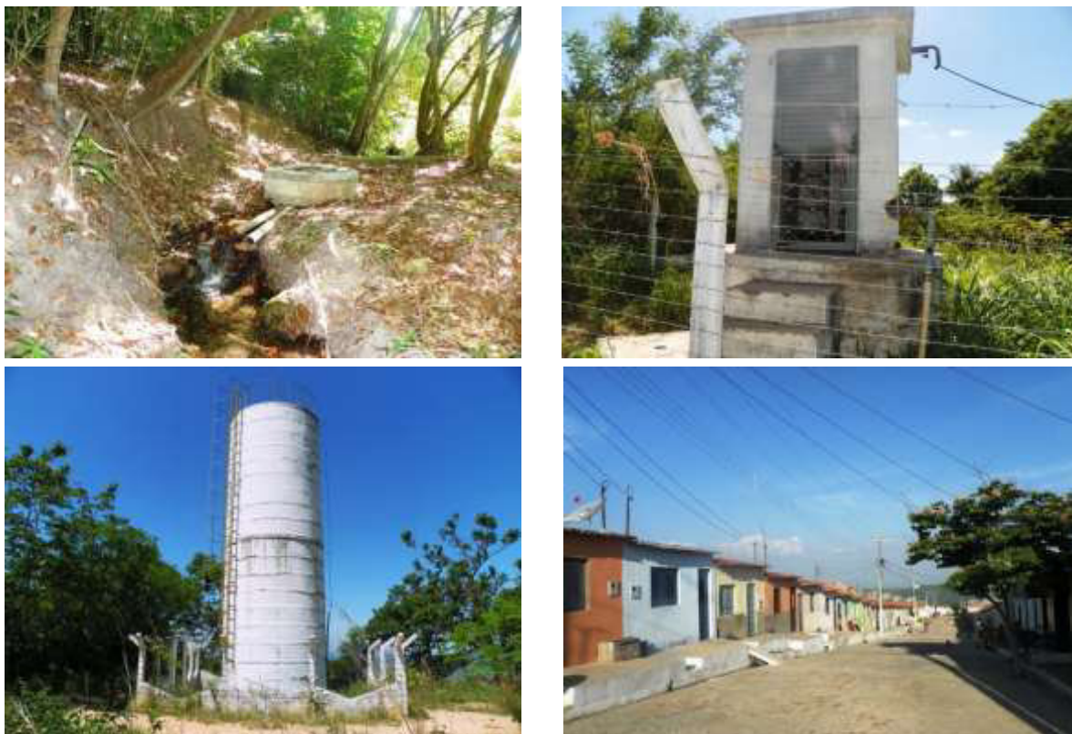
Figura 7.19 – Vista do poço tubular ( Q = 5,0 \text{ m}^3/\text{h} ) (a), estação elevatória ( Q = 5,0 \text{ m}^3/\text{h} ) (b), REL de 28 \text{ m}^3 (c) que fazem parte do sistema da localidade de Extrema e que atendem ao Bairro Popular (d), na zona urbana do distrito de Jamararu, no município de Missão Velha, de responsabilidade do SISAR.
