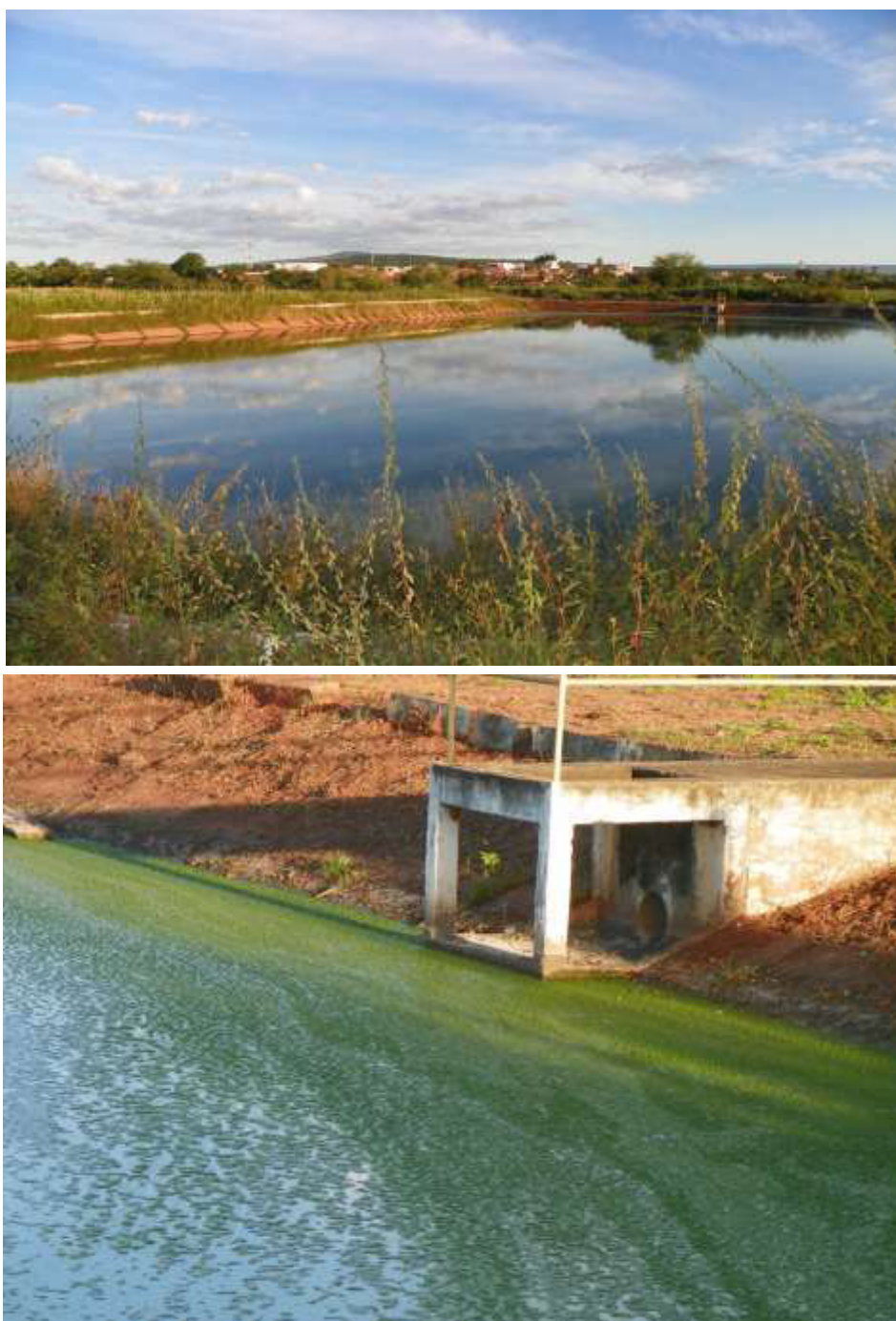
Figura 7.85 – Vista da lagoa de maturação 3 e do seu dispositivo de saída da ETE da sede de Missão Velha.
