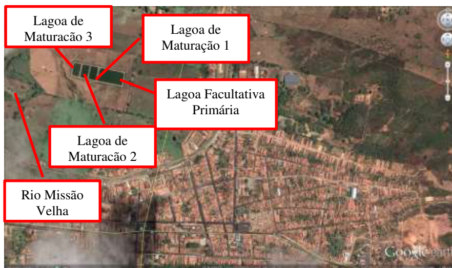
Figura 7.81 – Vista aérea da Estação de Tratamento de Esgotos (ETE) existente no município de Missão Velha, assim como o corpo receptor Rio Missão Velha.
