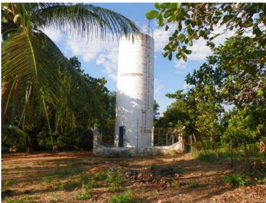
Figura 7.52 – Vista do poço tubular ( Q = 4,3 \text{ m}^3/\text{h} ) (a) e REL de 23 \text{ m}^3 (b) que atendem à localidade de Carnaúba, no município de Missão Velha, de responsabilidade do SISAR.
