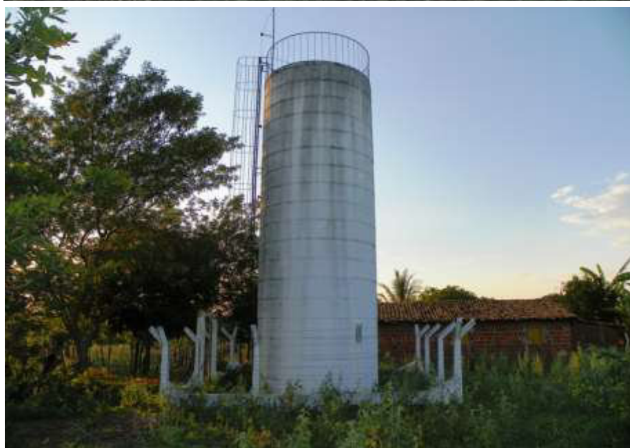
Figura 7.43 – Vista do poço tubular ( Q = 6,9 \text{ m}^3/\text{h} ) (a) e REL de 23 \text{ m}^3 (b) que atendem à localidade de Passagem de Pedra, no município de Missão Velha, de responsabilidade do SISAR.
