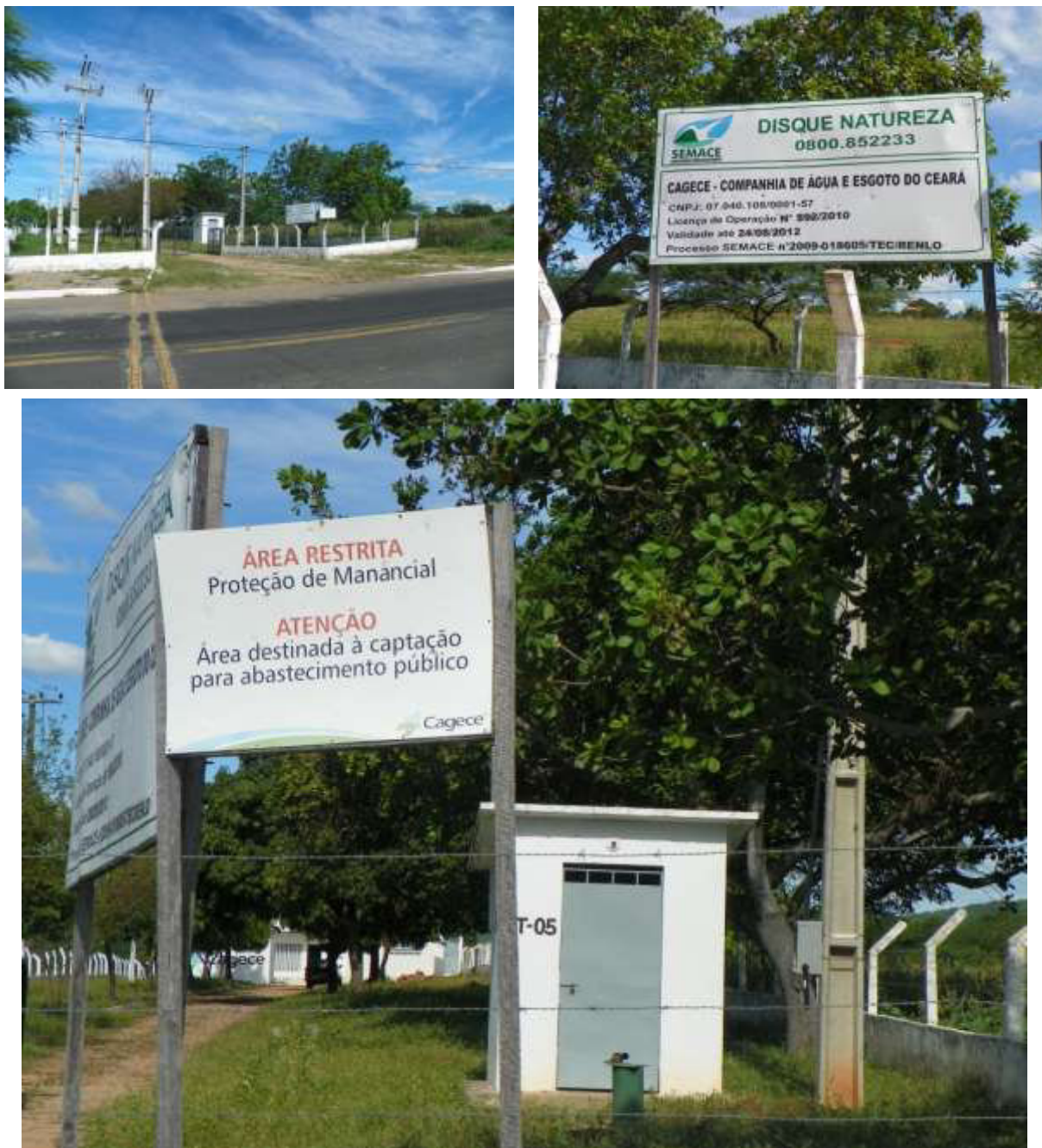
Figura 7.5 – Vista do poço tubular PT-05 (Q = desconhecida), ainda não ativado, localizado dentro da área da ETA, que fará parte do manancial da sede de Missão Velha, com destaque para a placa de licença de operação e controle do acesso.
