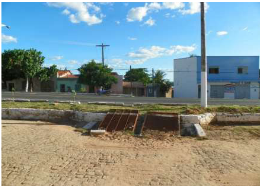
Figura 7.105 – Galeria localizada na Rua Cel. José Dantas. Fonte: Consórcio DGH-Cariri (2012).
