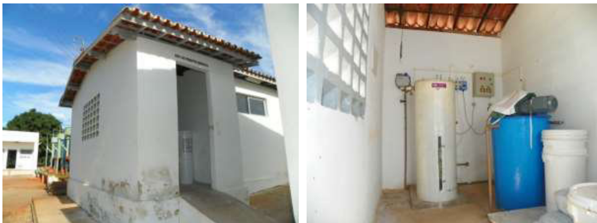
Figura 7.10 – Vista do depósito de armazenamento de produtos químicos, tanques de preparo do flúor e bombas dosadoras para aplicação, na Estação de Tratamento de Água (ETA) da sede de Missão Velha.
