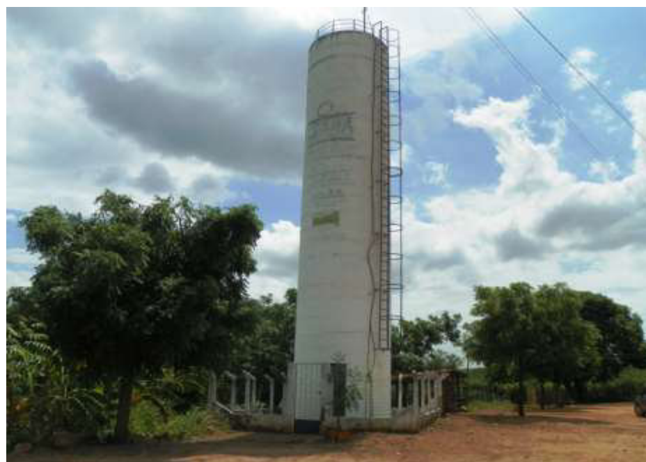
Figura 7.34 – Vista do poço tubular ( Q = 14,6 \text{ m}^3/\text{h} ) (a) e REL de 30 \text{ m}^3 (b) que atendem à localidade de Olho d'água Comprido, no município de Missão Velha, de responsabilidade do SISAR.
