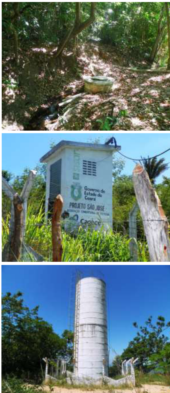
Figura 7.37 – Vista do poço tubular ( Q = 5 \text{ m}^3/\text{h} ) (a) (b) e REL de 28 \text{ m}^3 (c) que atendem à localidade de Extrema, no município de Missão Velha, assim como o Bairro Popular no distrito de Jamararu de responsabilidade do SISAR.
