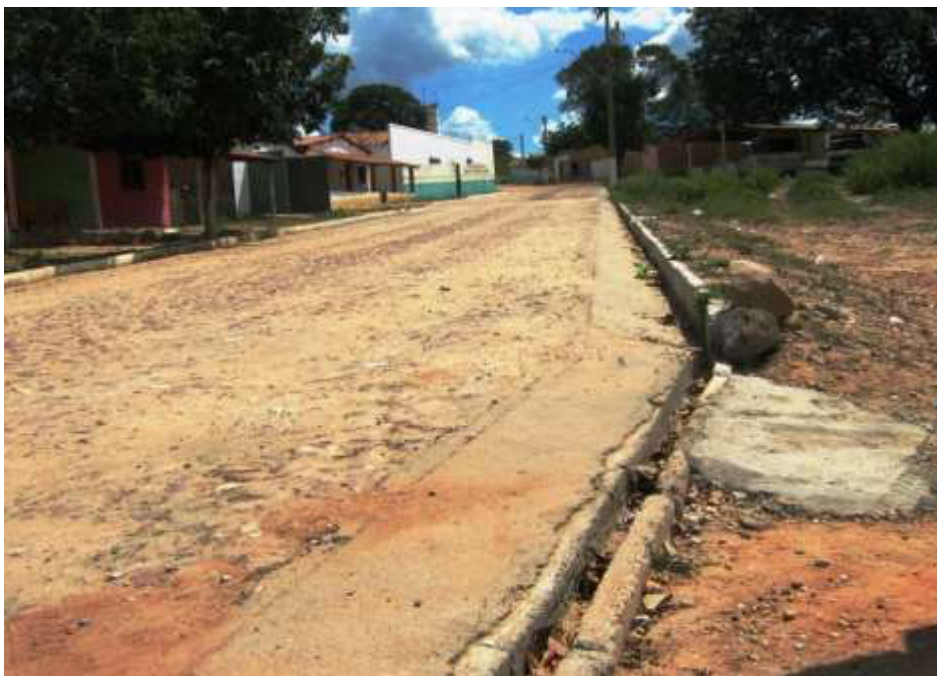
Figura 7.117 – Vista de sarjeta precária na Rua Principal do distrito de Quimami (ponto de alagamento). Fonte: Consórcio DGH-Cariri (2012).
