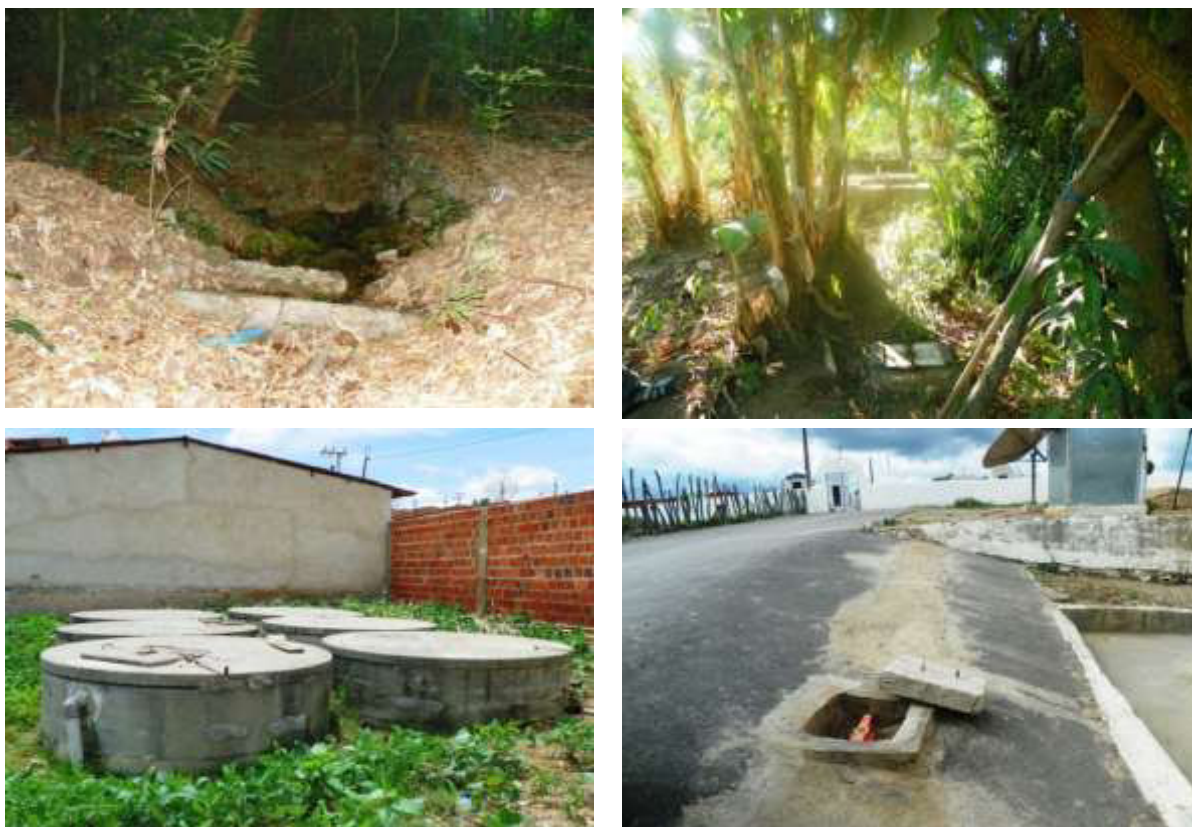
Figura 7.20 – Vista do poço tubular (Q desconhecida) (a), tanque de reunião com 1 m 3 de capacidade (b), reservatórios enterrados de 10 m 3 de capacidade cada (c) e um dos 27 registros de manobra (d) do sistema de distribuição de água do distrito de Jamacaru, no município de Missão Velha, de responsabilidade da prefeitura.
