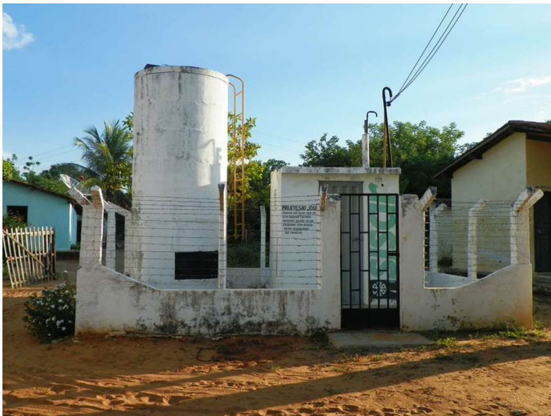
Figura 7.58 – Vista do poço tubular ( Q = 8,1 \text{ m}^3/\text{h} ) e REL de 30 \text{ m}^3 que atendem à localidade de Madeira Cortada, no município de Missão Velha, de responsabilidade do SISAR.
