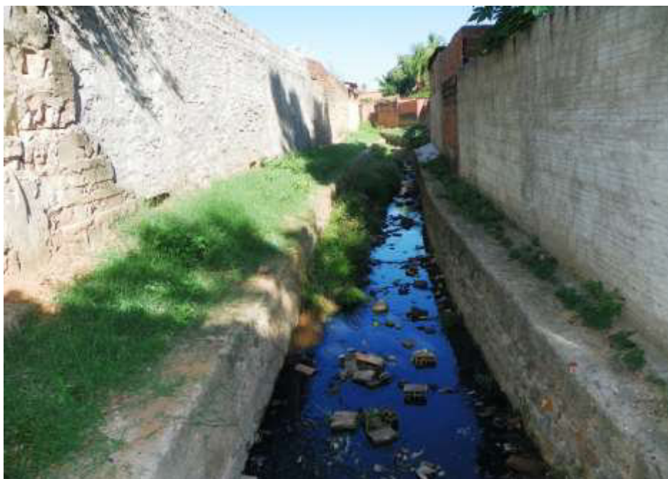
Figura 7.76 – Esgoto a céu aberto na Rua Francisco Januário Pereira (a) e no Canal de Esgoto/Drenagem entre a Av. Cel. Dantas e Rua Dom Bosco na sede de Missão Velha (b).
