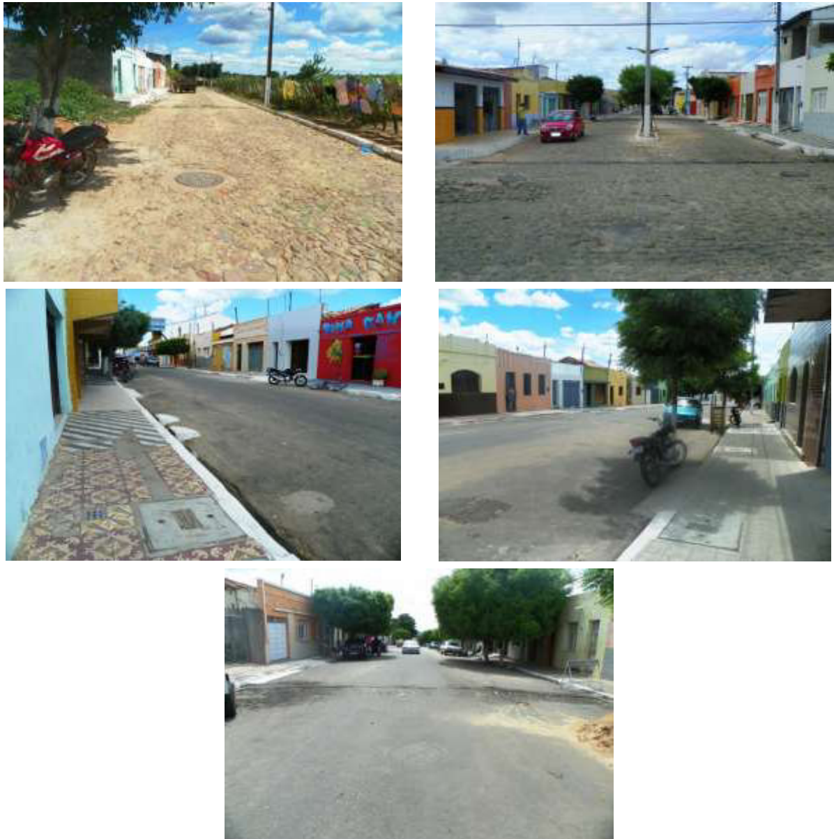
Figura 7.73 – Rede coletora de esgotos nas Ruas Blandina Leite (a), José Sobreira Cruz (b) Antônio Augusto Saraiva (c), São Francisco (d) (e), na sede de Missão Velha.
