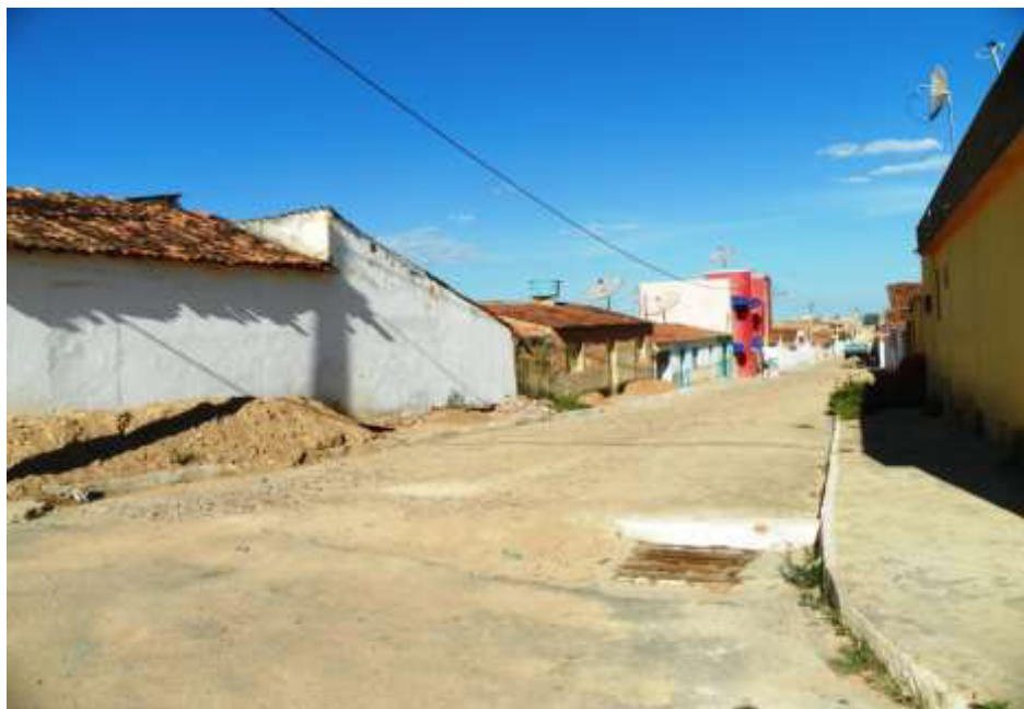
Figura 7.111 – Vista da boca de lobo na Rua São Francisco. Fonte: Consórcio DGH-Cariri (2012).
