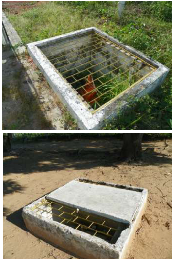
Figura 7.12 – Vista do registro de gaveta e medidor proporcional instalados na saída da adutora de água tratada da sede de Missão Velha.
