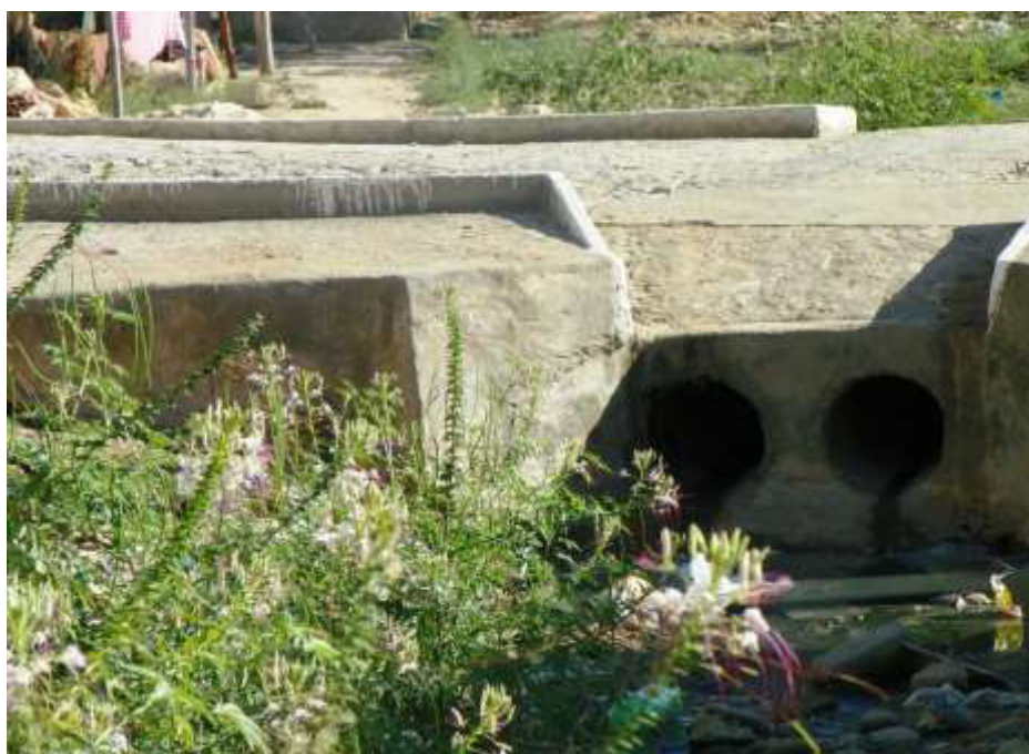
Figura 7.112 – Vista do bueiro na Rua São Francisco. Fonte: Consórcio DGH-Cariri (2012).
