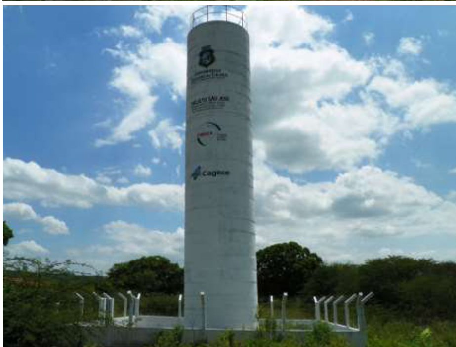
Figura 7.67 – Vista do poço tubular ( Q = 9,0 \text{ m}^3/\text{h} ) (a) e REL de 28 \text{ m}^3 (b) que atendem à localidade de Sítio Caiçara, no município de Missão Velha, de responsabilidade do SISAR.
