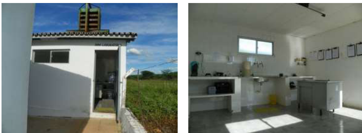
Figura 7.11 – Vista da entrada e interior do laboratório existente na Estação de Tratamento de Água (ETA) da sede de Missão Velha.
