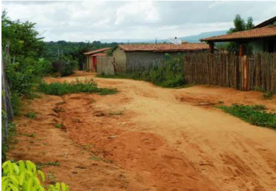
Figura 7.116 – Formação de voçoroca em vias urbanas do distrito de Missão Nova. Fonte: Consórcio DGH-Cariri (2012).
