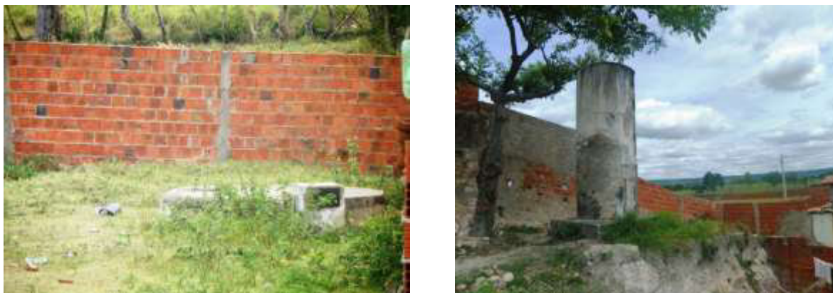
Figura 7.21 – Vista do poço tubular (Q desconhecida) e REL de 3 m 3 que atendem à zona urbana do distrito de Jamacaru, de responsabilidade da prefeitura.
