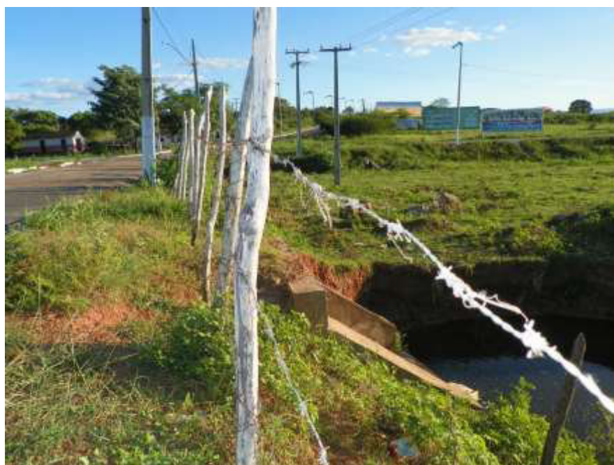
Figura 7.106 – Bueiro localizado na Rua Padre Felix, descarregando as águas pluviais na Lagoa José Gonçalves de Lima. Fonte: Consórcio DGH-Cariri (2012).
