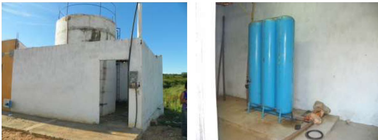
Figura 7.16 – Vista do reservatório apoiado RAP-04 de 15 m 3 e da estação pressurizadora ( booster ), responsável pela distribuição de água no Bairro da Fé da sede de Missão Velha.
