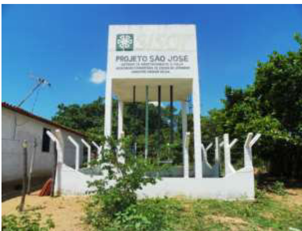
Figura 7.55 – Vista do poço tubular ( Q = 5,2 \text{ m}^3/\text{h} ) (a) (b) e REL de 25 \text{ m}^3 (c) que atendem à localidade de Jerimum, no município de Missão Velha, de responsabilidade do SISAR.
