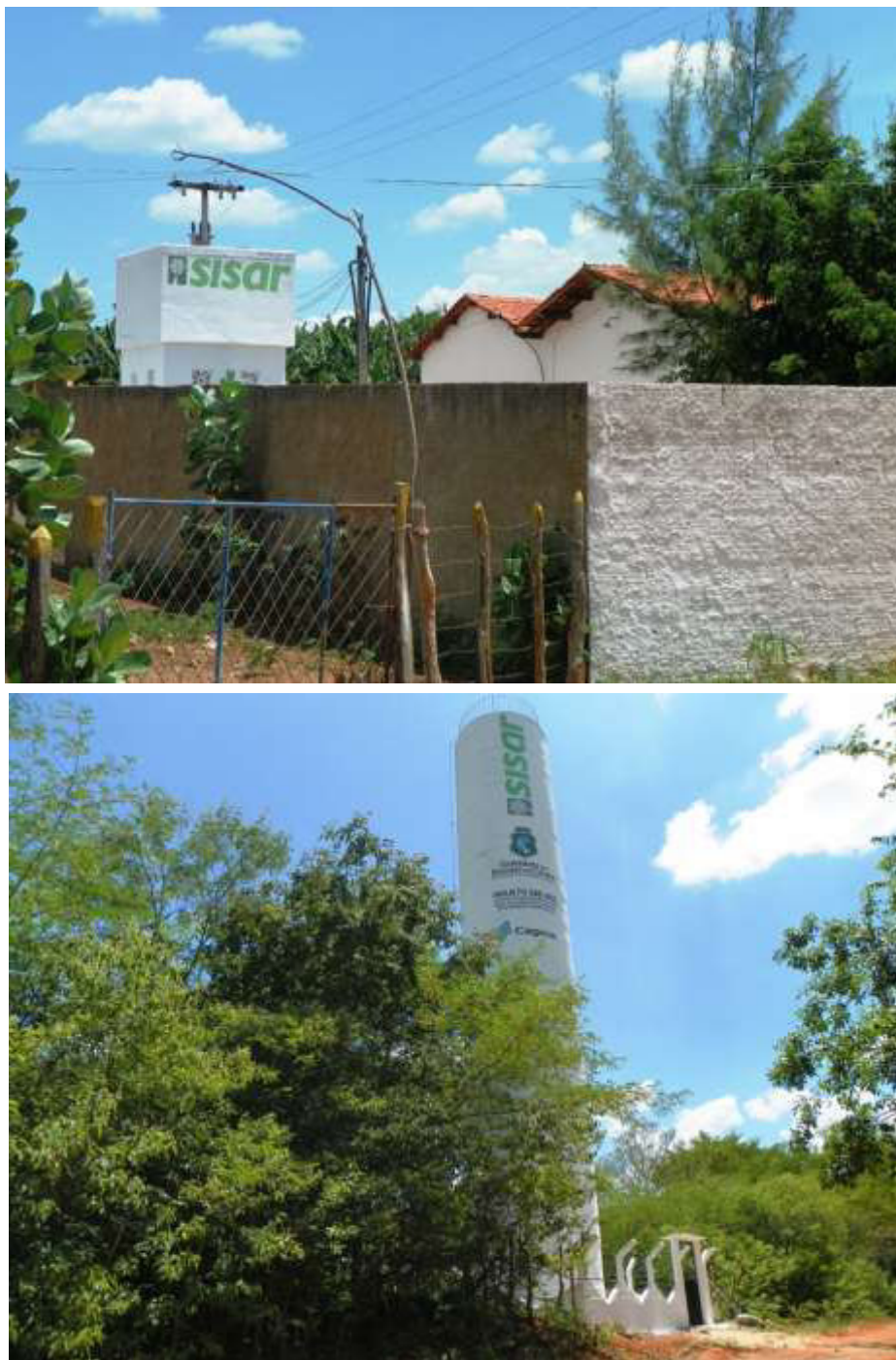
Figura 7.31 – Vista do poço tubular ( Q = 13,5 \text{ m}^3/\text{h} ) (a) e REL de 35 \text{ m}^3 (b) que atendem à localidade de Barreiras, no município de Missão Velha, de responsabilidade do SISAR.
