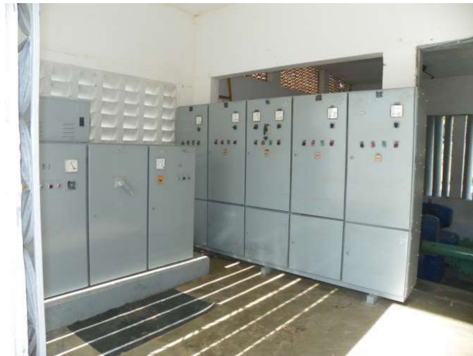
Figura 7.14 – Vistas da EEAT-01 (RAP-03) e EEAT-02 (lavagem dos filtros) da sede de Missão Velha, e seus respectivos quadros de comando.
