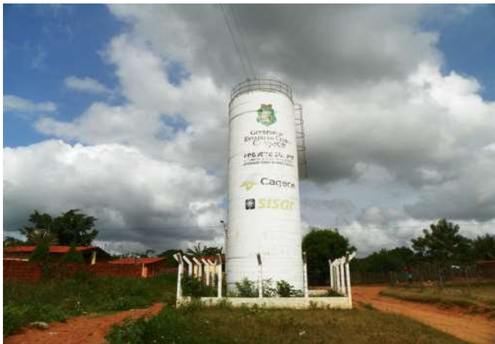
Figura 7.25 – Vista do poço tubular ( Q = 9,7 \text{ m}^3/\text{h} ) (a) e REL de 30 \text{ m}^3 (b) que atendem ao distrito de Missão Nova, no município de Missão Velha, de responsabilidade do SISAR.
