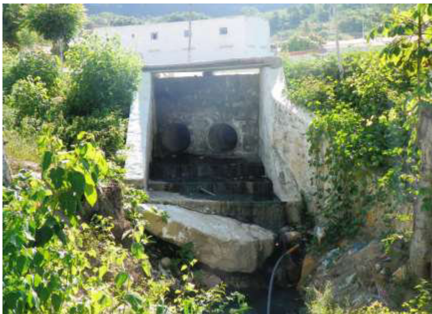
Figura 7.113 – Vista do bueiro na Rua da Barragem.
