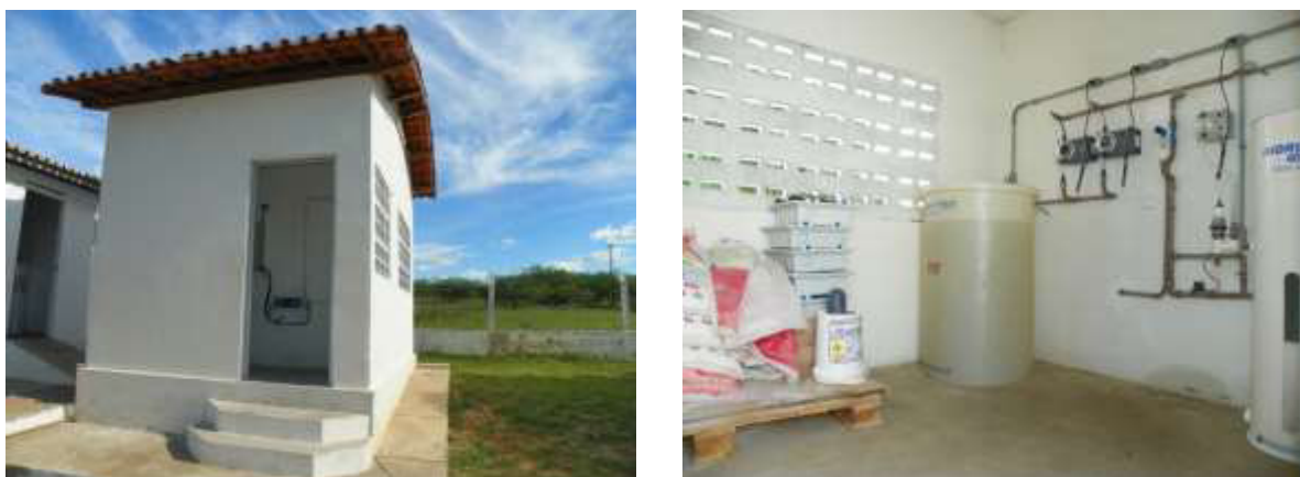
Figura 7.9 – Vista da fábrica de cloro, e detalhe do armazenamento de produtos químicos e cloradores, na Estação de Tratamento de Água (ETA) da sede de Missão Velha.
