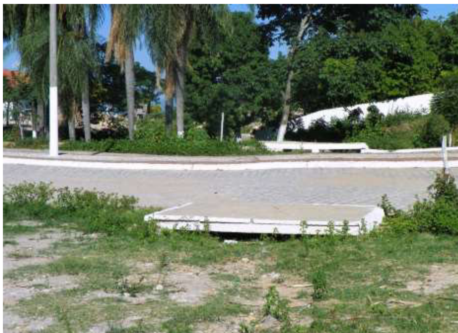
Figura 7.115 – Ponto de alagamento na Rua da Barragem.
