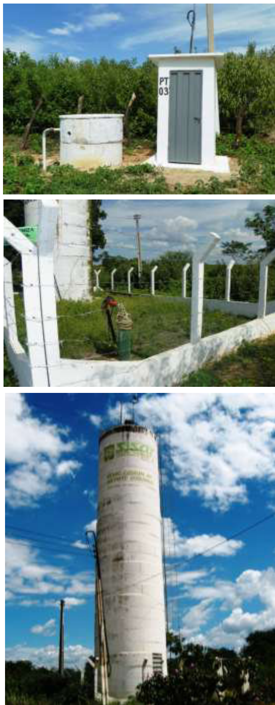
Figura 7.28 – Vista do poço tubular ( Q = 6 \text{ m}^3/\text{h} ) (a) (b) e REL de 23 \text{ m}^3 (c) que atendem ao distrito de Quimami, no município de Missão Velha, de responsabilidade do SISAR.
