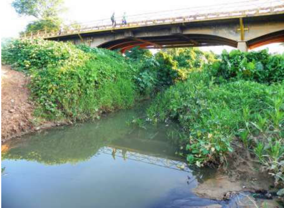
Figura 7.104 – Ponte sobre o Rio Missão Velha.
