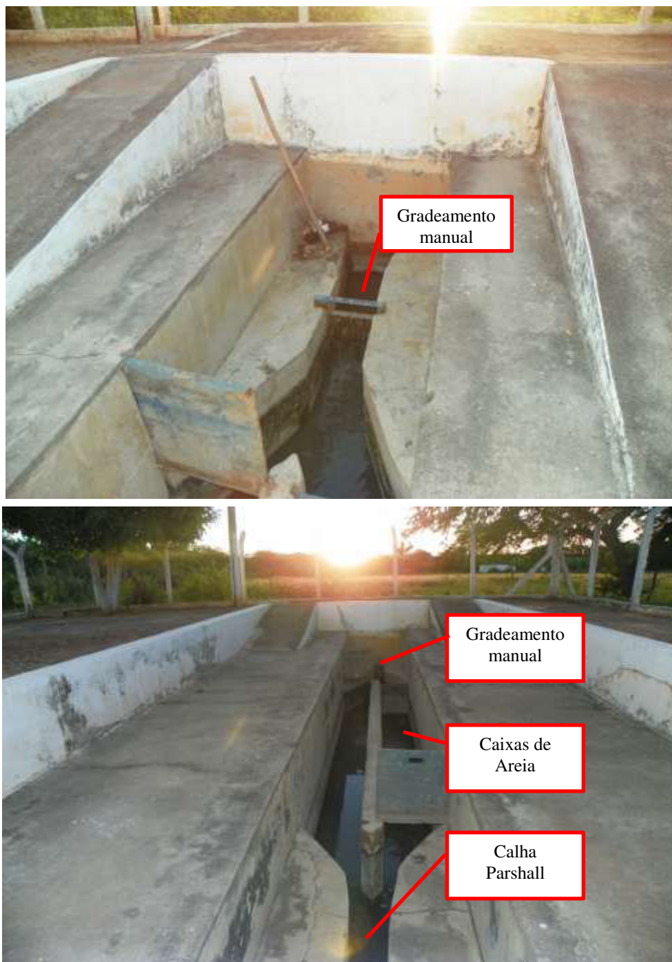
Figura 7.79 – Tratamento preliminar de esgotos realizado na Estação Elevatória de Esgotos (EEE-01) da sede de Missão Velha.
