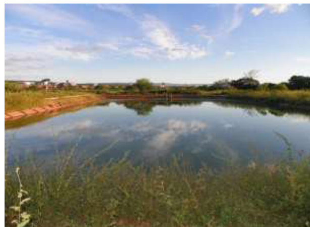
Figura 7.84 – Vista da saída da lagoa facultativa primária e entrada nas lagoas de maturação 1 e 2 da ETE da sede de Missão Velha.
