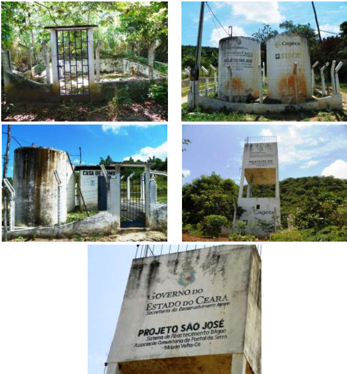
Figura 7.64 – Vista da fonte ( Q = 2 \text{ m}^3/\text{h} ) (a), RAPs de 10 \text{ m}^3 (b), Estação elevatória ( Q = \text{desc.} ) (c) e REL de 30 \text{ m}^3 (d) (e), que atendem à localidade de Pontal da Serra, no município de Missão Velha, de responsabilidade do SISAR.
