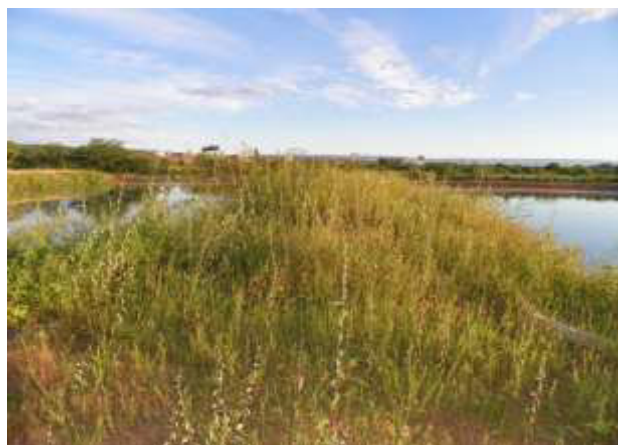
Figura 7.83 – Vista da presença de zonas mortas na lagoa facultativa primária e grande quantidade de vegetação no coroamento e taludes da ETE da sede de Missão Velha.
