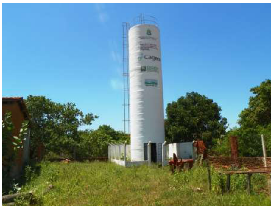
Figura 7.61 – Vista do poço tubular ( Q = 6,3 \text{ m}^3/\text{h} ) (a) e REL de 23 \text{ m}^3 (b) que atendem à localidade de Logradouro, no município de Missão Velha, de responsabilidade do SISAR.
