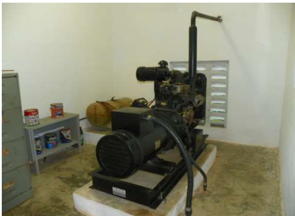
Figura 7.80 – Conjuntos motor-bomba e grupo gerador da EEE-01 da sede de Missão Velha.
