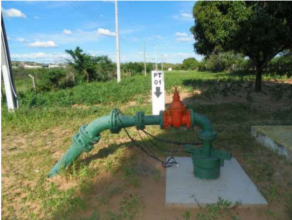
Figura 7.2 – Vista do poço tubular PT-01 ( Q = 44,6 \text{ m}^3/\text{h} ) localizado dentro da ETA que faz parte do manancial da sede de Missão Velha.
