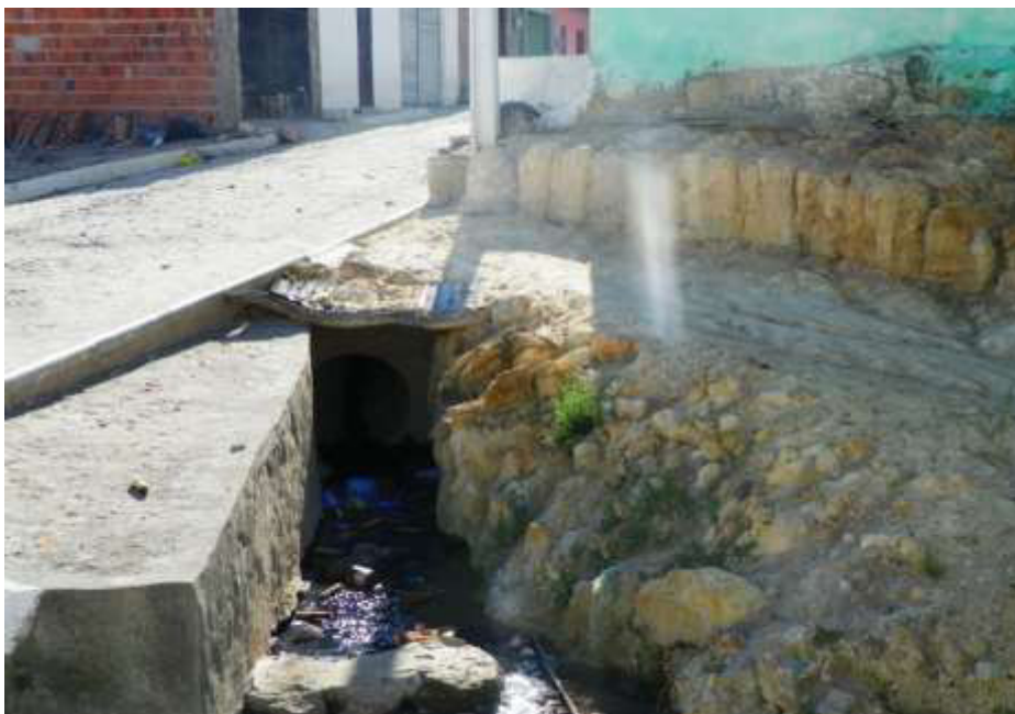
Figura 7.114 – Ponto de alagamento na Rua São Francisco.
