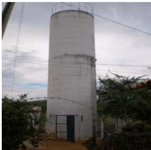
Figura 7.46 – Vista do poço tubular ( Q = 7,5 \text{ m}^3/\text{h} ) (a, b, c), e REL de 20 \text{ m}^3 (d) que atendem à localidade de Chiqueiro de Cabras, no município de Missão Velha, de responsabilidade do SISAR.
