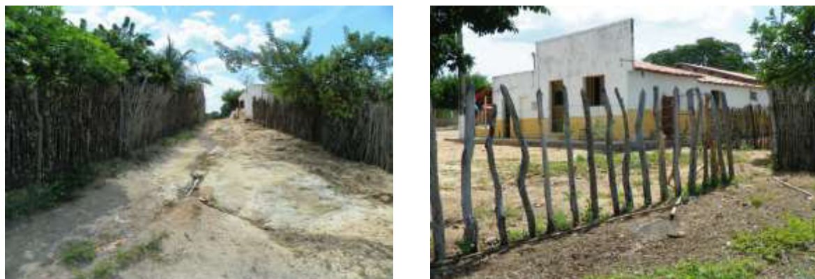
Figura 7.87 – Esgoto a céu aberto no distrito de Quimami.
