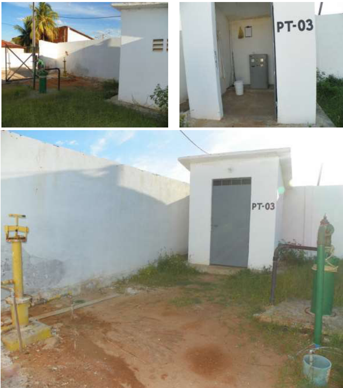
Figura 7.4 – Vista do poço tubular PT-04 ( Q = 20 \text{ m}^3/\text{h} ) que faz parte do manancial da sede de Missão Velha, com destaque para a aplicação de cloro, quadro de comando e controle do acesso. Obs.: erro na numeração do PT constatado na inspeção de campo.
