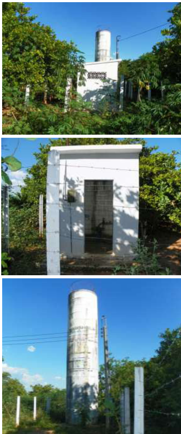
Figura 7.70 – Vista do poço tubular ( Q = 6,0 \text{ m}^3/\text{h} ) (a) (b) e REL de 25 \text{ m}^3 (c) que atendem à localidade de Sítio Pintado, no município de Missão Velha, de responsabilidade do SISAR.
