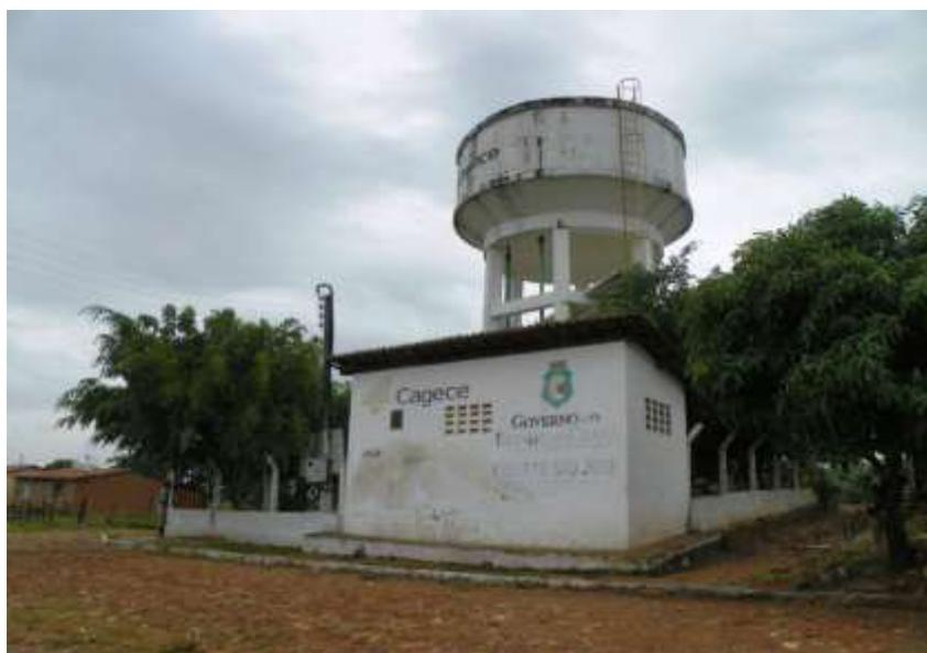
**Figura 5.6** – Vista do reservatório elevado REL de 120 m<sup>3</sup> do distrito de Triunfo.
