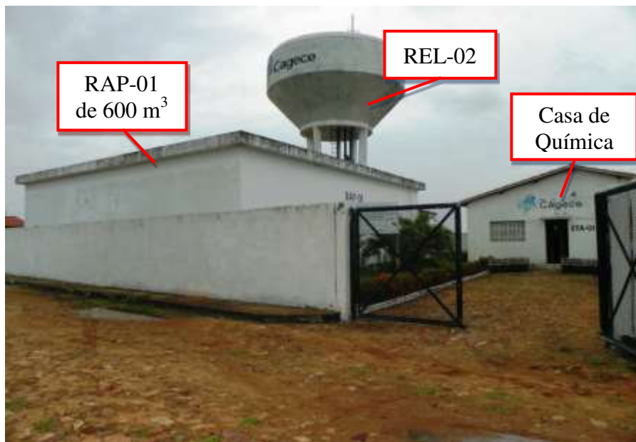
Figura 7.9 – Detalhe da Estação de Tratamento de Água (ETA) da sede de Nova Olinda.
