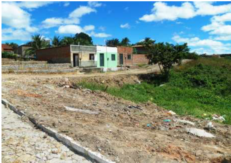
Figura 7.63 – Área de risco de deslizamento de terra na Rua Nazário Ribeiro (sem infraestrutura de microdrenagem e de proteção à erosão). Fonte: Consórcio DGH-Cariri (2011).
