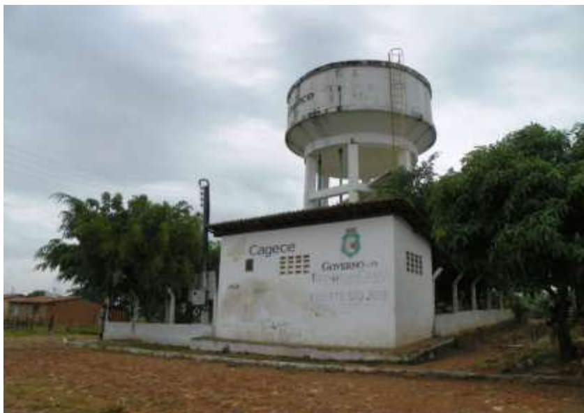
Figura 7.16 – Vista do reservatório elevado REL de 120 m 3 da localidade de Vila Triunfo.
