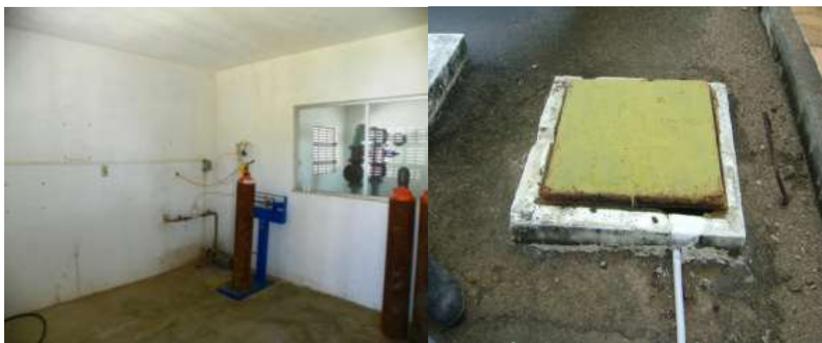
Figura 7.10 – Vista da área de armazenamento dos cilindros de cloro gasoso, cloradores e do ponto de aplicação no reservatório apoiado RAP-01 de 600m 3 .
