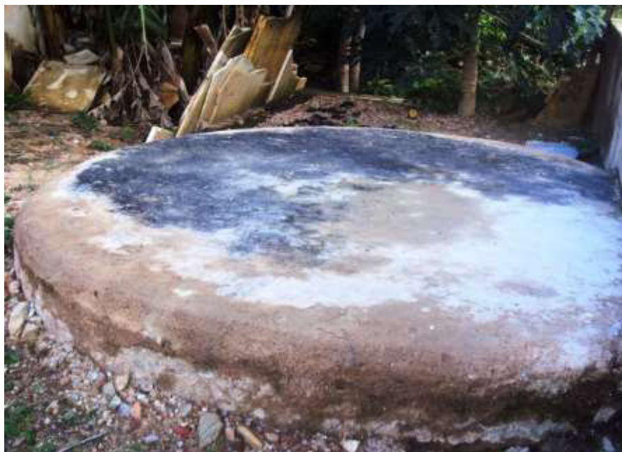
Figura 7.33 – Vista superior de uma fossa séptica instalada em residência localizada na Vila Triunfo.
