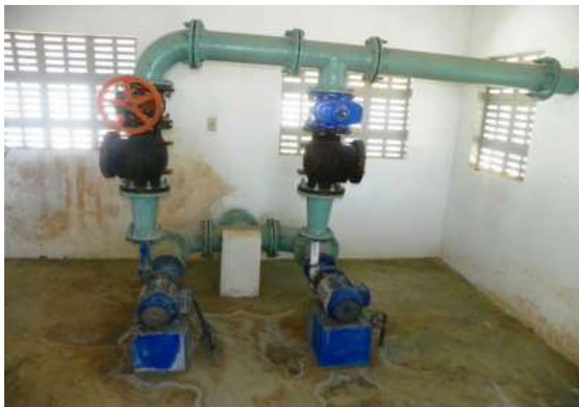
Figura 7.12 – Vista do barrilete de recalque e conjuntos motor-bombas da estação elevatória de água tratada (EEAT-01) que recalca água para o reservatório elevado REL-02 de 250m 3 .
