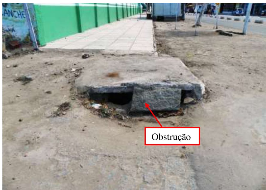
Figura 7.50 – Vista de boca de lobo na Av. Perimetral Sul, indicando obstrução. Fonte: Consórcio DGH-Cariri (2011).
