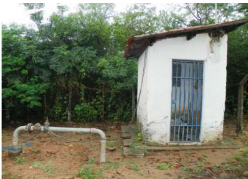
Figura 7.15 – Vista do poço tubular ( Q = 18 \text{ m}^3/\text{h} ) que faz parte do manancial da localidade de Vila Triunfo. Fonte: Consórcio DGH-Cariri (2011).
