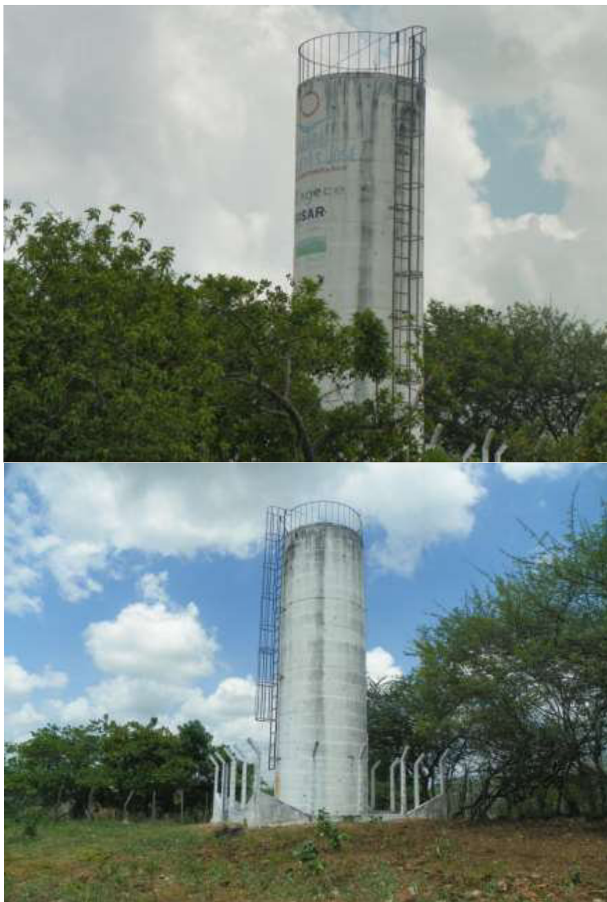
Figura 7.20 – Reservatório elevado de 28 m 3 que atende a localidade de Barreiros. Fonte: Consórcio DGH-Cariri (2011).
