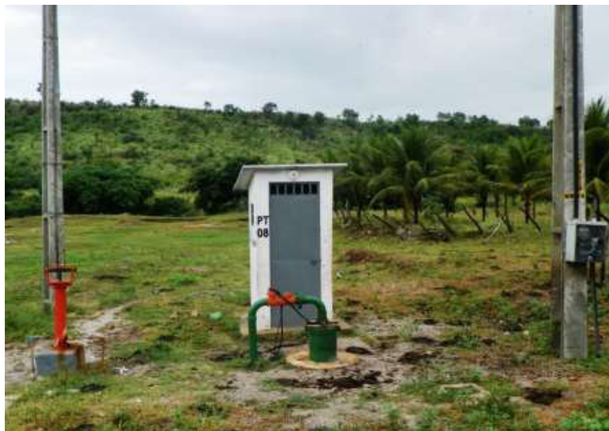
Figura 7.5 – Vista do poço tubular PT-08 que faz parte do manancial da sede de Nova Olinda.
