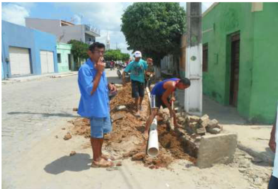
Figura 7.32 – Populares implantando por conta própria rede de esgotamento sanitário na Av. Jeremias Pereira.
