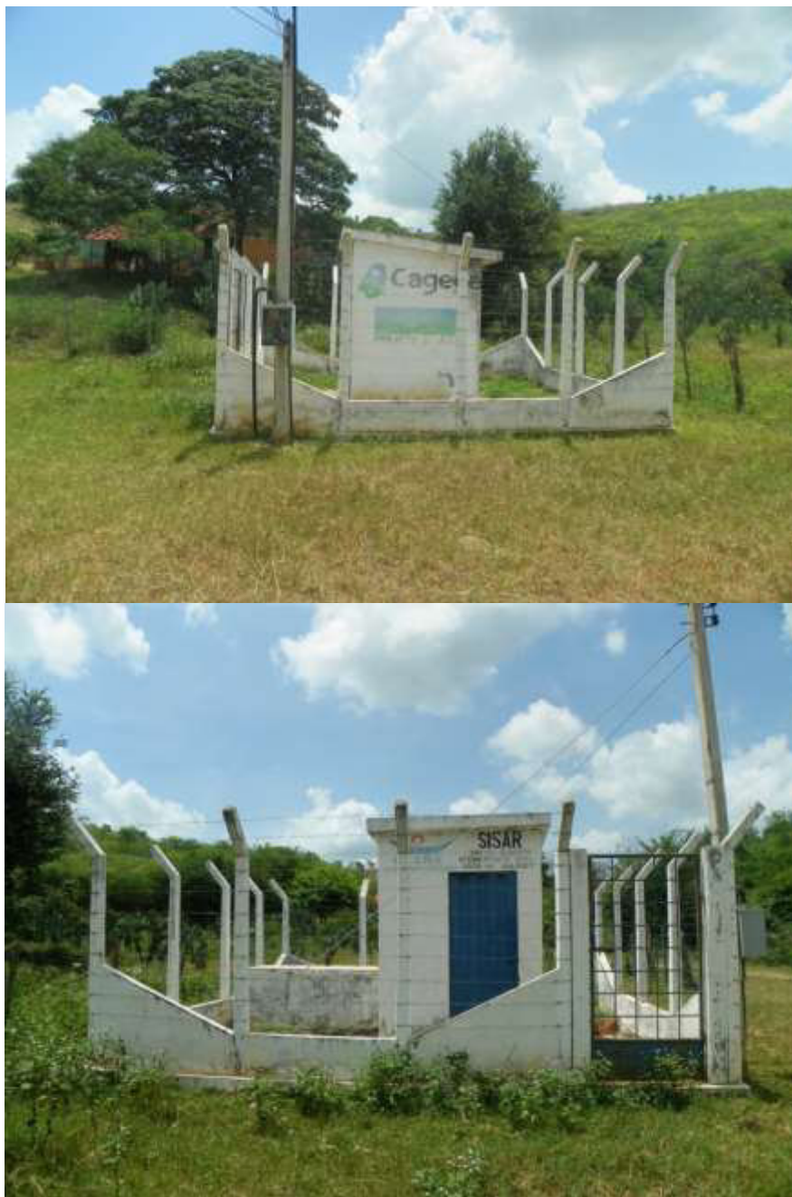
Figura 7.19 – Poço tubular ( Q = 2,2 \text{ m}^3/\text{h} ) que atende a localidade de Barreiros. Fonte: Consórcio DGH-Cariri (2011).
