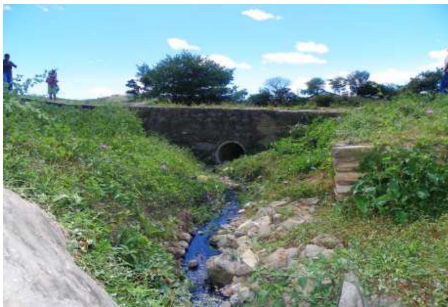
Figura 7.28 – Interligação da rede coletora com a rede de drenagem de águas pluviais na Rua Marinete Jeremias.
