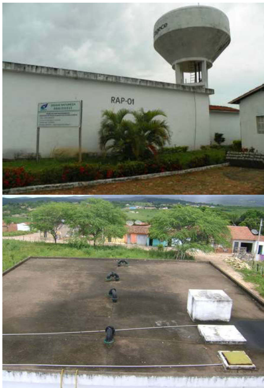
Figura 7.8 – Vista da aplicação do cloro no reservatório apoiado RAP-01 localizado na ETA da sede de Nova Olinda. Fonte: Consórcio DGH-Cariri (2011).
