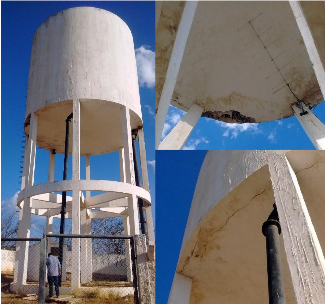
Figura 29 - Reservatório elevado, localizada no Conjunto Esperança.
