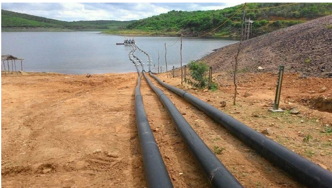
Figura 15 - Adutora emergencial no Açude Pedras Brancas em Quixadá.
