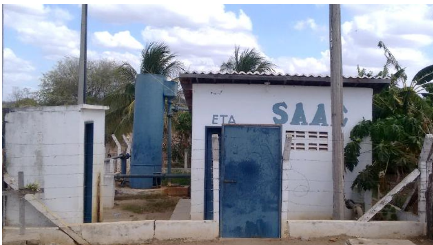
Figura 43 - Estação de Tratamento de Água de Encantado.
