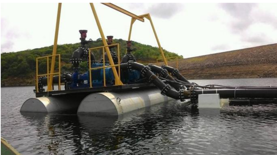
Figura 16 - Adutora emergencial no Açude Pedras Brancas em Quixadá.
