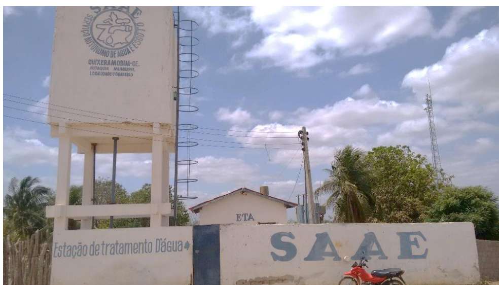
Figura 38 - Estação de Tratamento de água de Passagem.
