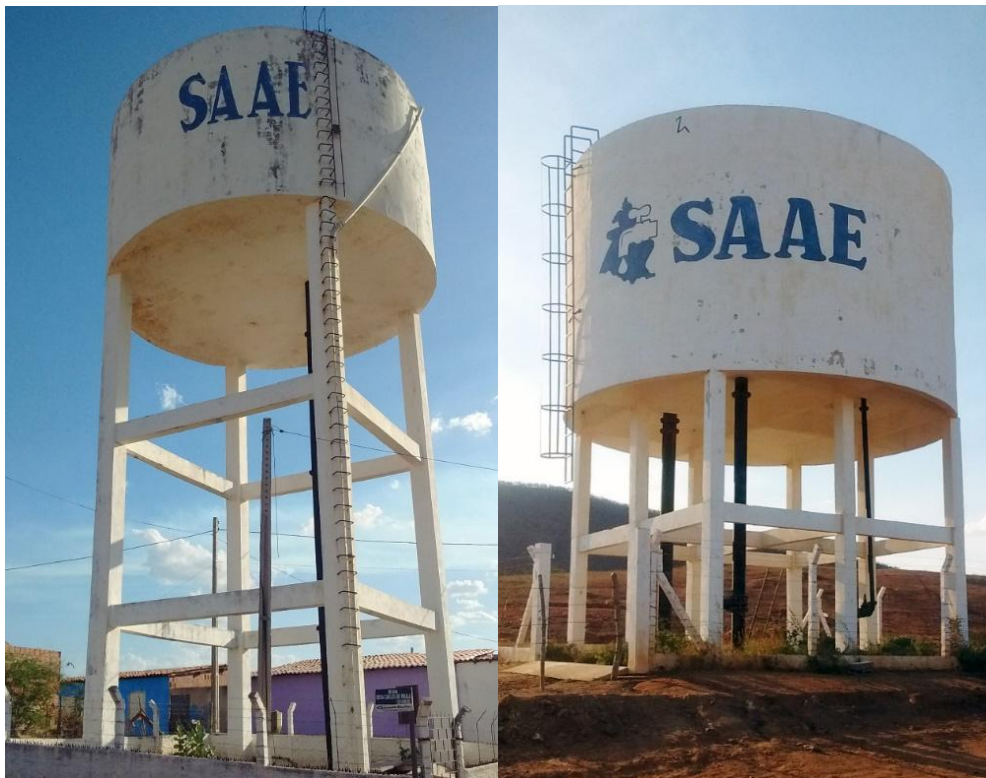
Figura 28 - Reservatórios elevados (a) Conjunto Maravilha; (b) Conjunto Alto da Colina.
