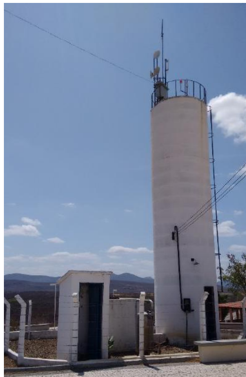
Figura 35 - Reservatório Elevado localizado em Damião Carneiro.
