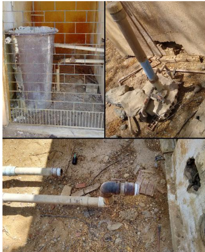
Figura 34 - Estado de conservação da ETA de Damião Carneiro.
