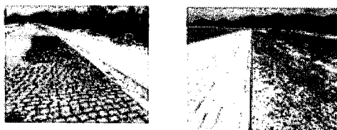
Obra de pavimentação da via paisagística - Trecho IV
