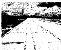
Obra de pavimentação da via paisagística - trecho IIIB
