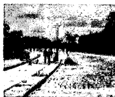
Obra de pavimentação da via paisagística- Trecho IV
