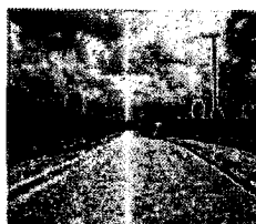
Obra de pavimentação da via paisagística - Trecho III
