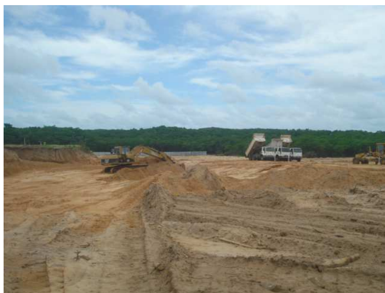
Figura 18 - Movimentação de terra em uma obra pública
