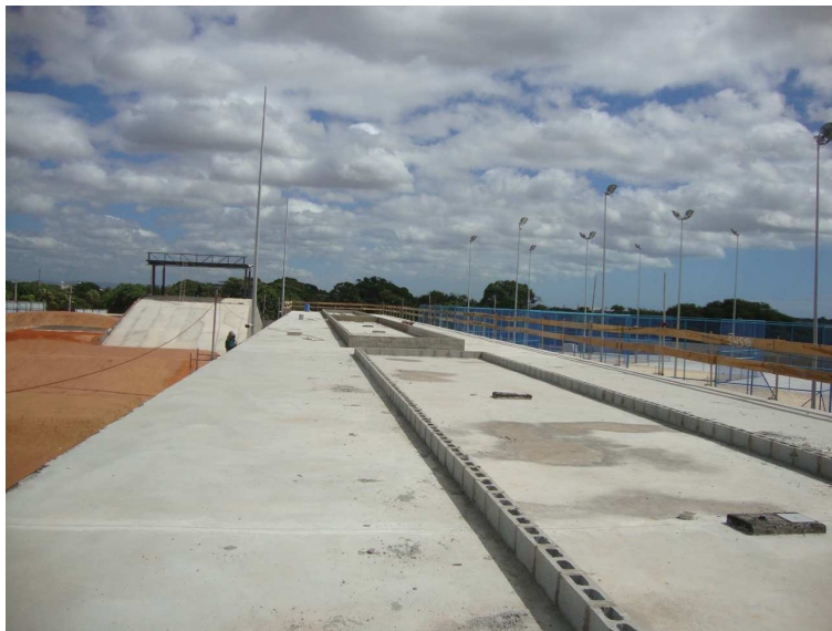
Figura 31 - Marcação de Bloco de Concreto
