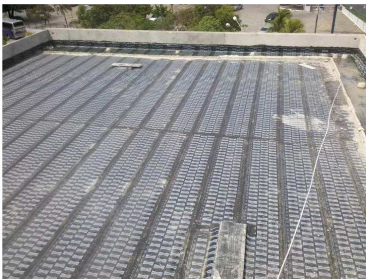
Figura 35 - Impermeabilização em Coberta/Laje
