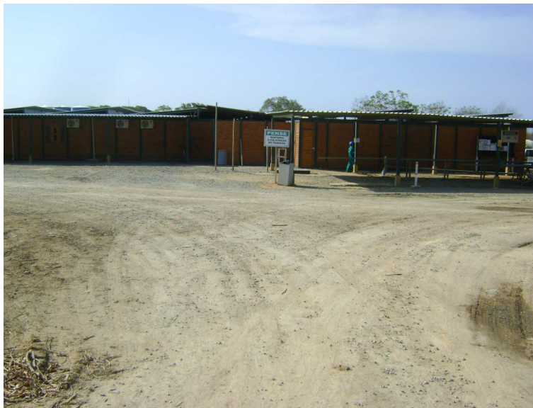
Figura 13 - Exemplo de Canteiro de Obras
