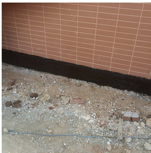
Figura 34 - Aplicação de Camada Impermeabilizante
