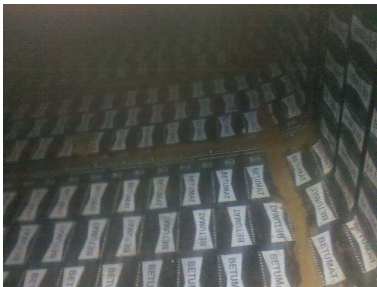
Figura 36 - Impermeabilização em Reservatório de Concreto
