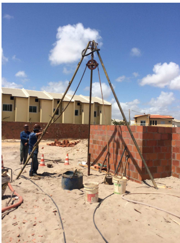
Figura 12 - Sondagem à percussão
