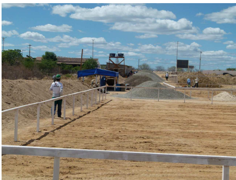
Figura 14 - Locação da Obra
