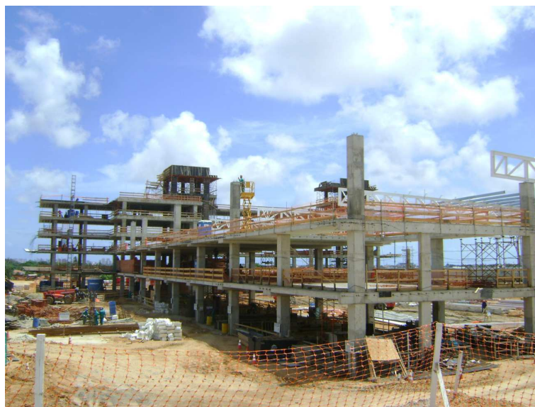
Figura 24 - Estrutura de concreto
