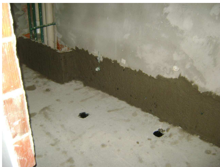
Figura 33 - Aplicação de Aditivo Impermeabilizante
