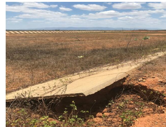
ETE - Talude de lagoa
