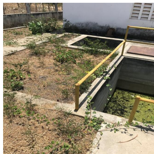
Estação Elevatória - Poço de Sucção
