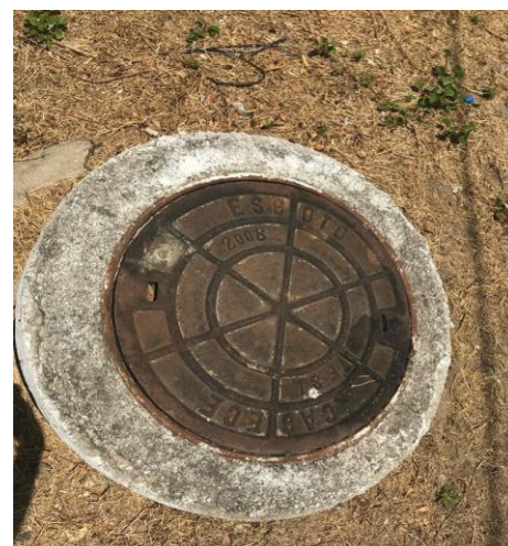
Poço de Visita da Estação Elevatória
