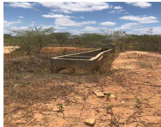
ETE - Estrutura de chegada
