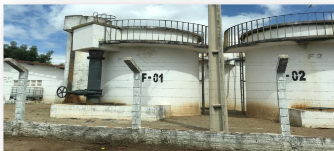
Figura 34 – Filtros F-01 e F-02.
