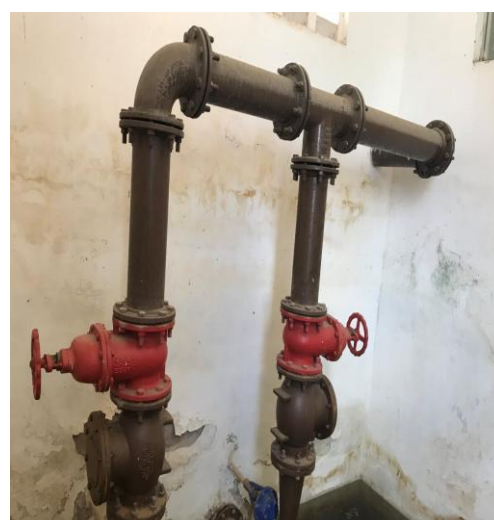
Estação Elevatória – Barrilete de Recalque
