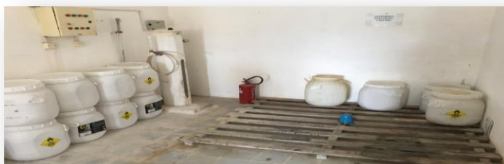
Figura 33 - Armazenamento de produtos químicos - Casa de Química.
