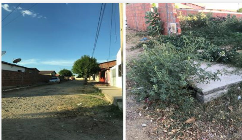
Figura 53 Boca de lobo da Rua Vicente de Araújo Chaves
