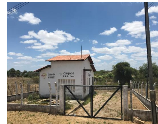
Estação Elevatória de Esgoto (pronta mas não opera)
