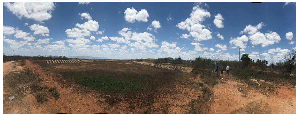
ETE do tipo lagoa de estabilização (não finalizada)
