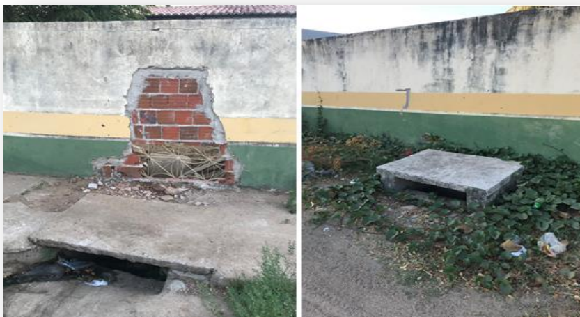
Figura 54 Boca de lobo da Rua Raimundo Martins
