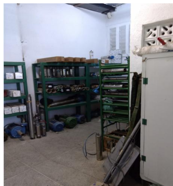
Detalhe da Oficina de Manutenção
