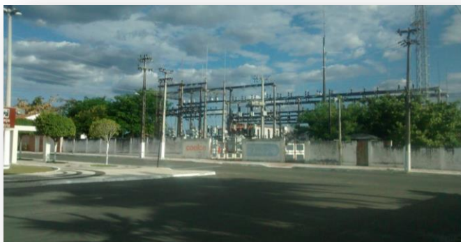
Figura 15 – Subestação de Energia, ao longo da Igreja Matriz, na região Central de Cariré.
