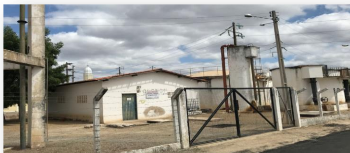
Figura 31 - Entrada da ETA.
