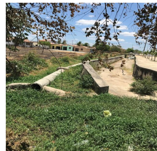
Ponto de Lançamento de Esgoto
