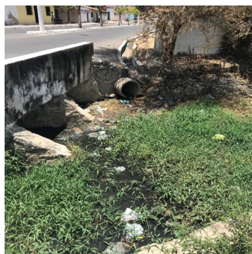
Rede de Esgoto, extravasor de rede
