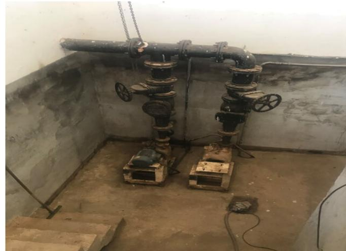
Estação Elevatória de Esgoto – EEE 2 – Grupos Motor-Bomba
