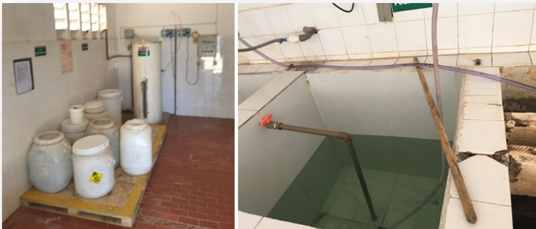
Figura 44 – Armazenamento e Preparo do PAC e Polímero – ETA.
