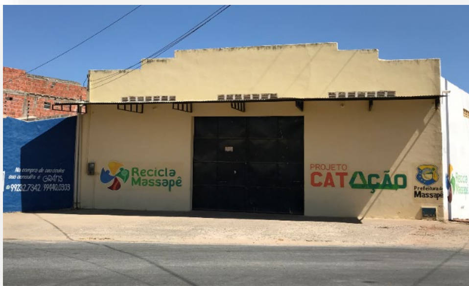
Figura 80 Atual Galpão de Triagem de Resíduos
