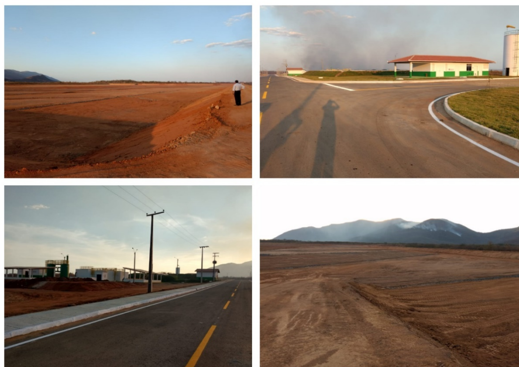
Figura 77 Aterro Sanitário do Consórcio
