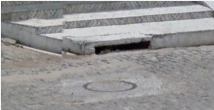
Figura 65 Boca de lobo
