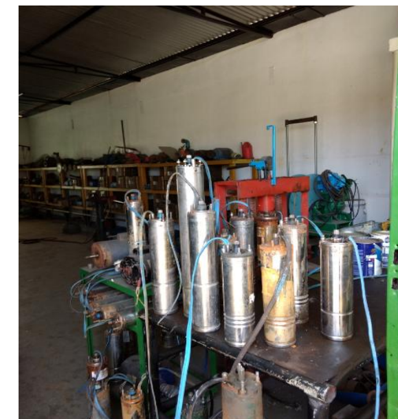
Bombas Submersas dos Poços em Manutenção
