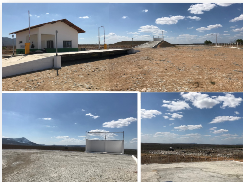
Figura 78 Estação de Transferência de Resíduos Sede de Massapê
