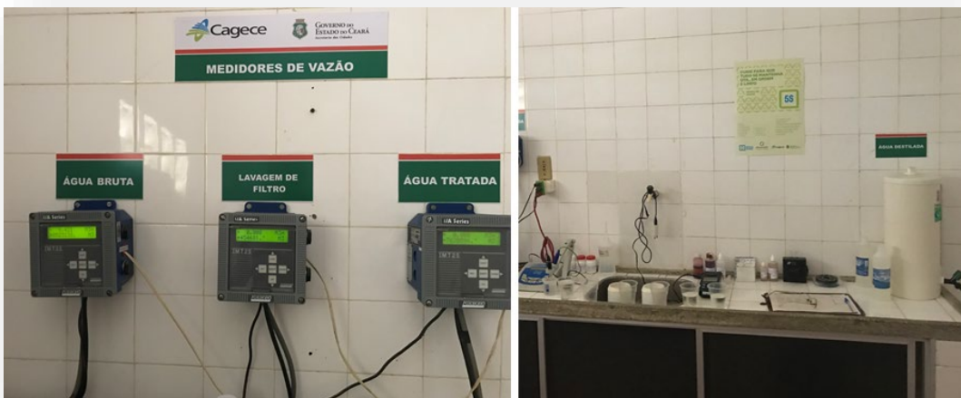
Figura 45 – Casa de química – Medidores de Vazão e Laboratório de Controle.
