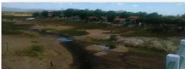
Figura 12 - Foto do rio Acaraú sob ponte de acesso para a sede municipal.
