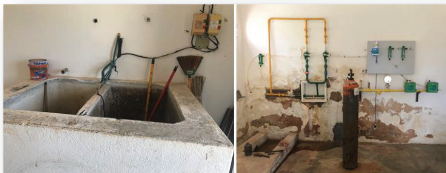
Figura 36 - Preparo do PAC e do Polímero, e dosagem do cloro gasoso, respectivamente.
