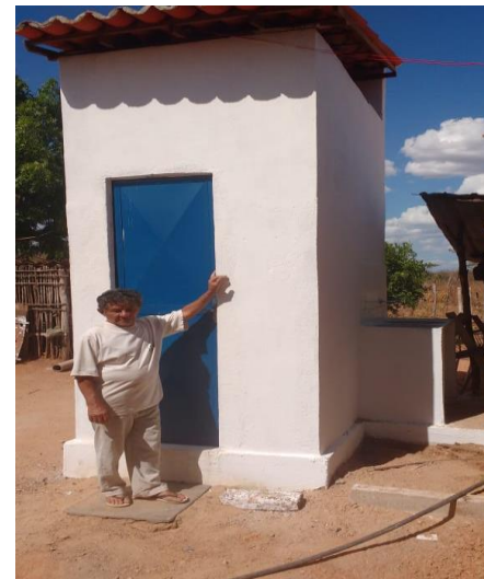
Módulo Sanitário em Sobral/CE
