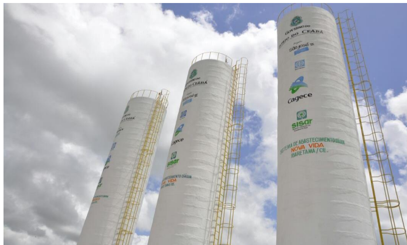
Sistema de Abastecimento de Ibaretama/CE
