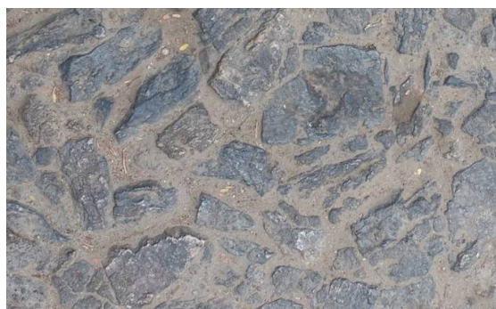
Foto 2 – Pavimentação da Rua José Leônicio da Ponte, em pedra tosca
