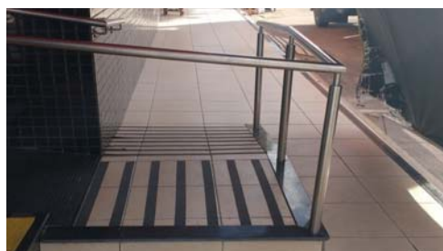
Foto 7 – Calçada obstruída por rampa de acesso à loja e toldo na Av. D. Aureliano Matos
