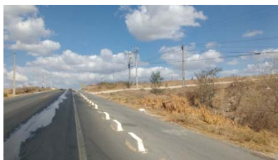
Foto 6 – Ciclovia CE – 265 Fonte: Consórcio Prodeurb, 2017
