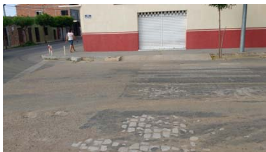
Foto 3 – Irregularidade na pavimentação da Rua Ver. Eféisio Costa
