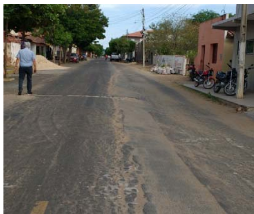
Foto 1 – Rua Manoel Gonçalves e Rua Vereador Efísio Costa
