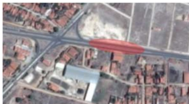
Figura 44 – CE-356 com Rua Lima Ramalho
