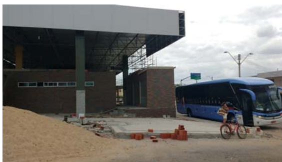
Foto 7 – Nova Rodoviária em construção na Av. Sen. Ozires Pontes
