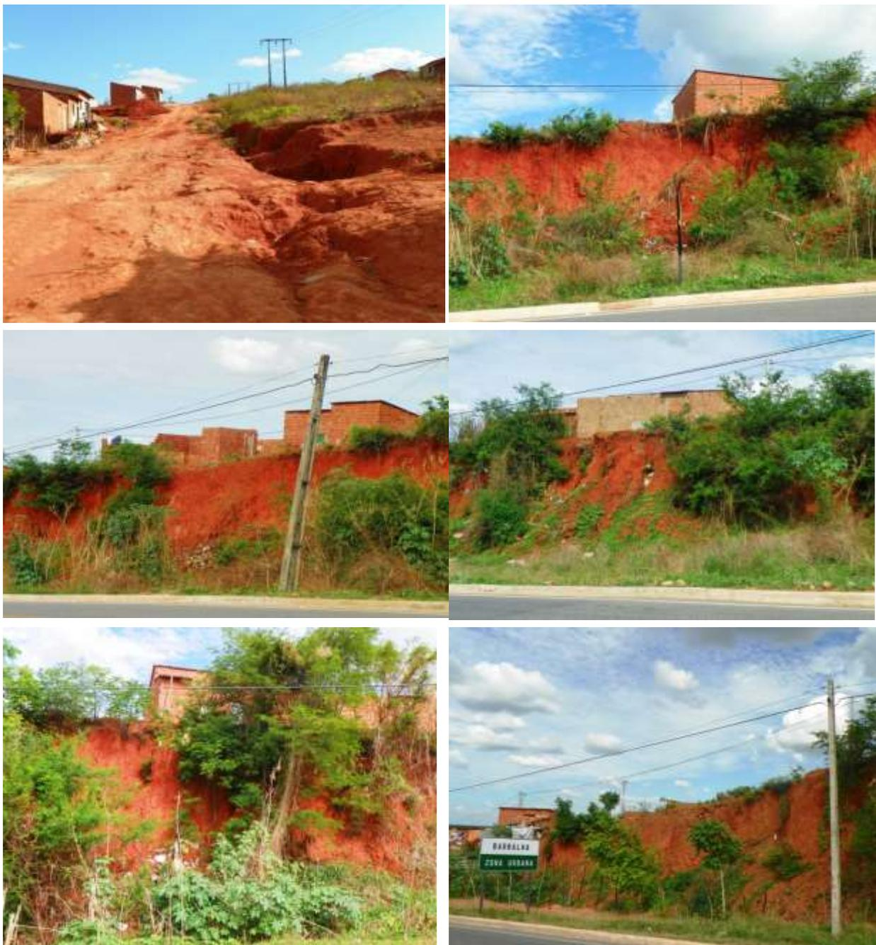
**Figura 7.102** – Áreas de risco de desmoronamento de encostas e deslizamento de residências no Conjunto do Preolândia.
