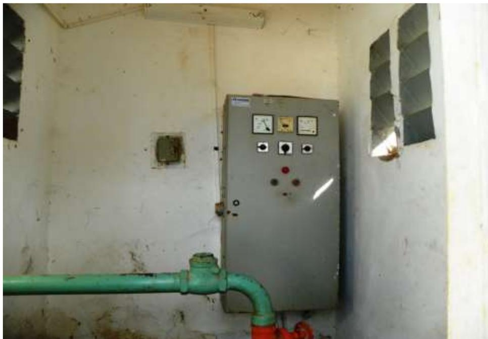
**Figura 7.14** – Vista da única estação elevatória de água tratada (EEAT-01) da sede de Barbalha que faz o recalque do RAP-01 para o RAP-04, abastecendo a área Prourb.
