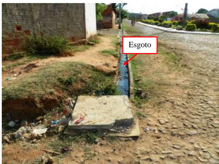
**Figura 7.95** – Vista de sarjeta na Av. Costa Cavalcante escoando esgoto a céu aberto.
