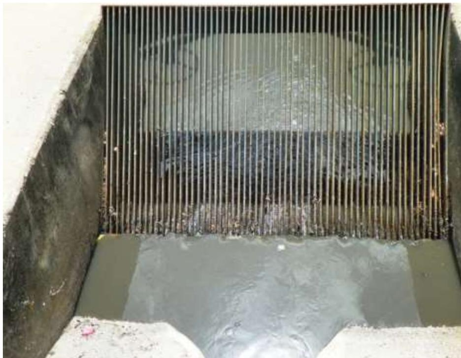
**Figura 7.43** – Vista do Tratamento Preliminar de Esgotos (Gradeamento, Caixas de Areia e Calha Parshall) da ETE existente no município de Barbalha.
