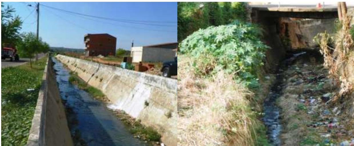
**Figura 7.84** – Canal do Riacho do Ouro: trecho em condições razoáveis de conservação (esquerda) e trecho em péssimas condições (direita).
