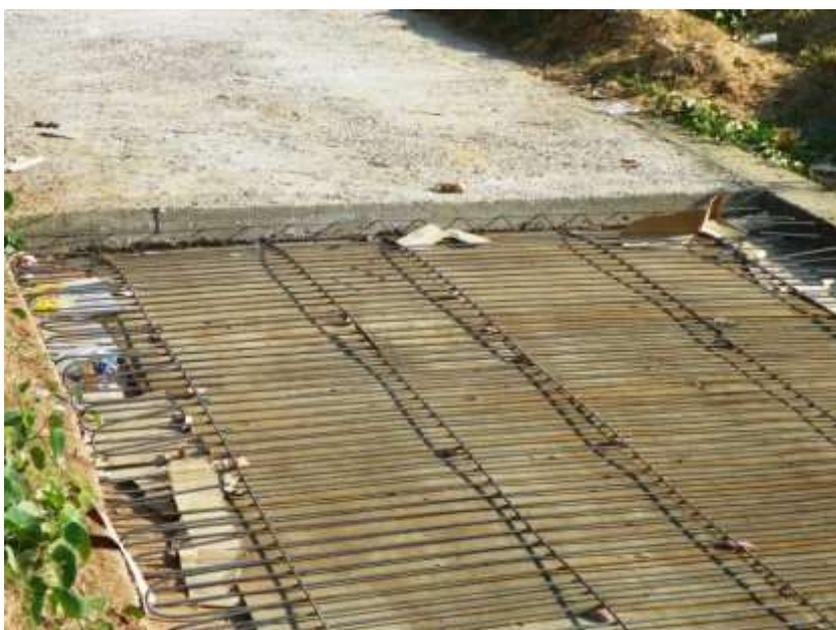
**Figura 7.78** – Trecho em obras do Canal do Cirolândia destacando cobertura em concreto armado.
