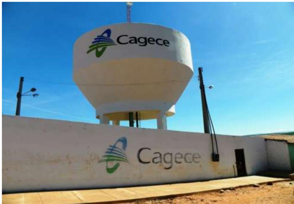
**Figura 7.20** – Vista do reservatório elevado REL-03 com 300 m<sup>3</sup> de capacidade, localizado no bairro Bela Vista, sede de Barbalha.
