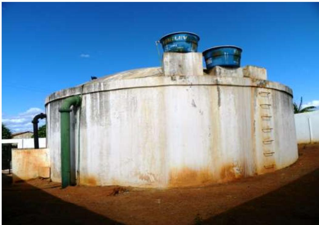
**Figura 7.12** – Vista do sistema de desinfecção simples localizado no reservatório apoiado RAP-02 com 350 m<sup>3</sup> de capacidade, localizado no Centro, sede de Barbalha.
