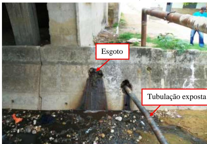
**Figura 7.91** – Detalhe de tubulação clandestina de esgoto obstruída e de tubulação exposta no Canal do Riacho do Ouro.
