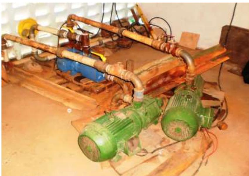
**Figura 7.26** – Estação elevatória de água bruta instalada no Balneário Caldas, que atende ao distrito de Caldas, no município de Barbalha.
