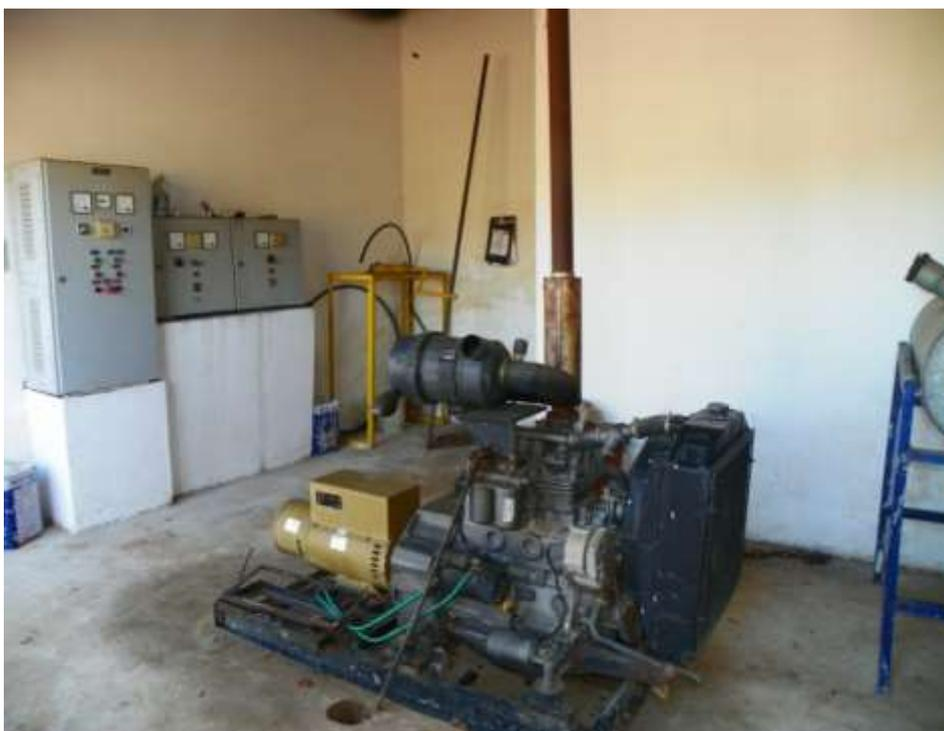
**Figura 7.39** – Vista da estação elevatória de esgoto EEE-01, quadro de comando e grupo gerador, integrantes do sistema de esgotamento sanitário de Barbalha.
