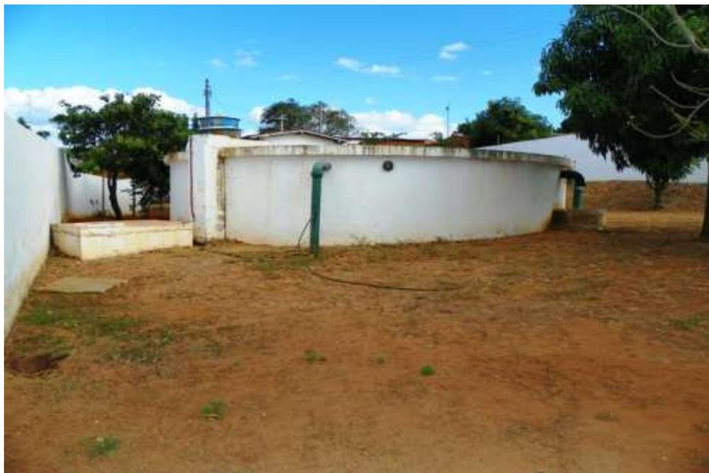
**Figura 7.15** – Vista do reservatório apoiado RAP-01 com 400 m<sup>3</sup> de capacidade, localizado no bairro Alto do Gamenha, sede de Barbalha.
