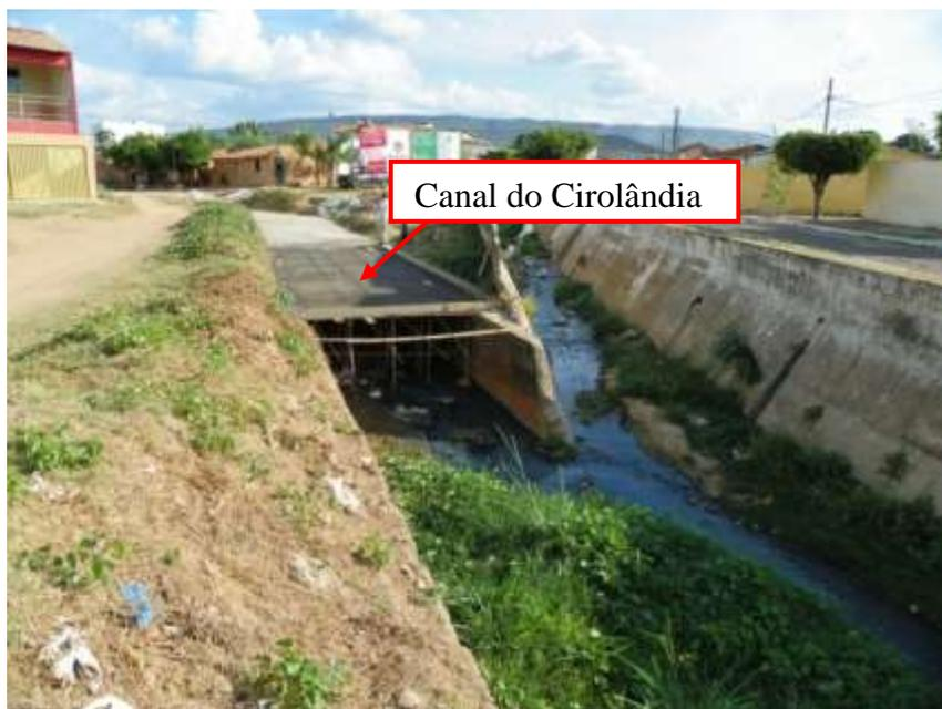
**Figura 7.77** – Trecho de execução da obra de cobertura do Canal do Cirolândia na sua junção com o Canal do Riacho do Ouro.
