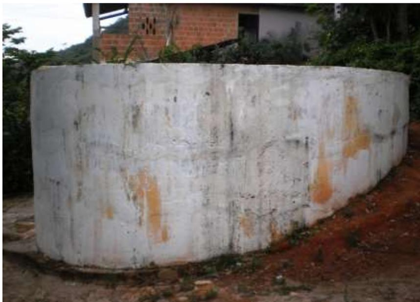
**Figura 7.27** – Reservatório apoiado RAP-01 de 10 m<sup>3</sup> que atende ao distrito de Caldas, no município de Barbalha.
