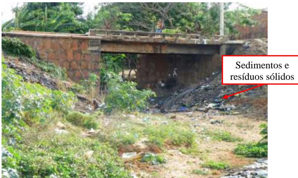
**Figura 7.75** – Presença de sedimentos e lixo na calha do Riacho do Betoque (Rua Crato).
