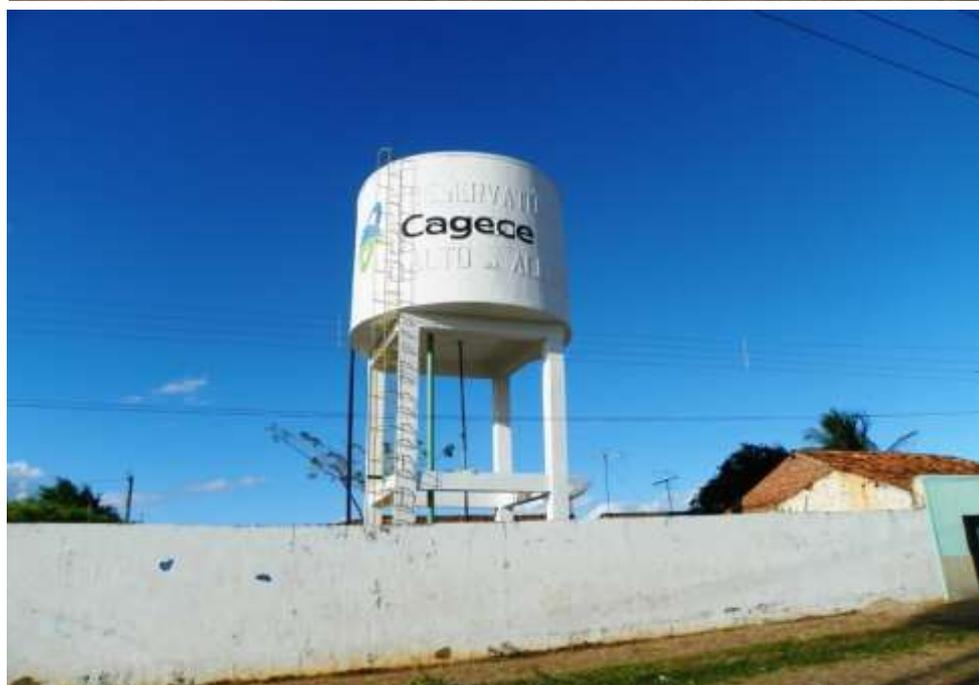
**Figura 7.18** – Vista do reservatório elevado REL-01 com 100 m<sup>3</sup> de capacidade, localizado no bairro Alto da Alegria, sede de Barbalha.
