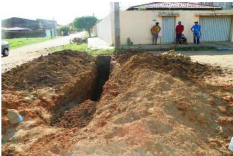
**Figura 7.79** – Abertura de vala nas proximidades do Canal do Cirolândia para implantação de infraestrutura de microdrenagem.
