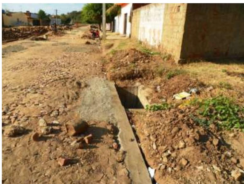
**Figura 7.80** – Detalhe de infraestrutura de microdrenagem para coleta e escoamento de águas pluviais para o Canal do Cirolândia.
