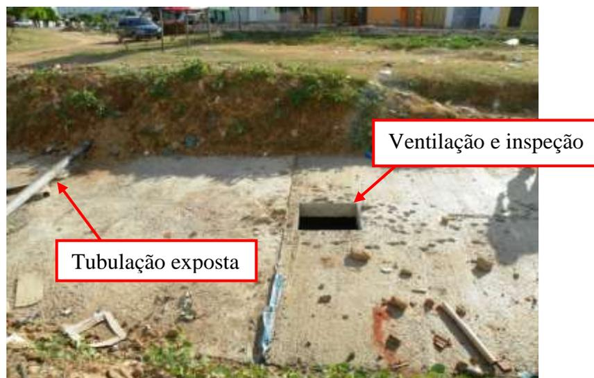
**Figura 7.82** – Trecho coberto do Canal do Cirolândia, destacando tubulação aérea e janela para ventilação e inspeção sem proteção.
