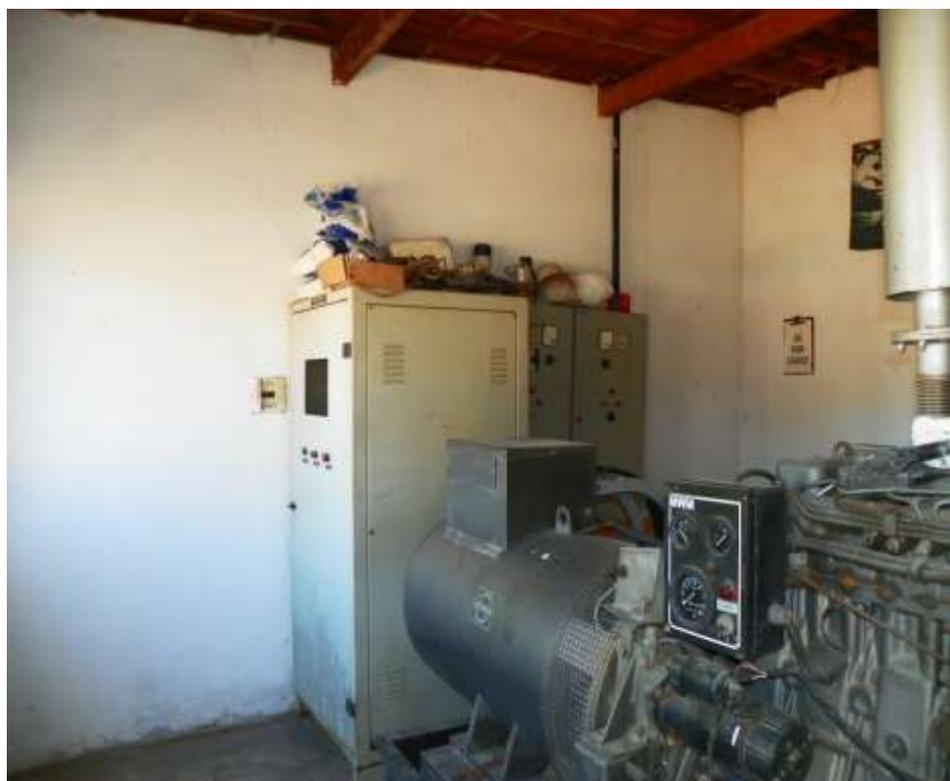
**Figura 7.40** – Vista da estação elevatória de esgoto EEE-02, quadro de comando e grupo gerador, integrantes do sistema de esgotamento sanitário de Barbalha.
