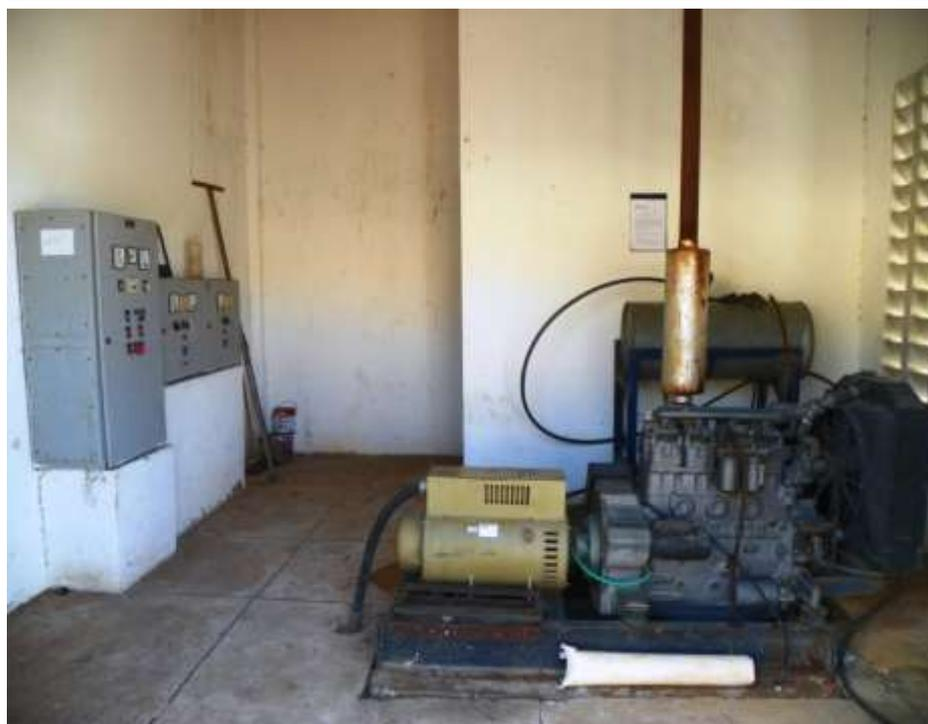
**Figura 7.41** – Vista da estação elevatória de esgoto EEE-03, quadro de comando e grupo gerador, integrantes do sistema de esgotamento sanitário de Barbalha.
