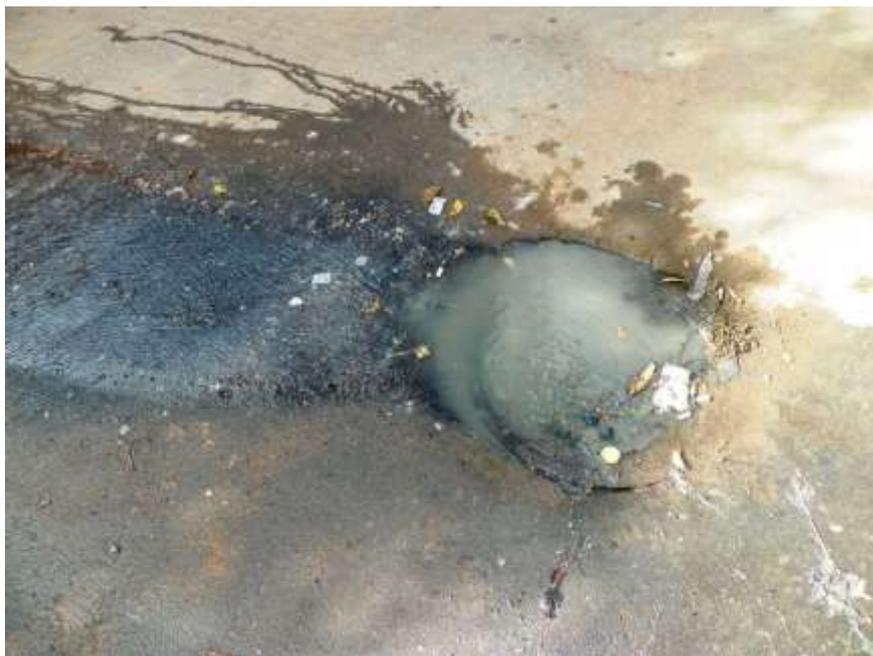
**Figura 7.35** – Vista do extravasamento de esgotos na rede coletora existente em Barbalha.
