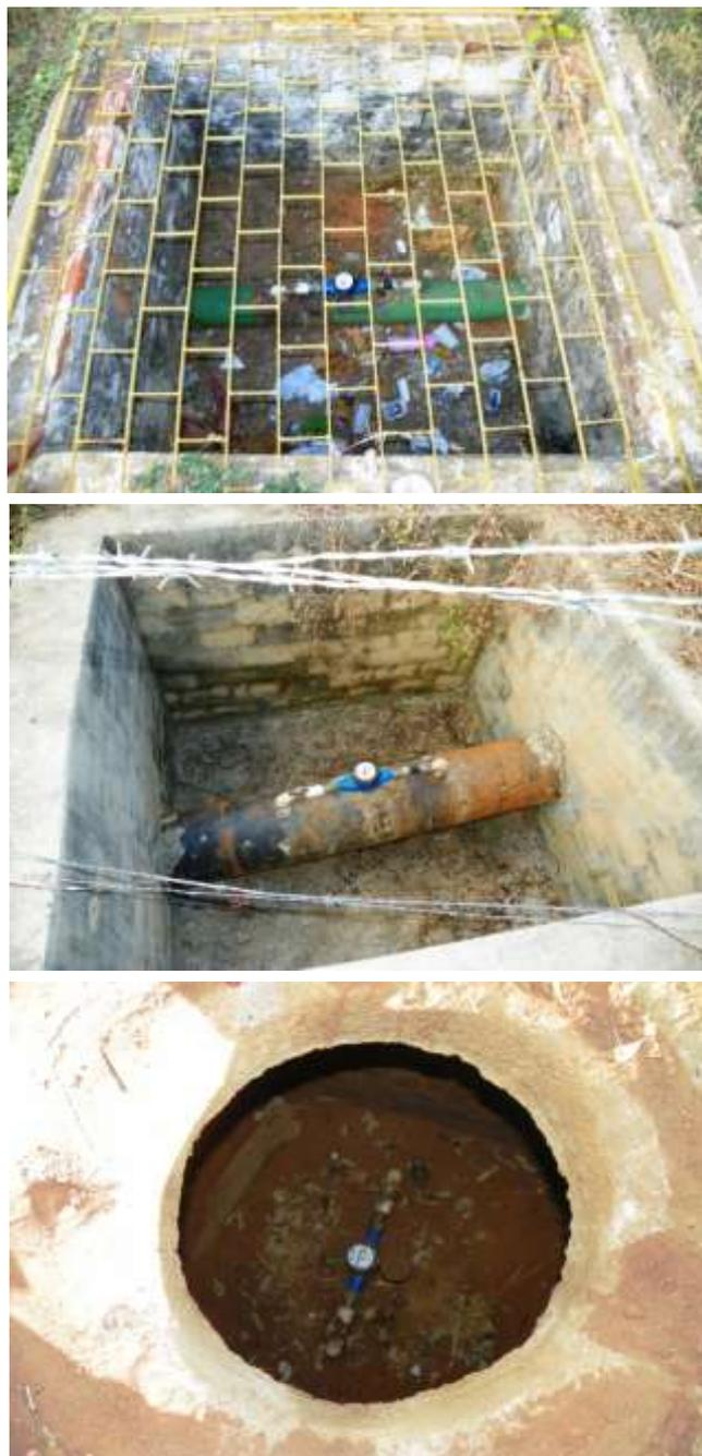
**Figura 7.10** – Vista de alguns dos macromedidores instalados na linha de adução dos poços tubulares PT-01, PT-02 e PT-05.
