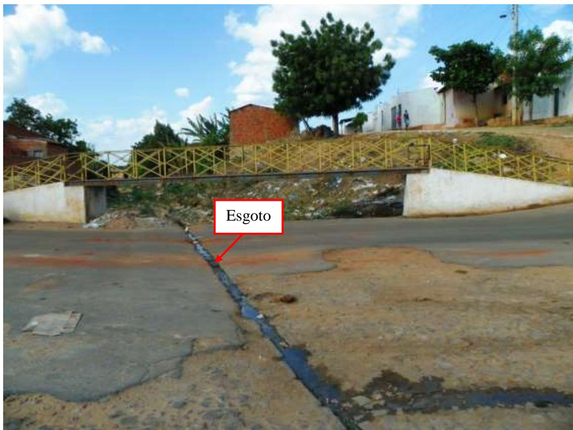
**Figura 7.93** – Vista de sarjeta com esgoto escoando a céu aberto na Av. Julis Rimet.
