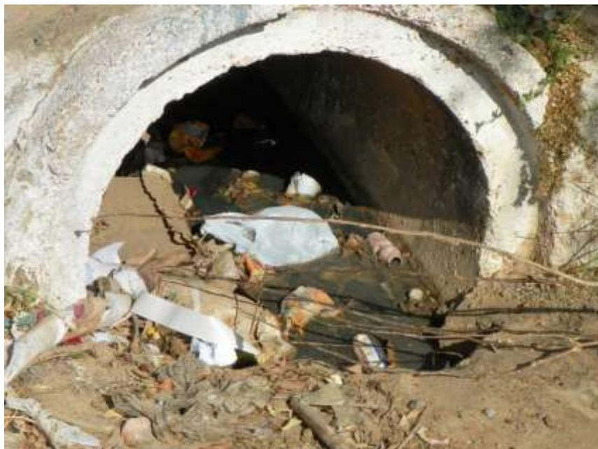
**Figura 7.94** – Vista de boca de lobo na Rua T Vinte e Dois obstruída por lixo.
