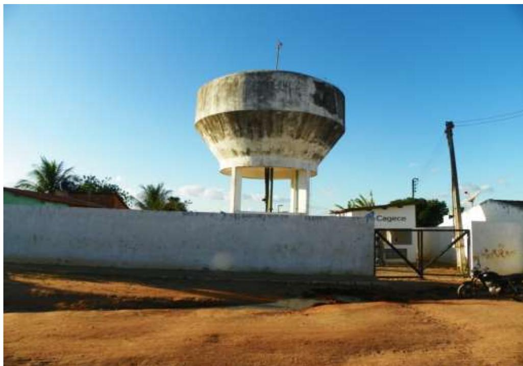
**Figura 7.21** – Vista do reservatório elevado REL-05 com 200 m<sup>3</sup> de capacidade, localizado no bairro Malvinas, sede de Barbalha.
