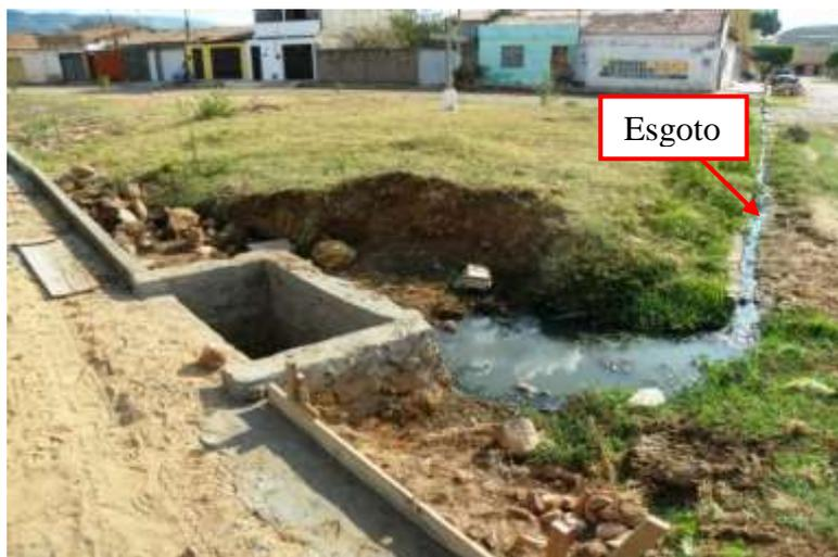
**Figura 7.83** – Escoamento de esgoto para o Canal do Cirolândia.
