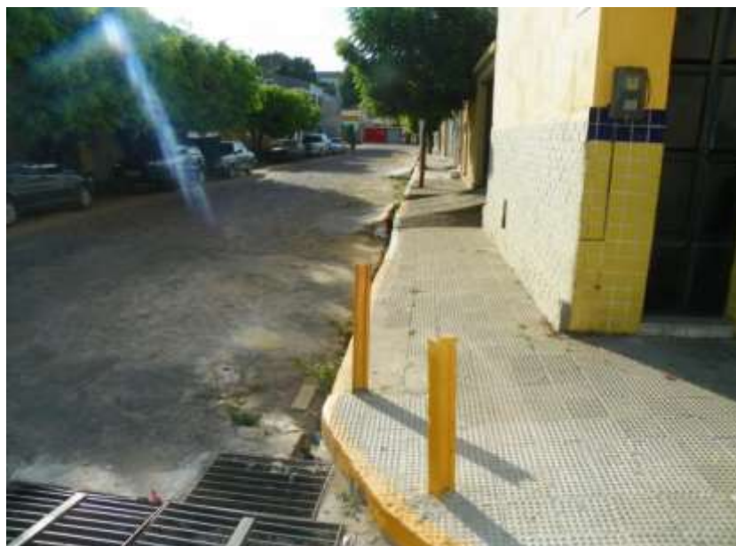
Figura 5.12 – Área de alagamento e inundação na Rua Pedro Coelho. Fonte: Consórcio DGH-Cariri (2011).
