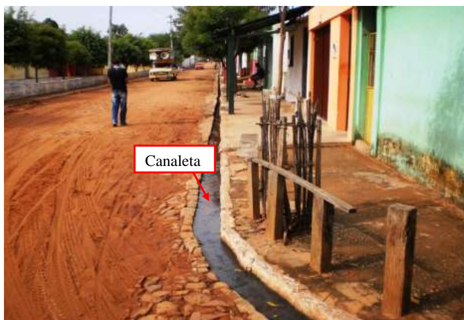
Figura 5.13 – Drenagem superficial no distrito de Estrela. Fonte: Consórcio DGH-Cariri (2011).
