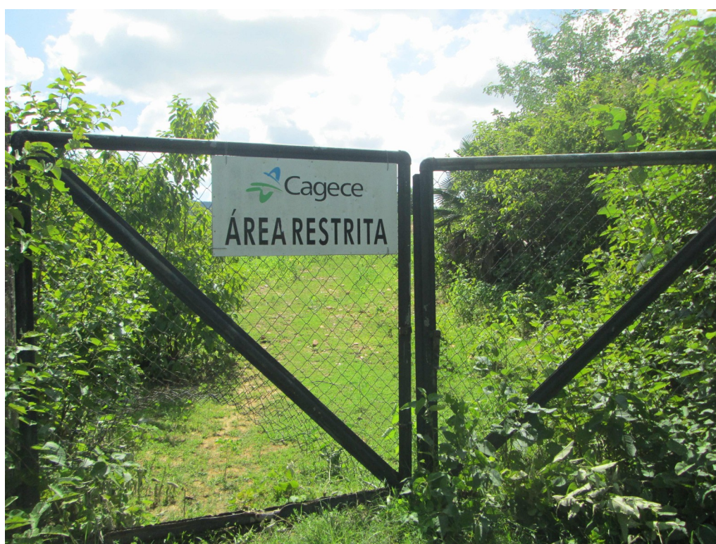
Figura 41 – Entrada da Estação de Tratamento de Esgoto (ETE-Guaiúba).
