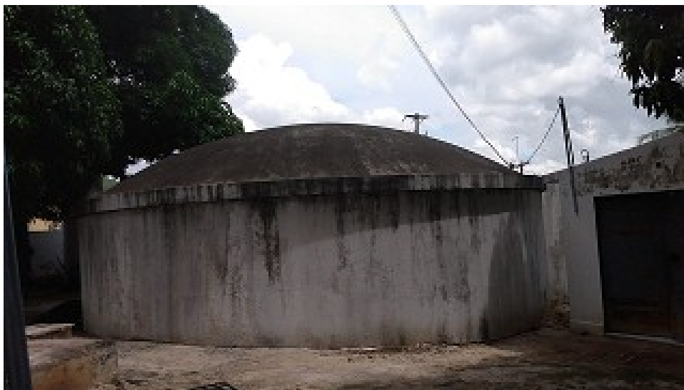
Figura 23 – Reservatório Apoiado (RAP-01).
