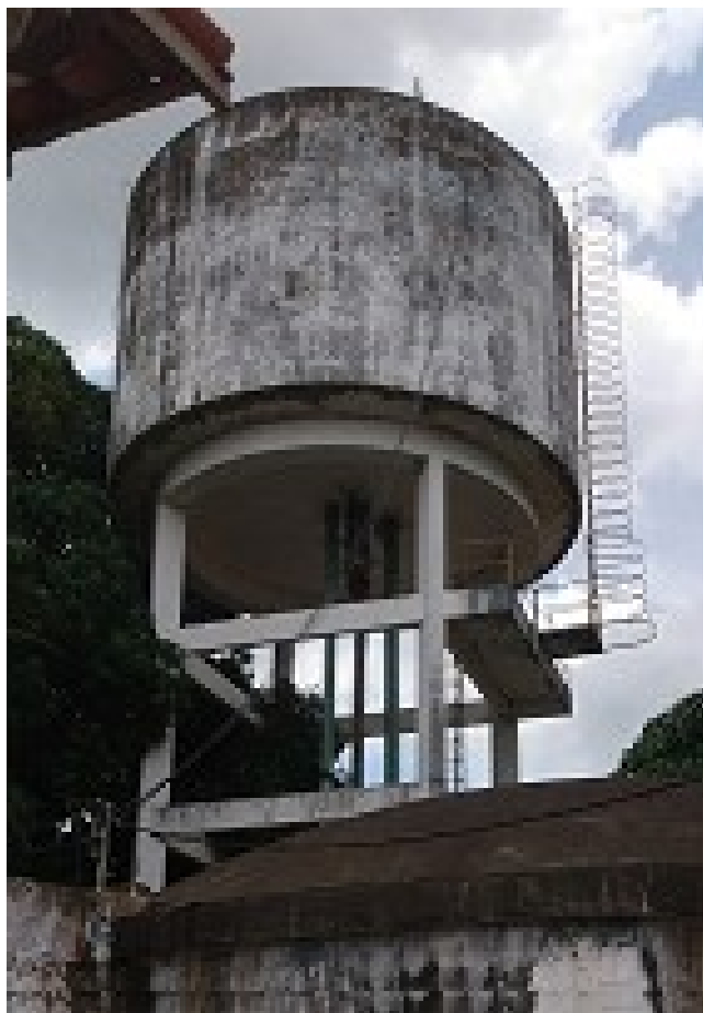
Figura 24 – Reservatório Elevado REL-01.
