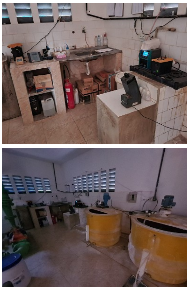
Figura 33 – Laboratório de análise e interior da ETA dosadora de hypocal.
