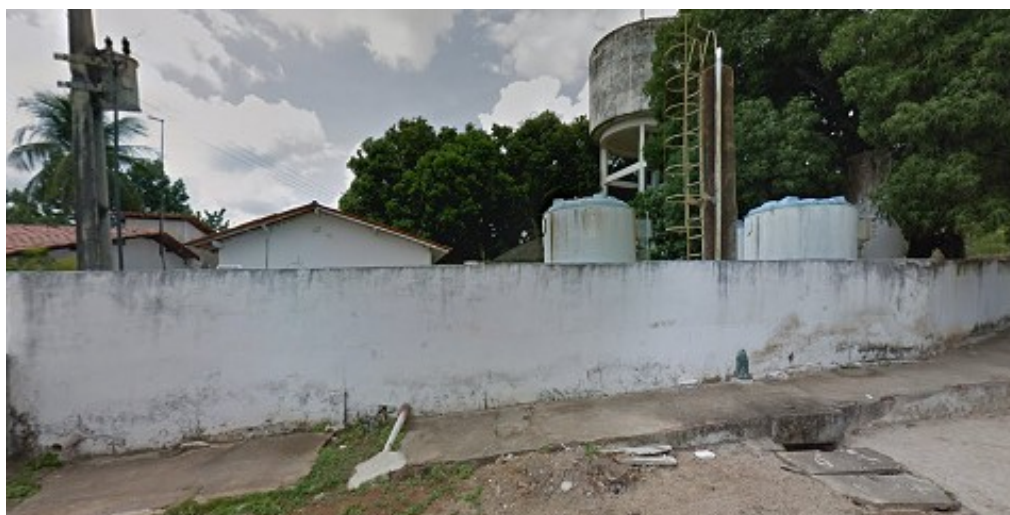
Figura 20 – Fachada da ETA Guaiúba.
