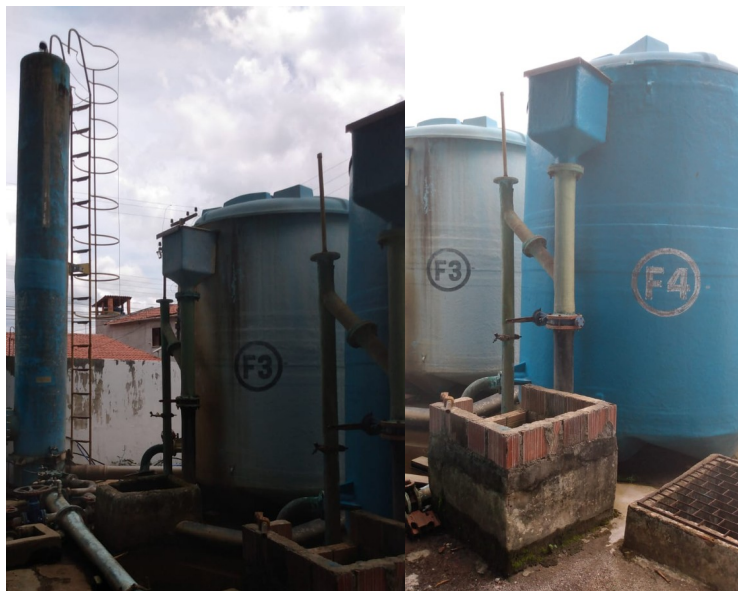
Figura 25 – Torre de nível e filtros.
