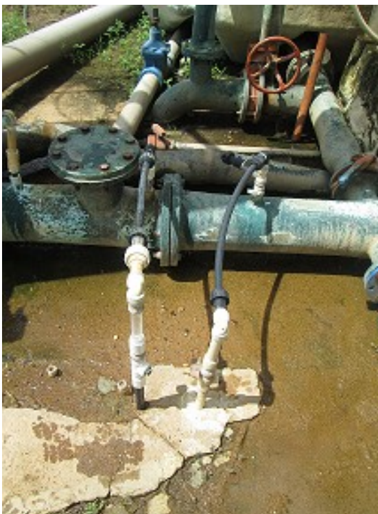
Figura 26 – Ponto de aplicação de PAC23 e polímero catiônico.
