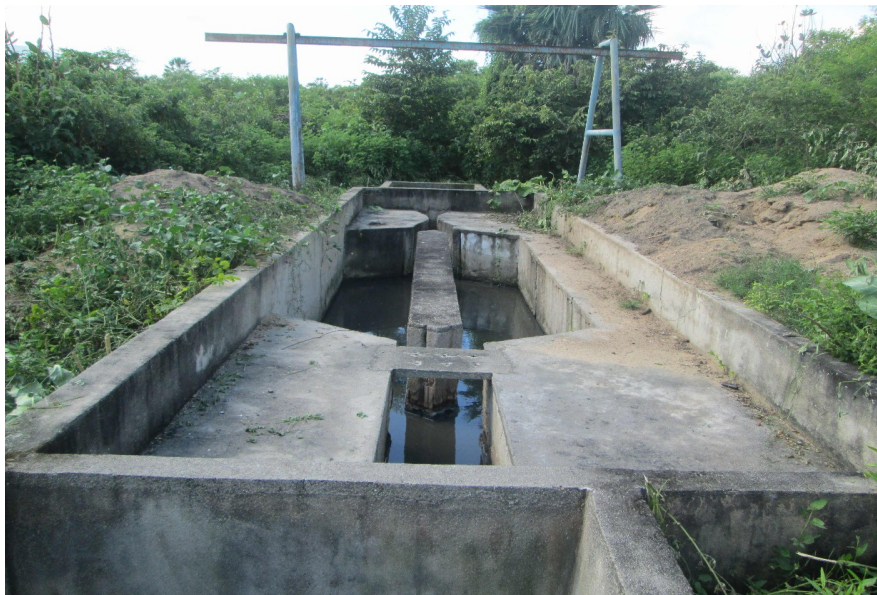
Figura 42 – Caixa de areia com calha Parshall na ETE Guaiúba.
