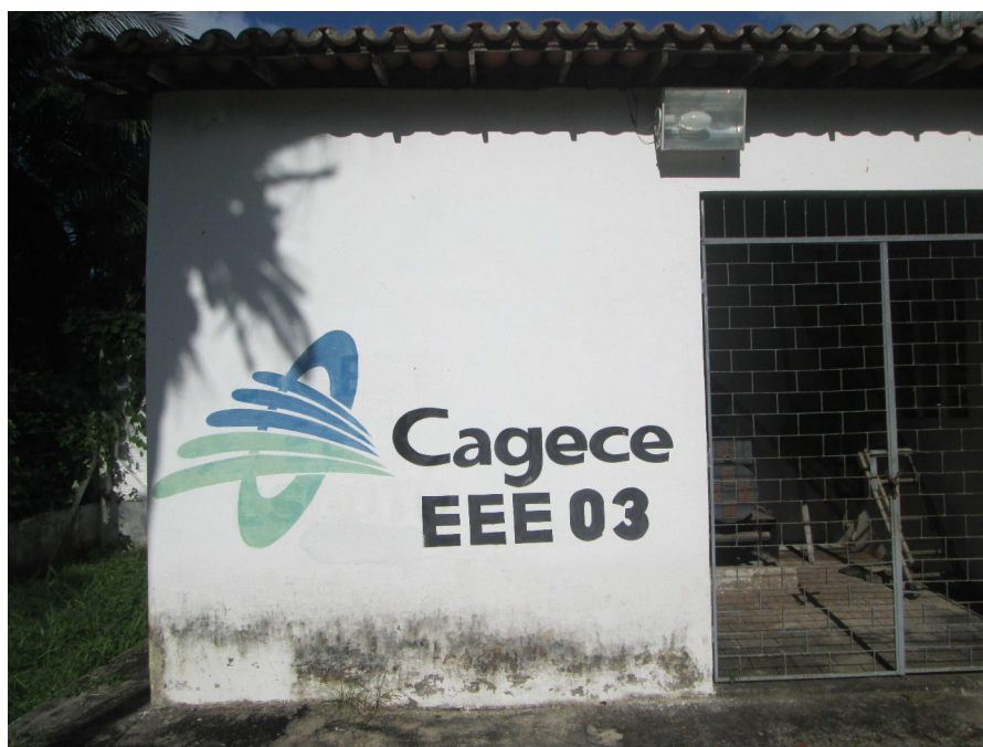
Figura 40 – Estação Elevatória de Esgoto – EEE 03 do distrito Sede de Guaiúba.
