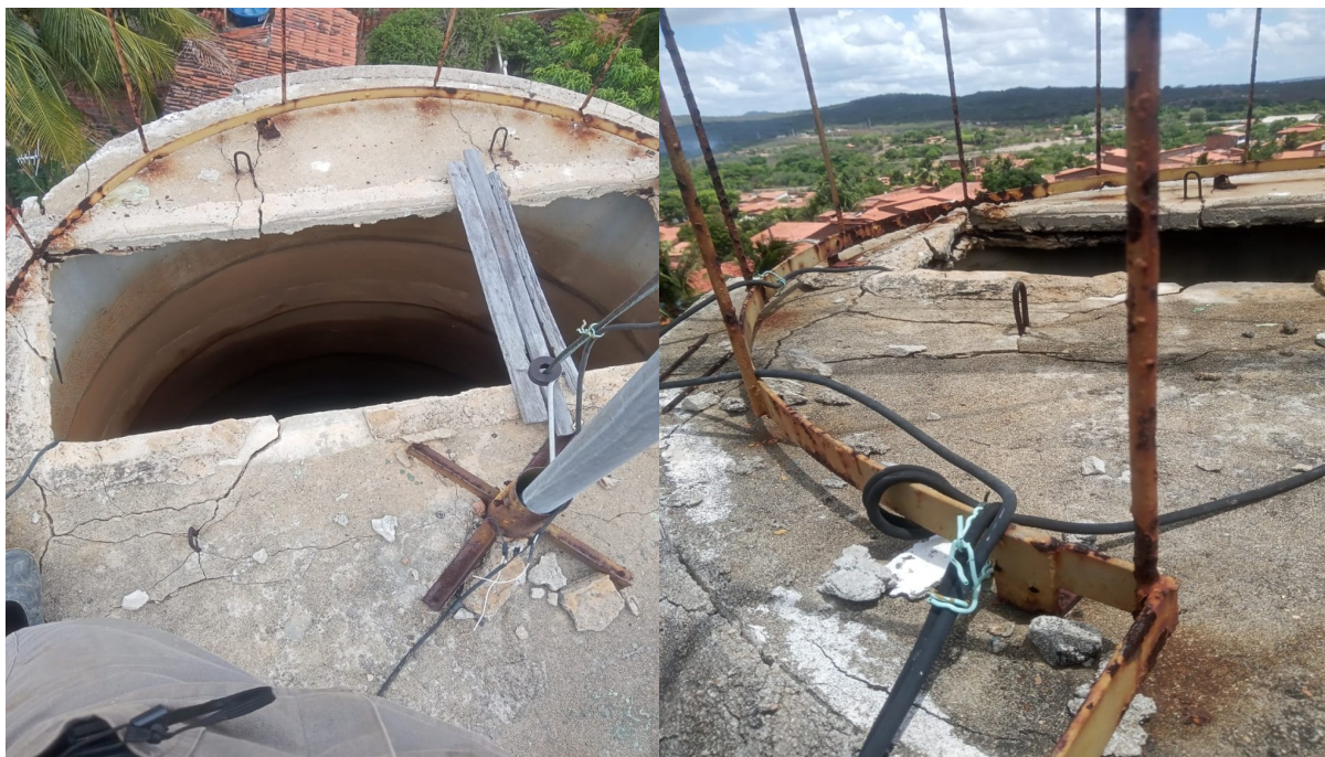
Figura 35 – Reservatório elevado (REL-01).
