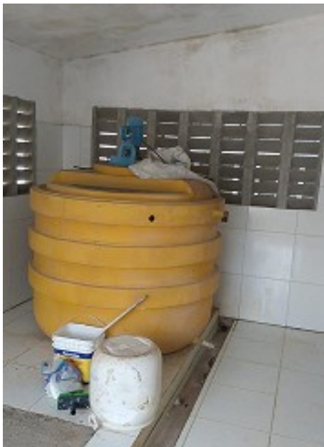
Figura 27 – Tanque de mistura de produtos químicos.
