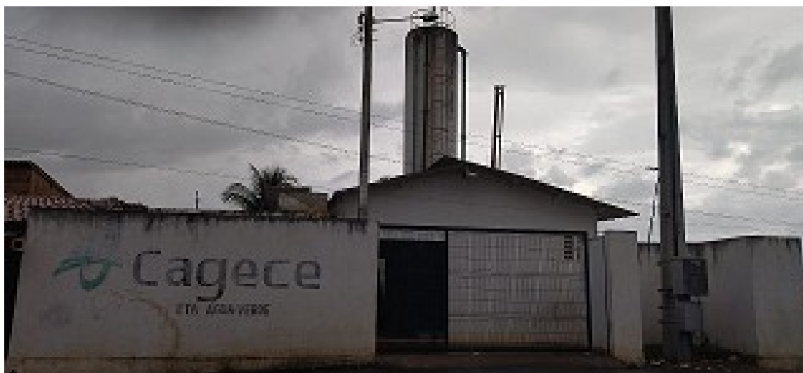
Figura 32 – Fachada da ETA Água Verde.
