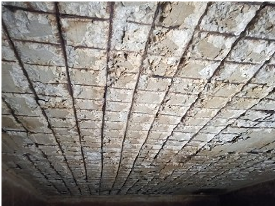
Figura 36 – Interior do reservatório apoiado (RAP-01)
