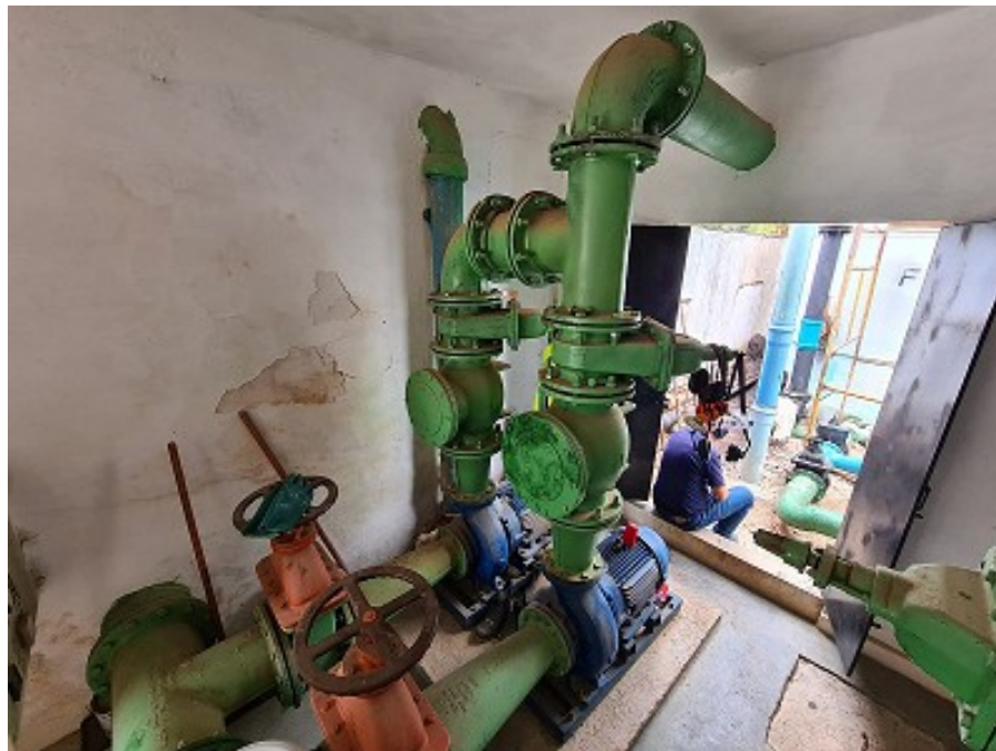
Figura 34 – Interior da ETA: Bombas de lavagem de filtro
