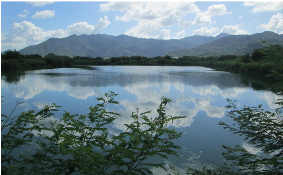
Figura 46 – Lagoa de maturação 02 na ETE Guaiúba.
