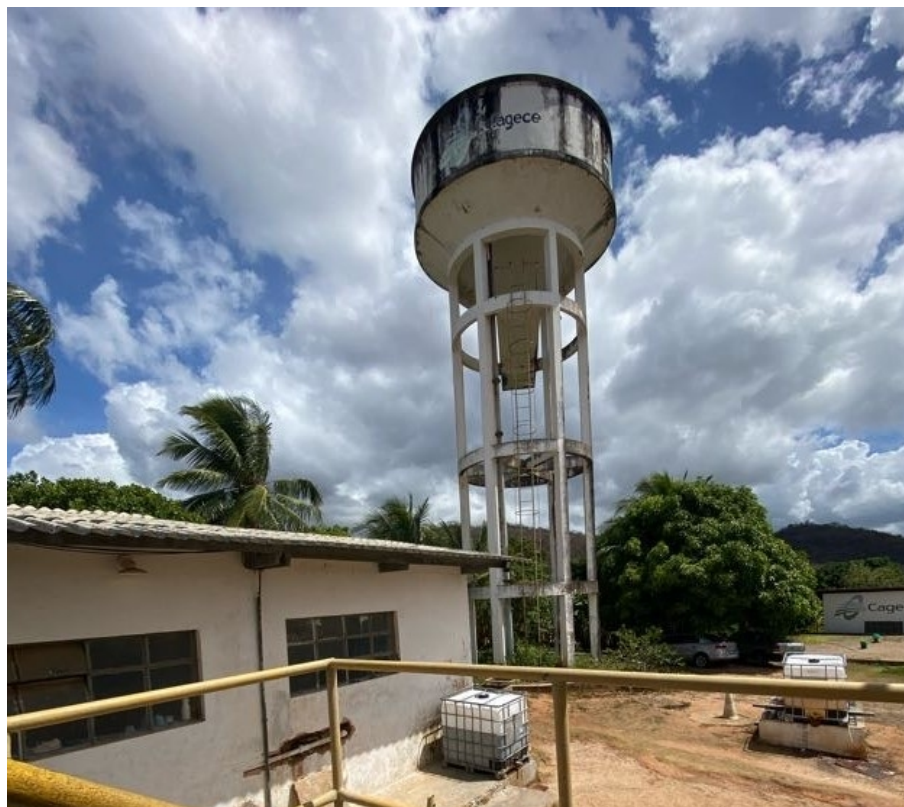
Figura 43 – REL de 100 m³ da ETA Sapupara.
