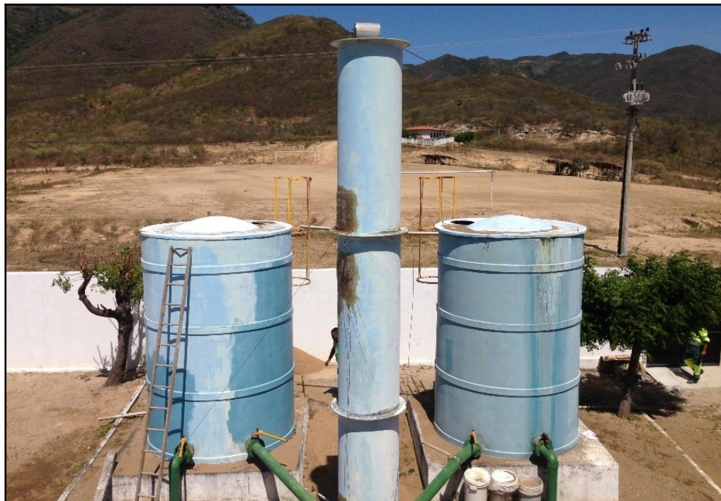
Figura 48 – Torre de Equilíbrio da ETA Itapebussu.
