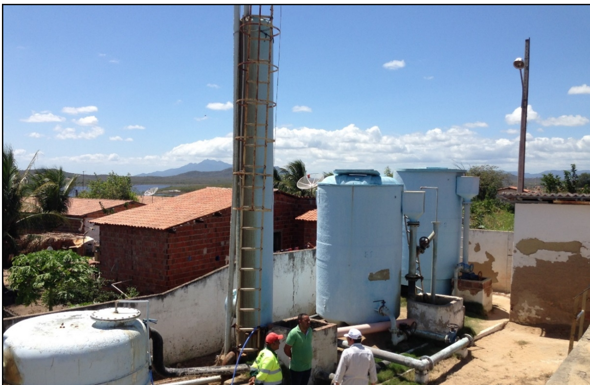
Figura 59 – Torre de Nível da ETA Amanari.
