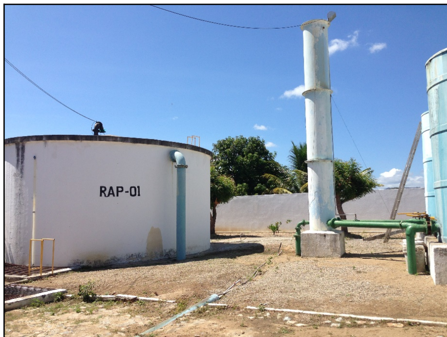
Figura 55 – RAP de 150 m³ da ETA Itapebussu.
