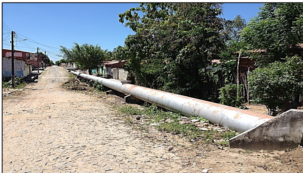
Figura 16 – Adutora de Água Bruta, DN 800.
