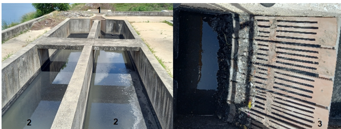
Figura 70 – Unidade de tratamento preliminar: gradeamento, caixa de areia e Calha Parshall.
