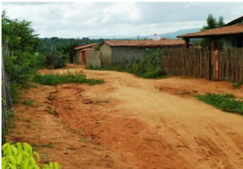
Figura 5.23 – Formação de voçoroca em vias urbanas do distrito de Missão Nova. Fonte: Consórcio DGH-Cariri (2012).
