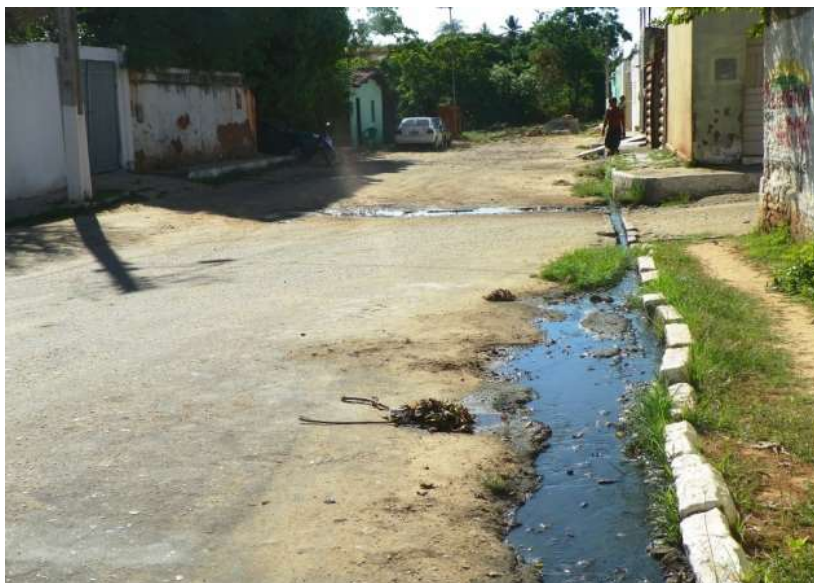
Figura 5.2 – Esgoto a céu aberto na sede de Missão Velha. Fonte: Consórcio DGH-Cariri (2011).
