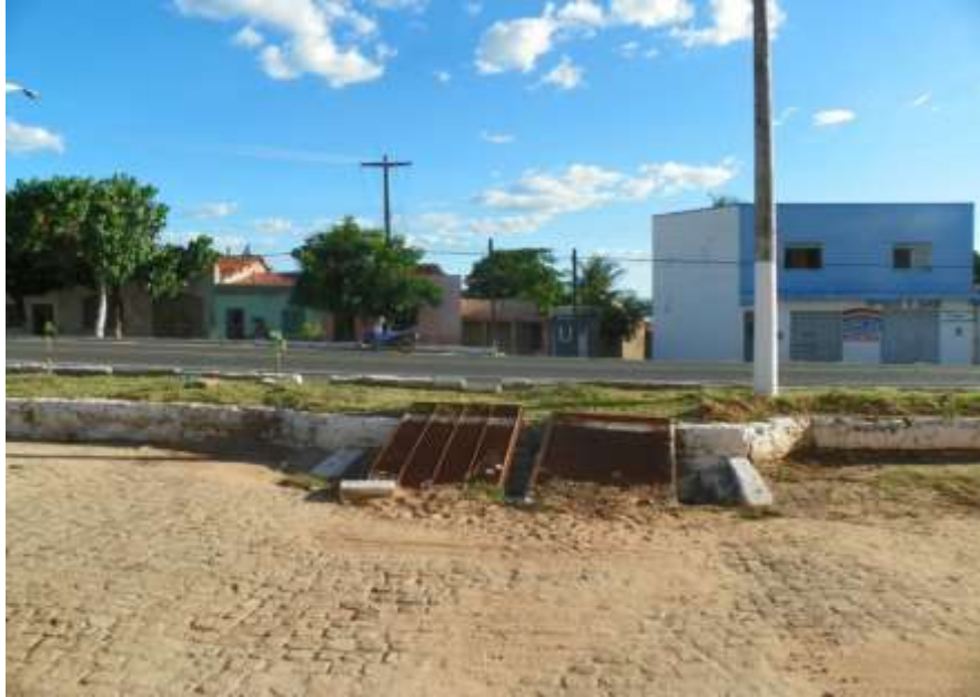
Figura 5.21 – Galeria localizada na Rua Cel. José Dantas. Fonte: Consórcio DGH-Cariri (2012).
