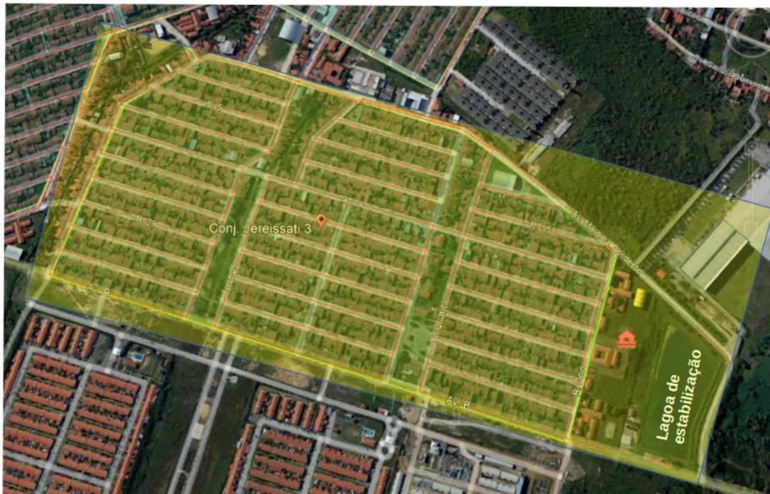
Figura 41 – Rede coletora de esgoto no Conjunto Jereissati III no município de Pacatuba-CE.
