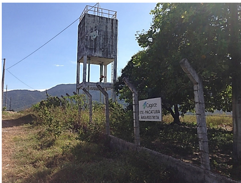
Figura 35 – Reservatório Elevado para água de reúso (ETE Pacatuba).
