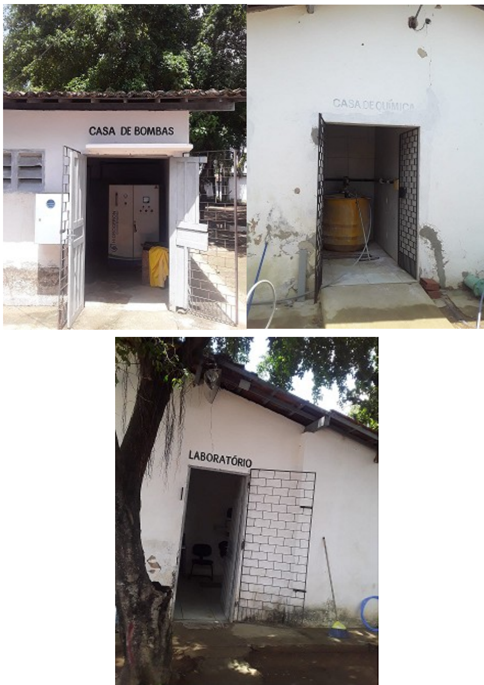
Figura 27 – Casa de bombas, Casa de Química e Laboratório em Pavuna.
