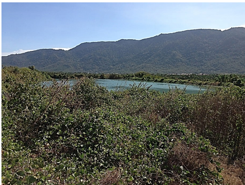
Figura 39 – Lagoa de Maturação – ETE Pacatuba.
