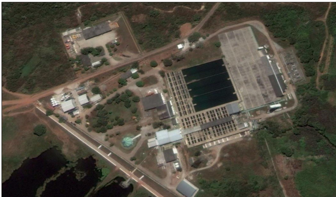
Figura 29 – Vista aérea da ETA Gavião
