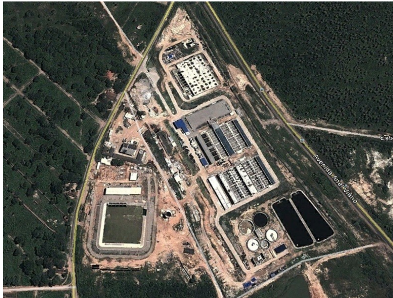
Figura 30 – Vista Aérea da ETA Oeste
