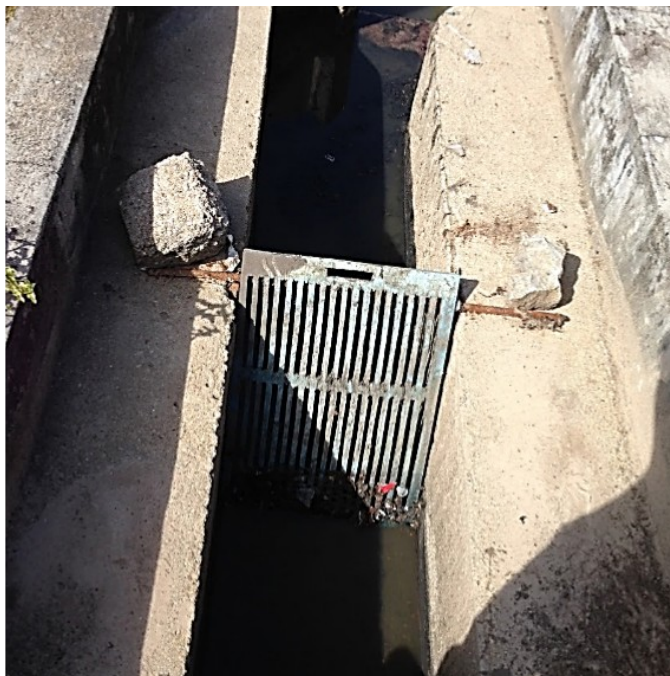
Figura 36 – Gradeamento existente na ETE Pacatuba.
