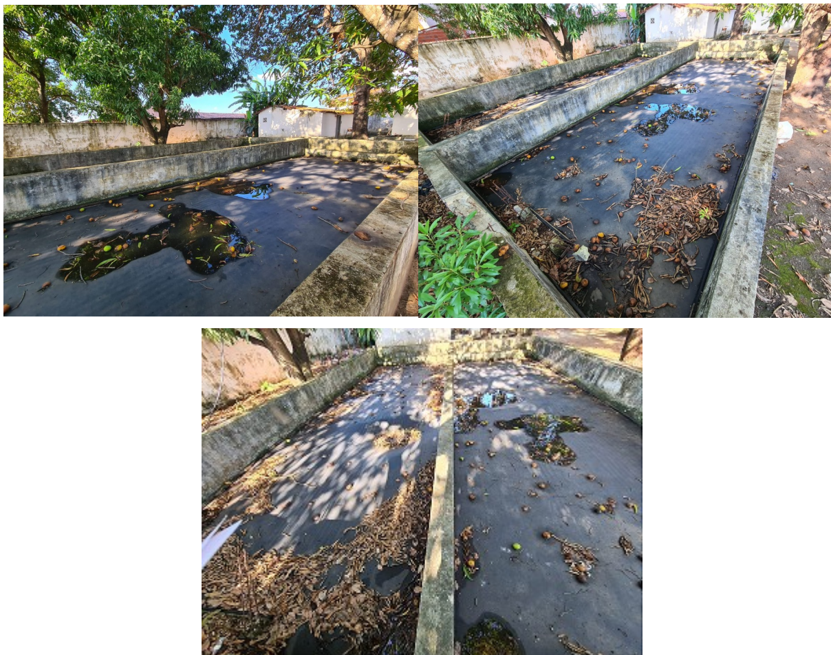
Figura 28 – ETRG desativada da ETA Pavuna.
