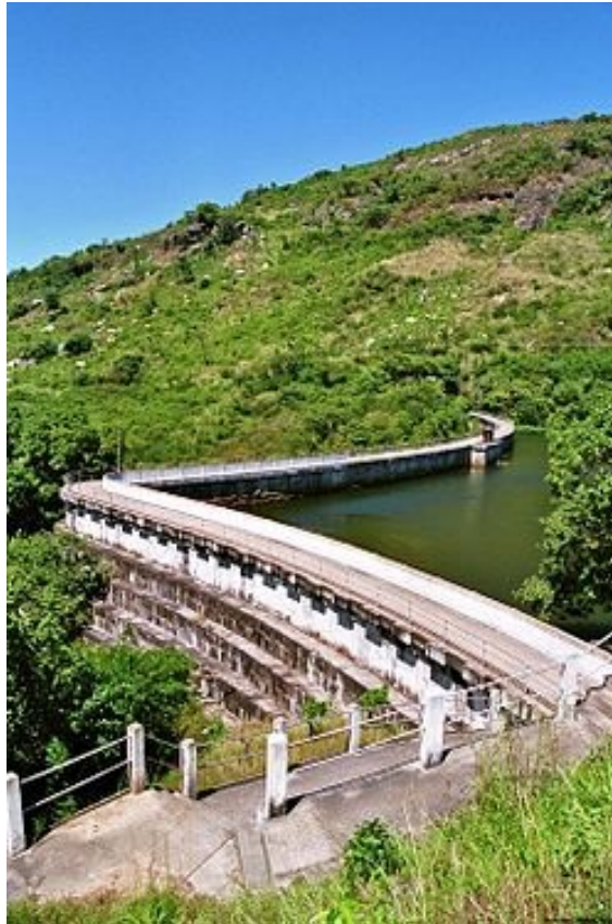
Figura 15 – Captação flutuante – Açude Acarape do Meio.
