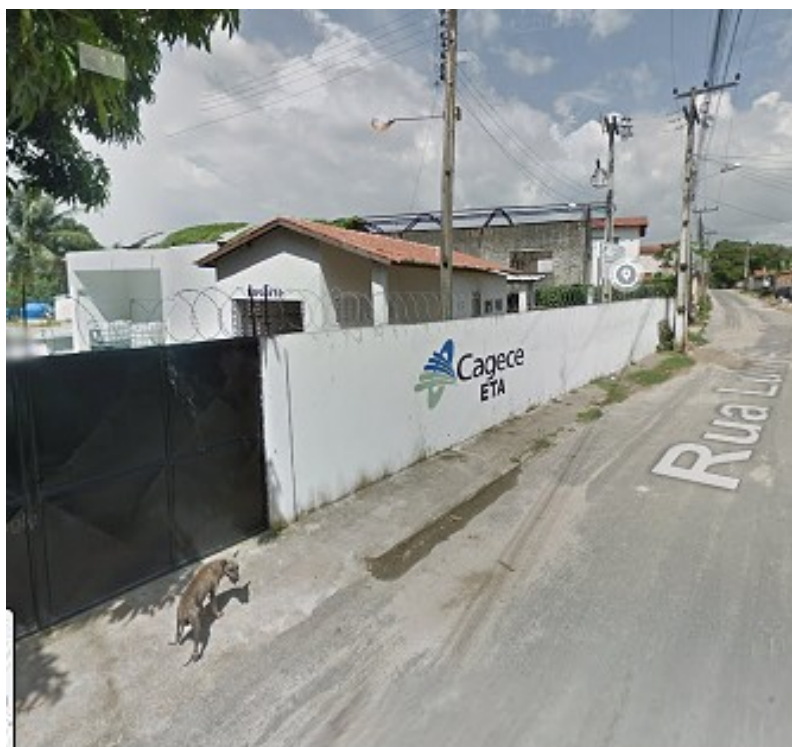
Figura 16 – Entrada da ETA de Pacatuba.
