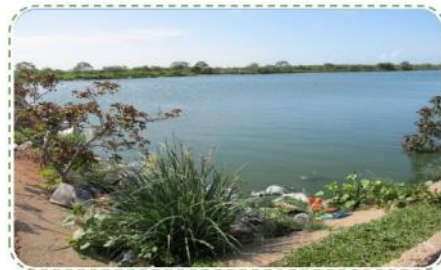
Lagoa de Tratamento de Efluentes com incidência de resíduos lançados no lixo municipal próximo. Necessidade de desassoreamento.
