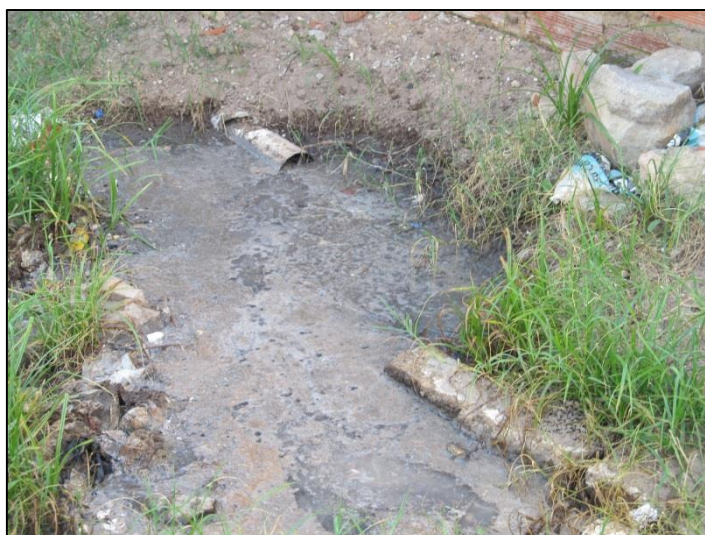
Figura 6.2 - Ponto com lançamento irregular de esgotos no bairro CCF.
