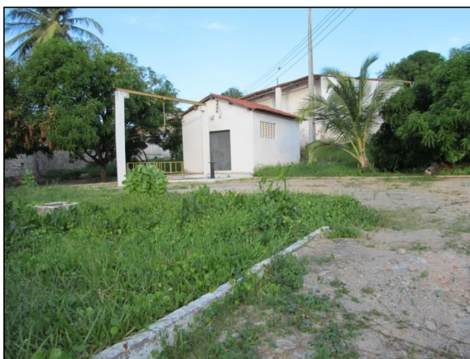
Figura 6.6 - Estação Elevatória de Esgotos da localidade Boca do Poço (EEE1)
