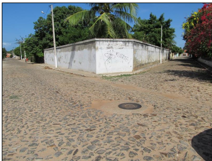
Figura 6.4 - Último ponto da rede coletora de esgotos.
