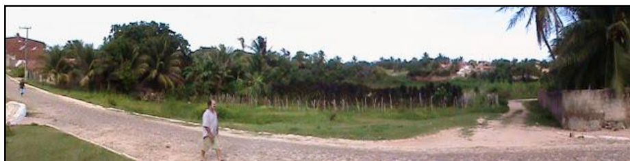
Figura 2.11 - Pavimentação fora do centro urbano de Paracuru.
