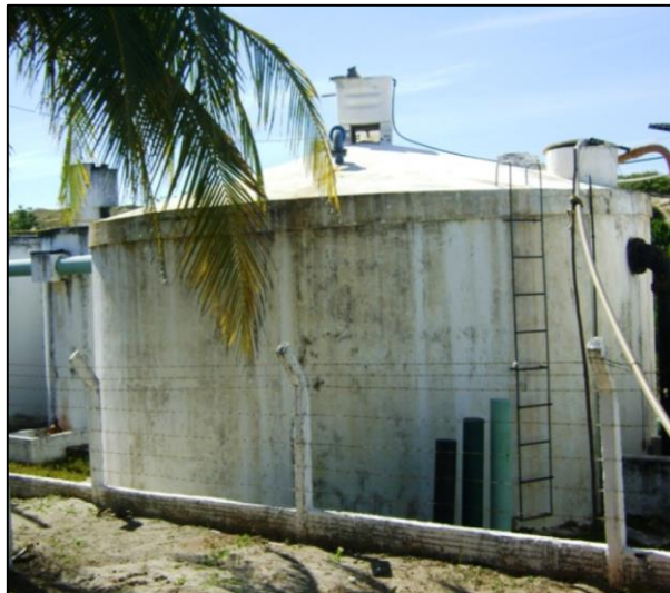
Figura 5.15 - Reservatório Apoiado (RAP-01) Fonte: ARCE (2011)
