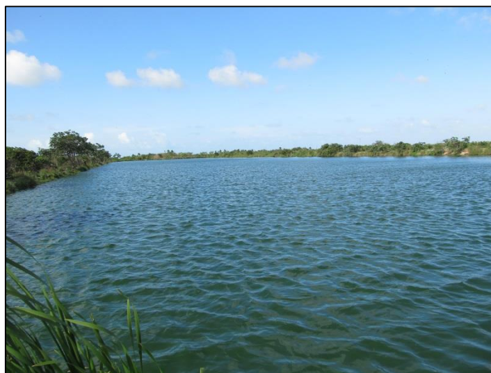
Figura 6.11 - Lagoa de Tratamento de esgotos de Paracuru
