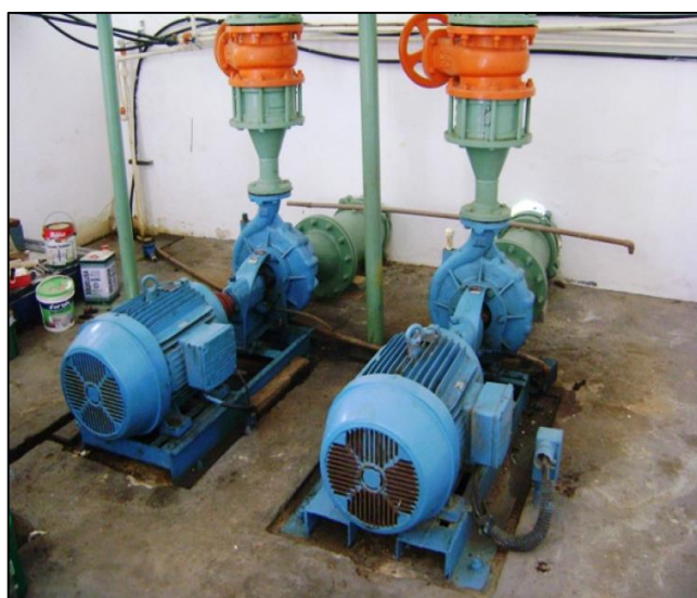
Figura 5.21 - Conjuntos motores-bomba
