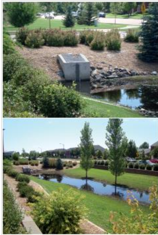
Figura 6.5 - Exemplo de reservatórios de detenção em loteamentos
