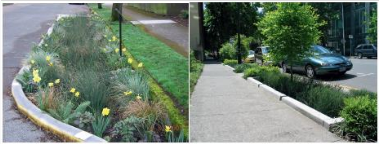
Figura 6.7 - Exemplo de valas de infiltração
