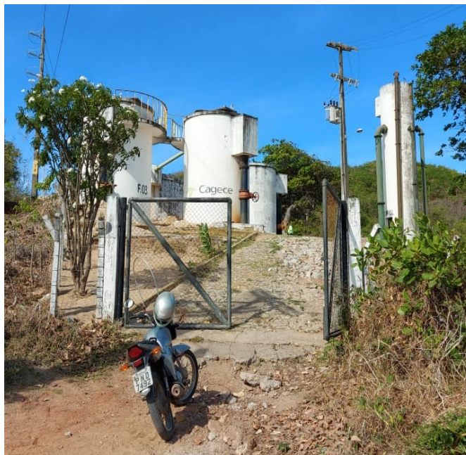
Figura 38: Fachada da ETA Pecém.
