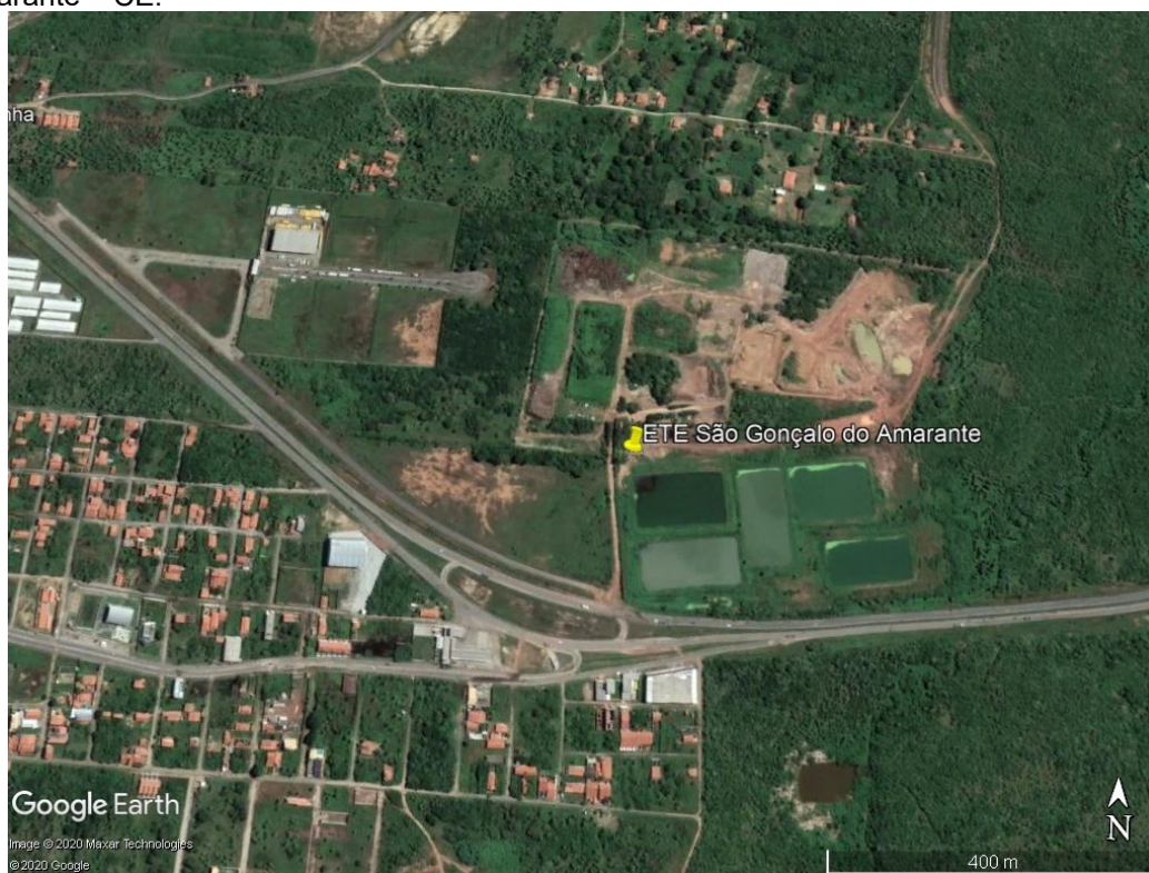
Figura 72: Vista aérea da Estação de Tratamento de Esgoto da Sede do município de São Gonçalo do Amarante – CE.
