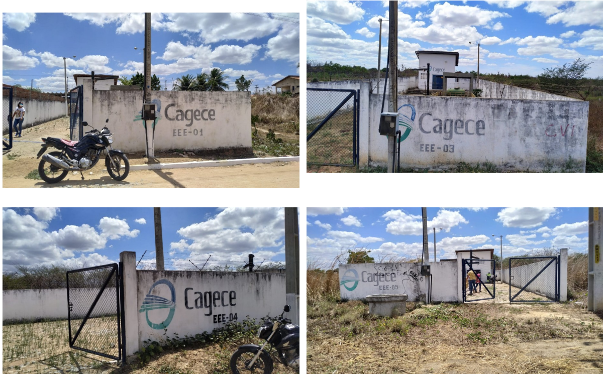
Figura 81: Fachada das Estações elevatórias de esgoto do distrito Croatá.
