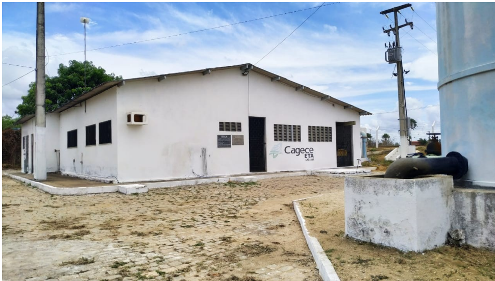
Figura 21: Fachada da ETA Sistema Integrado de Catuana/São Gonçalo do Amarante/Umarituba.
