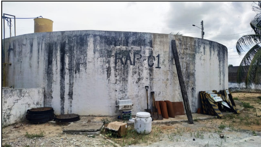
Figura 25: Reservatório apoiado RAP-01.
