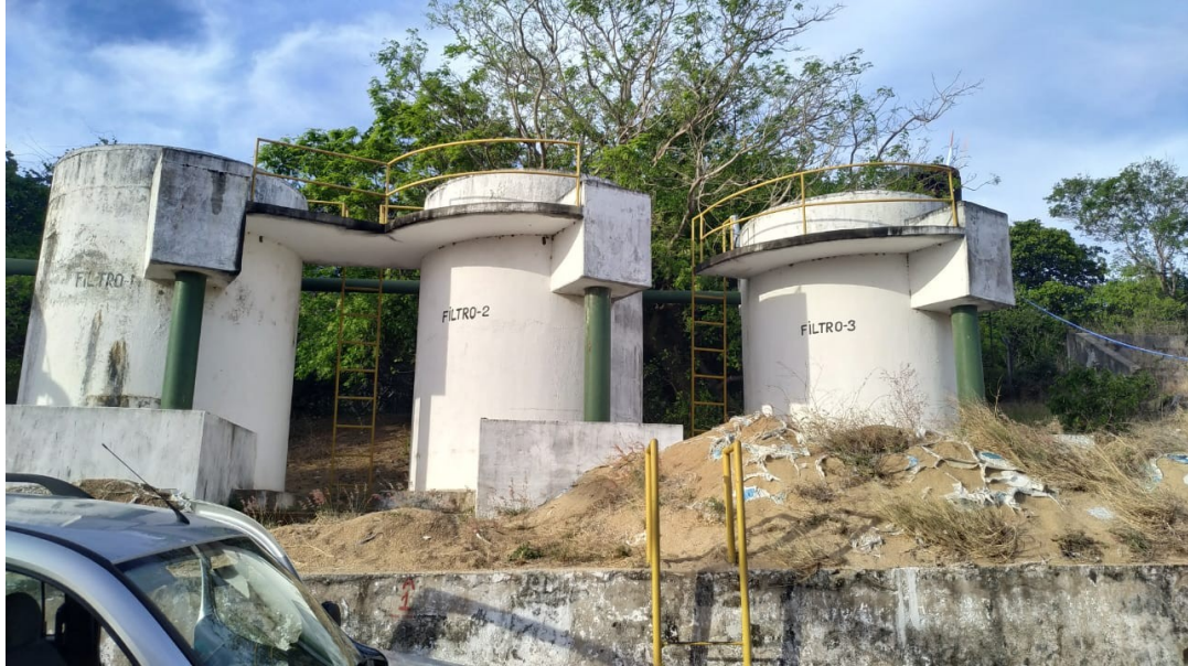
Figura 48: Unidade de filtração de fluxo ascendente.
