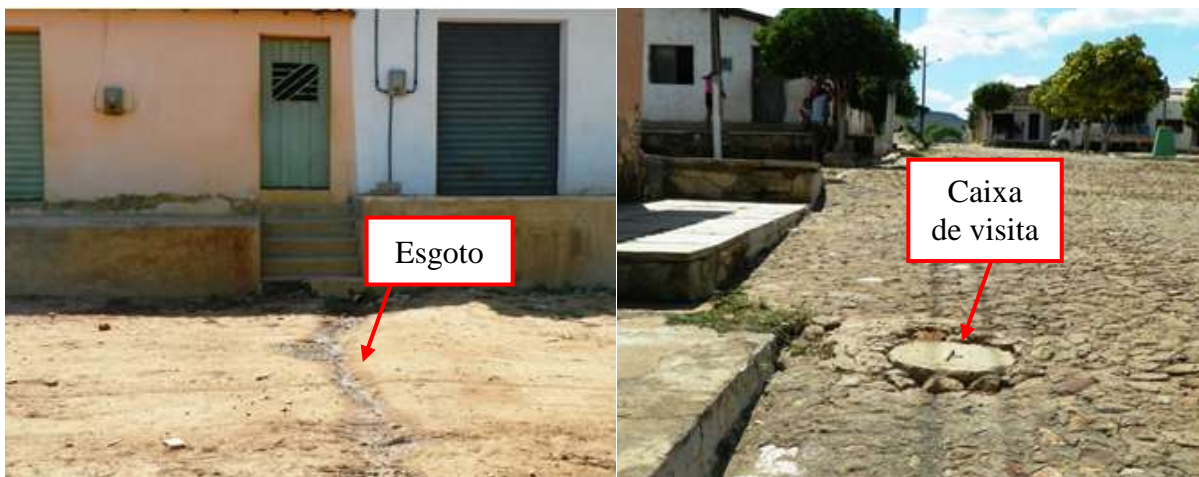
Figura 5.5 – Lançamento de esgoto a céu aberto na Rua Nossa Senhora da Saúde (esquerda) e detalhe de caixa de visita da rede coletora na Rua Tiradentes (direita). Fonte: Consórcio DGH-Cariri (2011).
