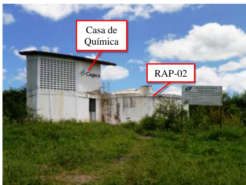
Figura 5.2 – Vista da Unidade de Tratamento de Água do sistema de Santana do Cariri.
