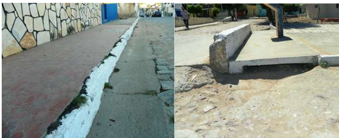
Figura 5.13 – Vista de sarjeta (esquerda) e de boca de lobo (direita) na sede de Santana do Cariri.
