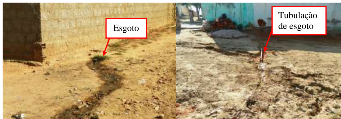
Figura 5.4 – Lançamento de esgoto a céu aberto nas Ruas São Pedro (esquerda) e Santo Antônio (direita).
