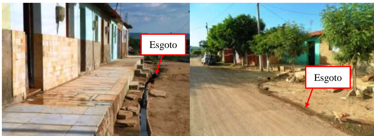
Figura 5.8 – Lançamento de esgoto a céu aberto na Rua Frei Damião (direita) e na Rua Central (direita).
