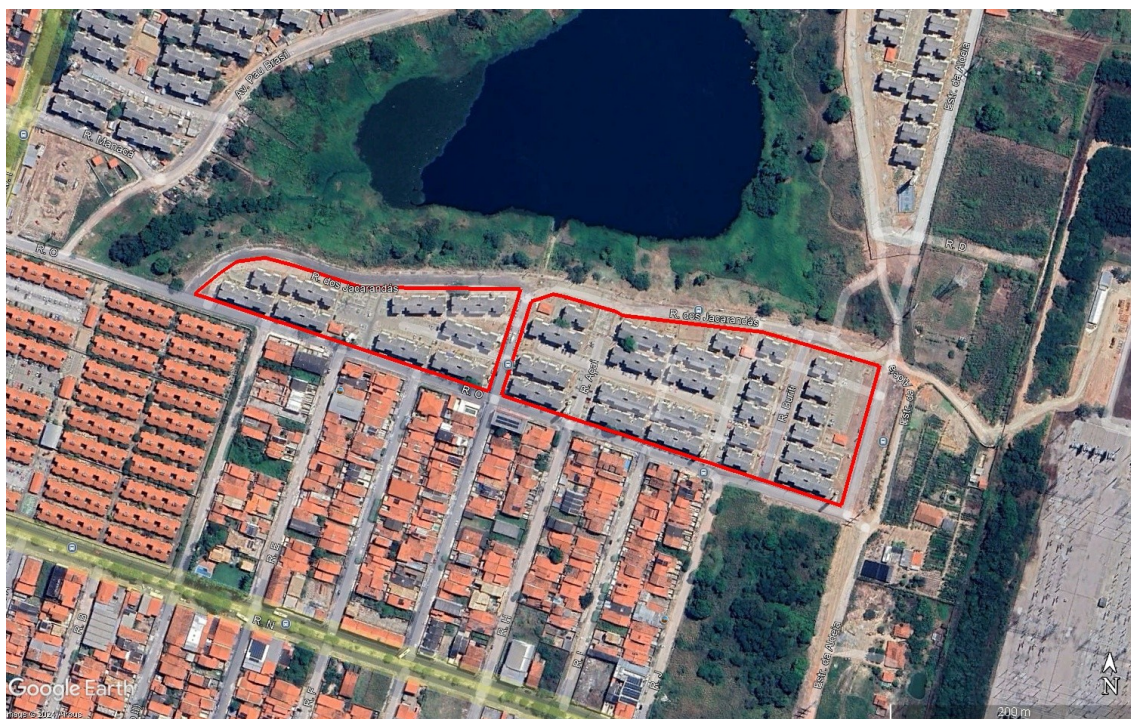
Figura 01 – Imagem de Satélite com delimitação da área do Módulo V do Residencial Cidade Jardim, que será circunscrita pelo gradil. Perímetro 01, formado pela Rua dos Jacarandás e a Rua O; e o Perímetro 02, formado pela Rua dos Jacarandás, a Rua O e a Estrada da Aldeia. Ambos os perímetros totalizam 1.379,00m de Gradil de Proteção do Residencial Cidade Jardim V.
