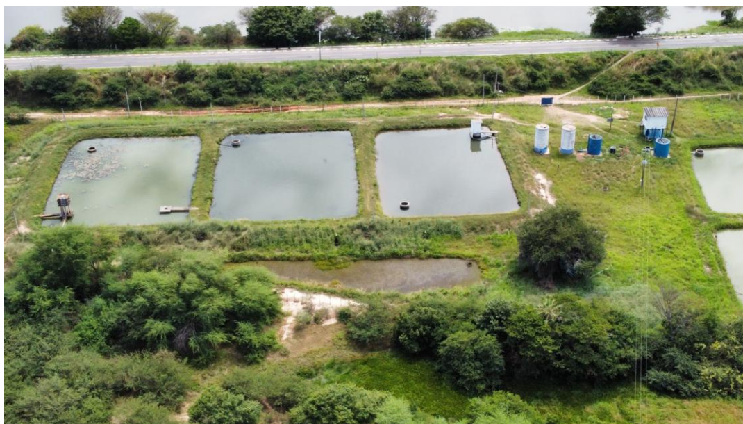
Figura 5.45 – Lagoas para redução do teor de ferro na ETA de Quixelô
