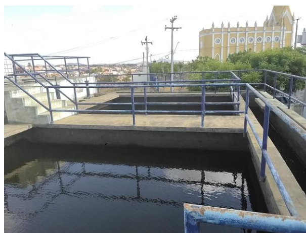
ETA Canindé Antiga, operada pelo SAAE Canindé (Tratamento Convencional)
