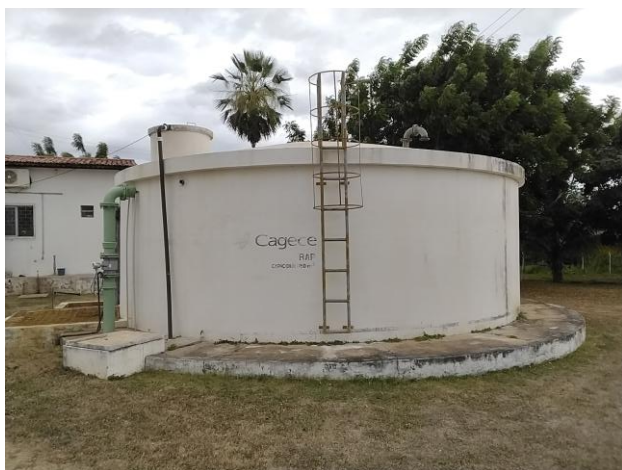
Reservatório apoiado da CAGECE em Quixeré
