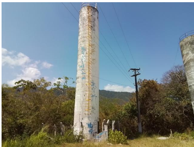
Reservatório elevado do SISAR em Maracanaú
