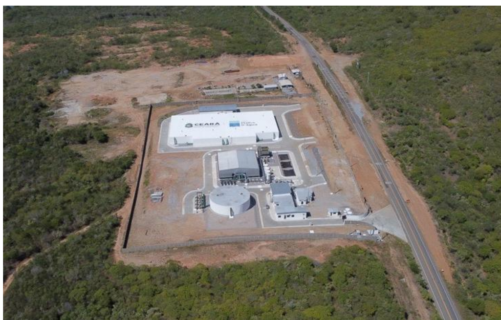
Figura 4.7 – Vista área da ETA do sistema Adutor Banabuiú - Sertão Central
