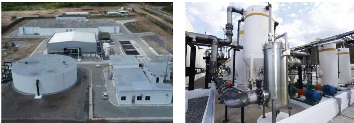
Figura 5.68 – ETA de ultrafiltração do Setor 1 (SAB–SC)
