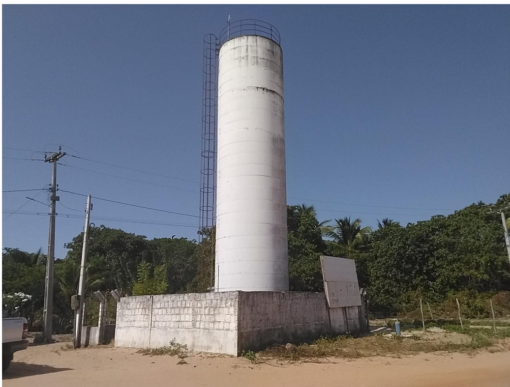
Figura 5.38 – Reservatório elevado na localidade de Mangue Seco em Jijoca de Jericoacoara cuja água é distribuída bruta
