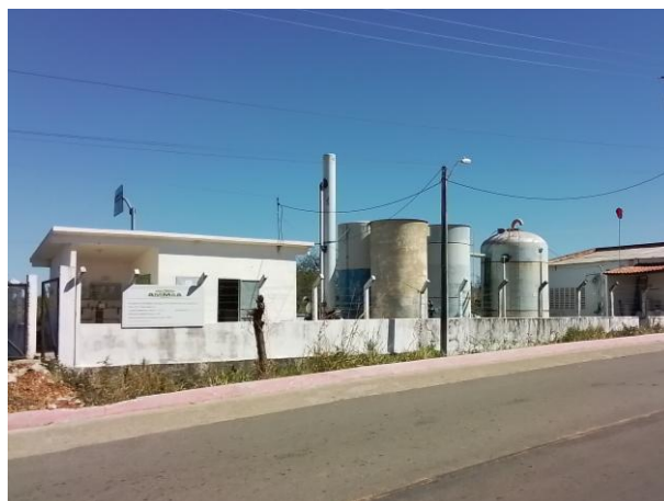
ETA Arneiroz, operada pela CAGECE em Arneiroz (Filtração e Desinfecção)
