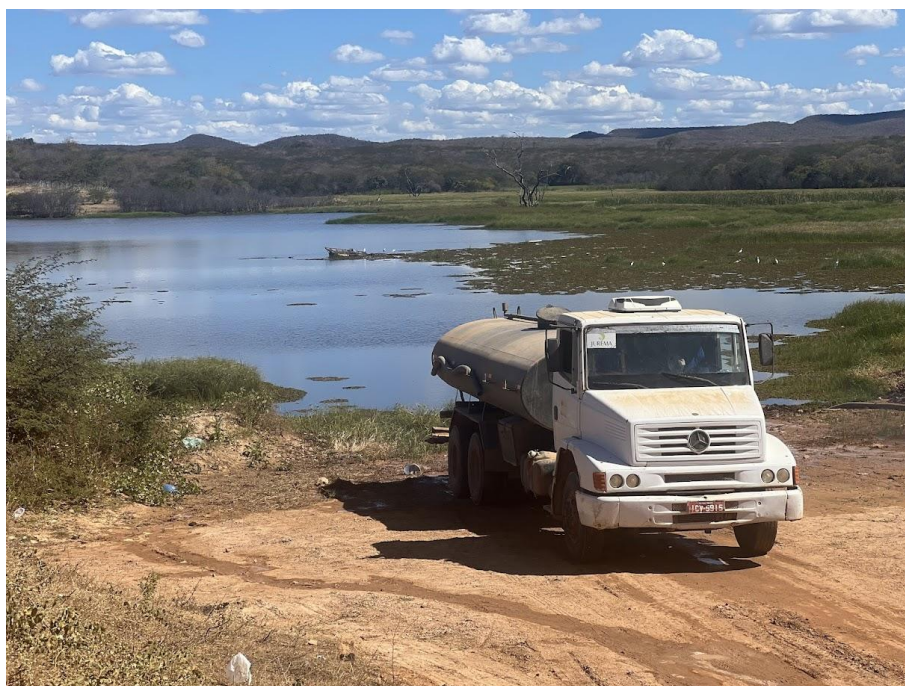
Figura 5.35 – Açude Mulungu para captação de água do SISAR Mulungu em Aiuaba
