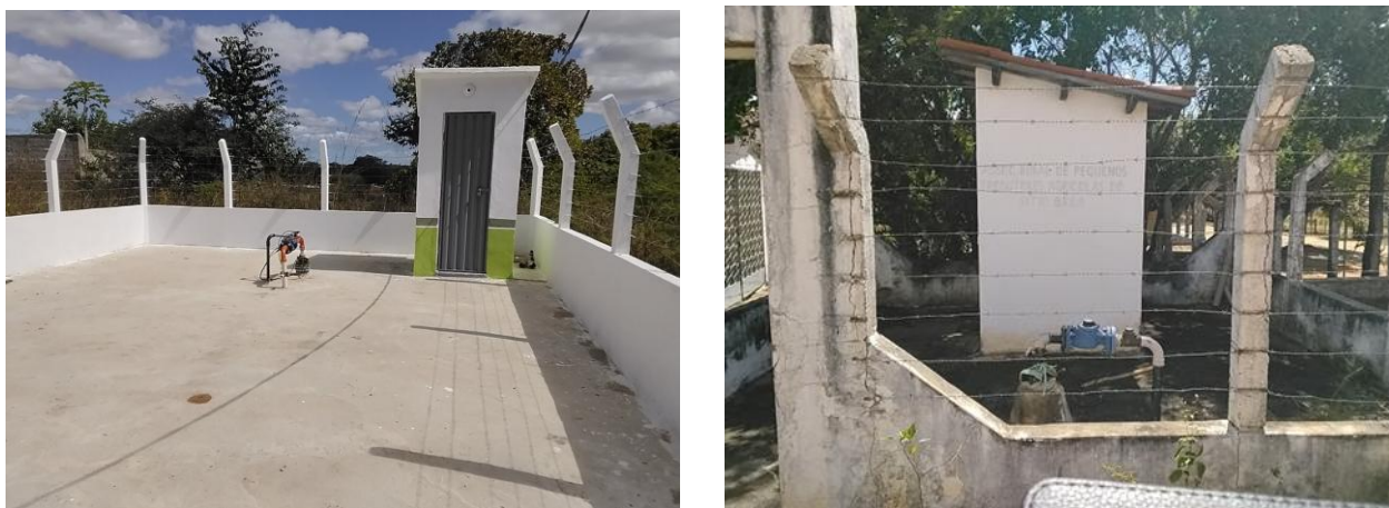
Figura 5.26 – Captações subterrâneas realizadas pelo SISAR na localidade de Gaviãozinho – Juazeiro do Norte (esquerda) e na localidade Sítio Breá – Crato (direita)
